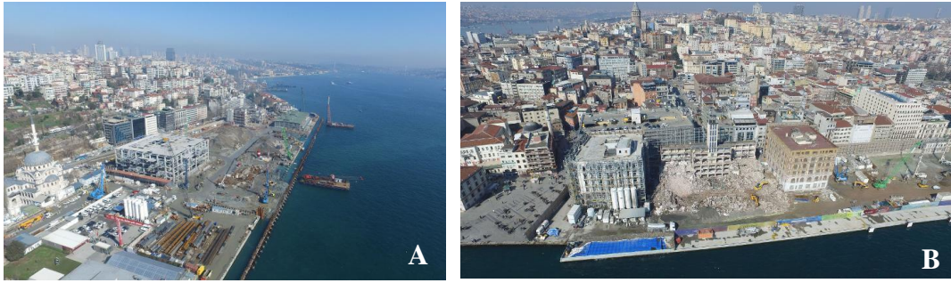
Şekil 3.57. A) Salıpazarı Limanı antrepolarının yıkımı B) Karaköy Yolcu Salonu yıkımı (“Tarihi Karaköy”, 2017)
