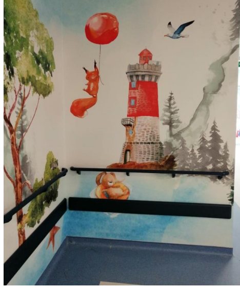
Şekil 2.36. Duvarlarda kullanılan tutunma bandı ve duvar koruma bandı, Ankara Şehir Hastanesi (Arık, 2019)
