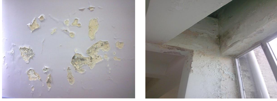
Şekil 2.39. Tesisat, dış iklim koşulları ve nem kaynaklı problemler (H Güler, Şenkal Sezer ve Ülkü, 2010)
