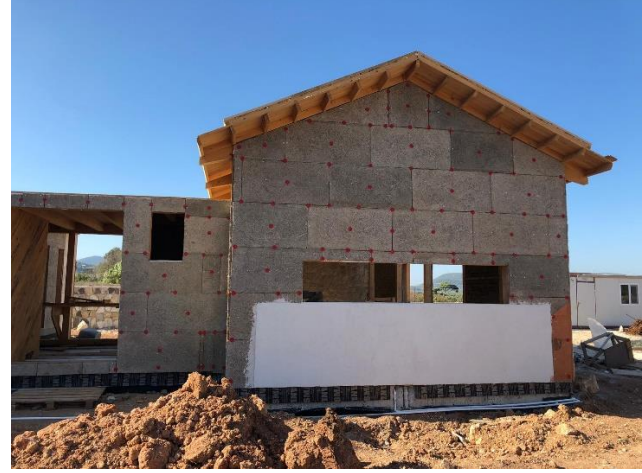
Şekil 2.28. Çimento bağlayıcılı ahşap yalıtım malzemesi (Yazıcı'nın kişisel arşivi)
