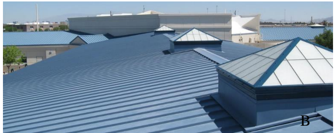
Őekil 2.29. Yapılarda metalin farklı kullanım alanları A) Tařıyıcı sistemde kullanım (Griffiths, 2019) B) atı kaplama malzemesi (“Metal atı Kaplamasında Yalıtım”, t.y.)
