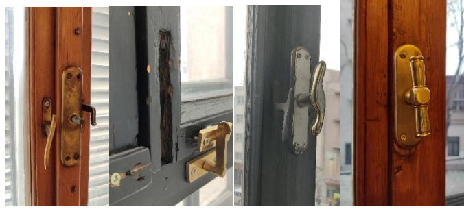
Şekil 4.83. A) B) C) D) Bazı niteliksiz pencere kolları (Baloğlu 2022)
