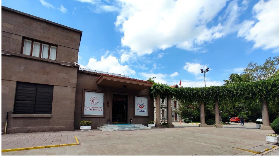
Şekil 4.23. Pano ile kapatılan ve kesilerek tahrip edilen pencereler (Baloğlu 2022)
