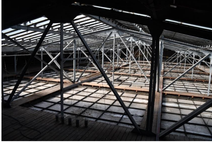
Şekil 4.9. Hol çatısı çelik makas sistemi (Özgür Proje (Mimarlık Danışmanlık İnşaat Ltd. Şti.) 2020)
