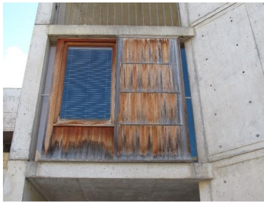
Şekil 2.13. Restorasyon öncesi pencere doğramalarında siyah mantar biyofilmi yakın görünümü (Anonim 2017b)
