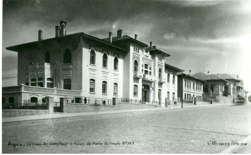
Şekil 4.33. Sayıştay Binası Yenileme öncesi 1925 tarihli fotoğraf 1 (VEKAM Arşivi)
