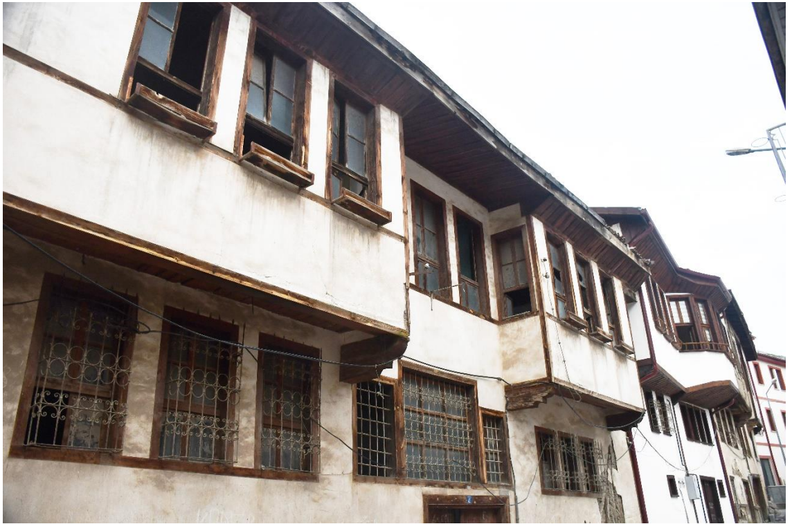
Şekil 3.8. Tokat Bey sokađında bir konak (Özgür Proje (Mimarlık Danışmanlık İnşaat Ltd.Şti.) 2021)
