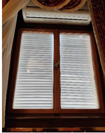
Şekil 4.81. Niteliksiz eklerle pencere bölümlerinin bozulması (Baloğlu 2022)
