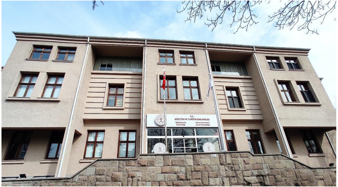
Şekil 4.38. Sayıştay Binası güneybatı cephesi ve niteliksiz cam bölücü detayı (Baloğlu 2022)
