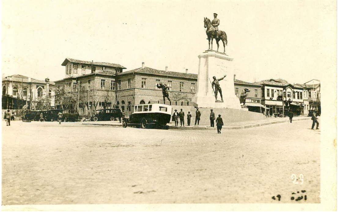
Şekil 2.22. Ulus Meydanı ve Taşhan Binası, 1927 1 (VEKAM Arşivi 2022)
