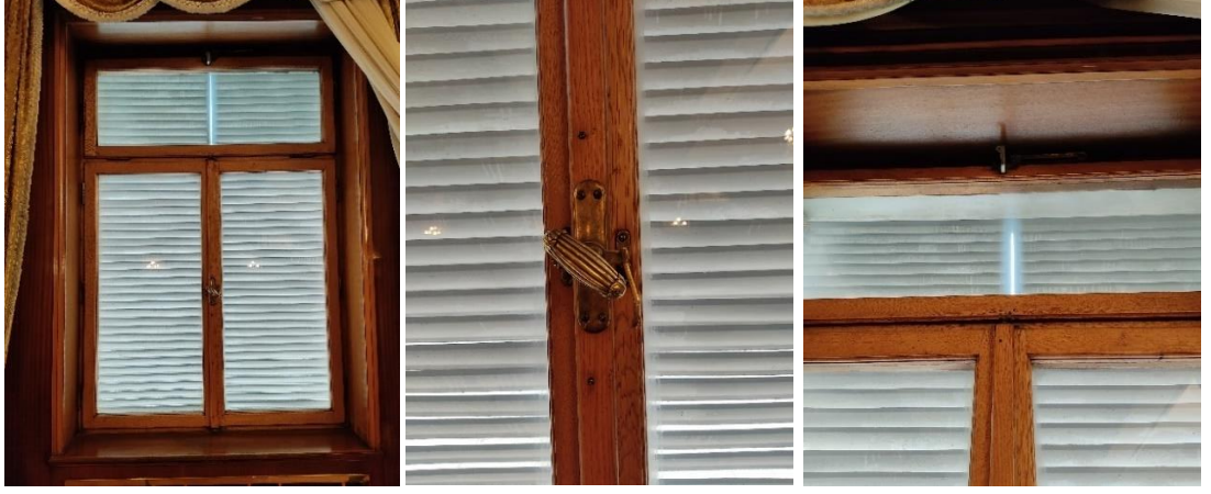
Şekil 4.80. A) B) C) Donanım Elemanlarıyla Özgün Pencere ve Detayları (Baloğlu 2022)
