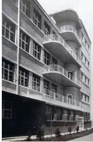
Şekil 4.57. İsmetpaşa Kız Enstitüsü Kuzeybatı cephesi balkon tipolojisi (Anonim 2013)
