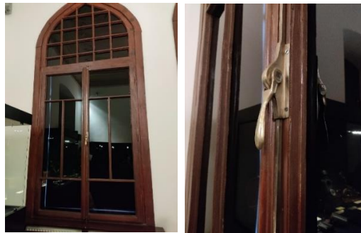
Şekil 4.69. A) Sivri Kemer B) Kürsörlü İspanyolet Kilit Sistemi (Baloğlu 2022)
