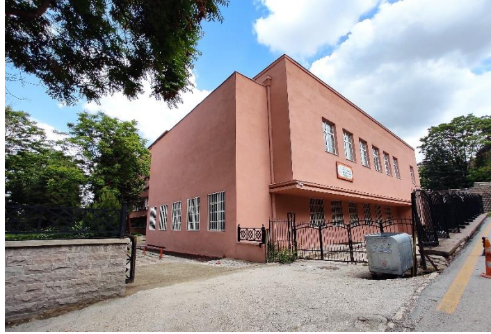
Şekil 4.59. Güney Cephe Ek Yapı Güncel Görünüm (Baloğlu 2022)
