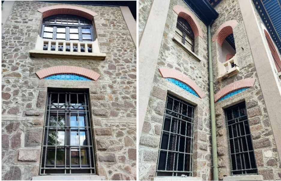
Şekil 4.73. A) II. TBMM Meclisi Sivri Kemer Detayları-1 B)II. TBMM Meclisi Sivri Kemer Detayları-2 (Baloğlu 2022)
