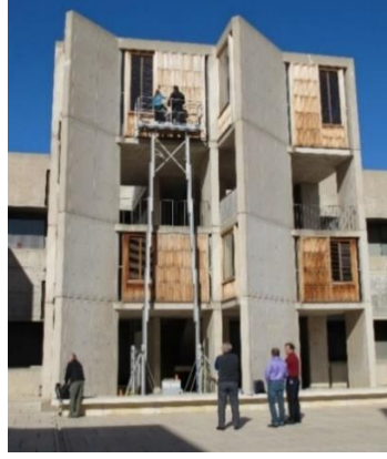
Şekil 2.14. Restorasyon uygulama aşaması (Anonim 2017b)
