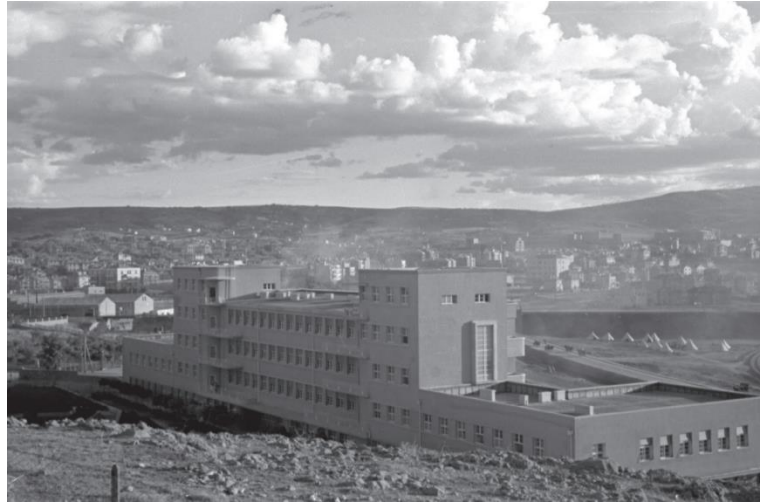
Şekil 4.50. İsmetpaşa Kız Enstitüsü 1934 sonrası arka cepheden (Anonim 2022g)
