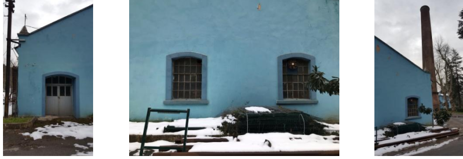
Şekil 4.9. Eski pompalama istasyonunun kuzey cephesi detayları ( Filiz Öztürk, 2022)
