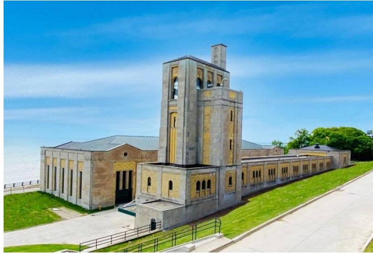
Şekil 2.7. R.C. Harris Arıtma Tesisi hizmet binası, 2021 (Anonim, [tarihsiz]g)
