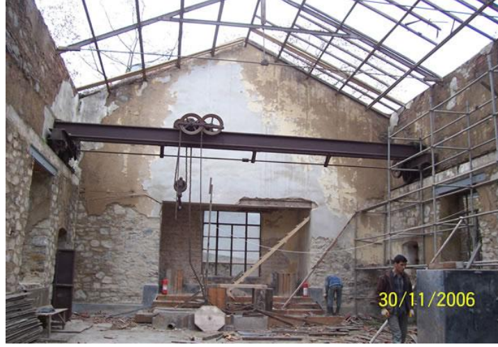
Şekil 2.22. Restorasyon uygulaması sırasında iç mekan (Anonim, 2006)
