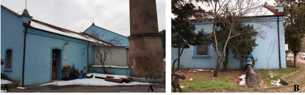
Şekil 4.4. A) Eski kazan dairesi (kaynak ve montaj atölyesi) ve baca tuğla detayı ( Filiz Öztürk, 2022) B) Eski pompalama istasyonu güneybatı köşesi (Filiz Öztürk, 2022)
