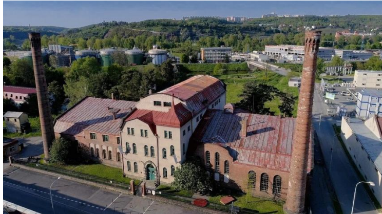
Şekil 2.9. Prag-Bubenec Atık Su Arıtma Tesisi (Anonim, [tarihsiz])
