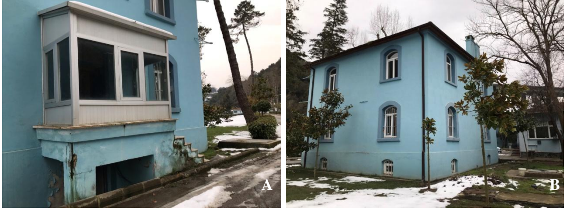
Şekil 4.18. Eski idari bina A) Kuzey cephesi giriş detayı ( Filiz Öztürk, 2022) B) Güneybatı köşesi ( Filiz Öztürk, 2022)
