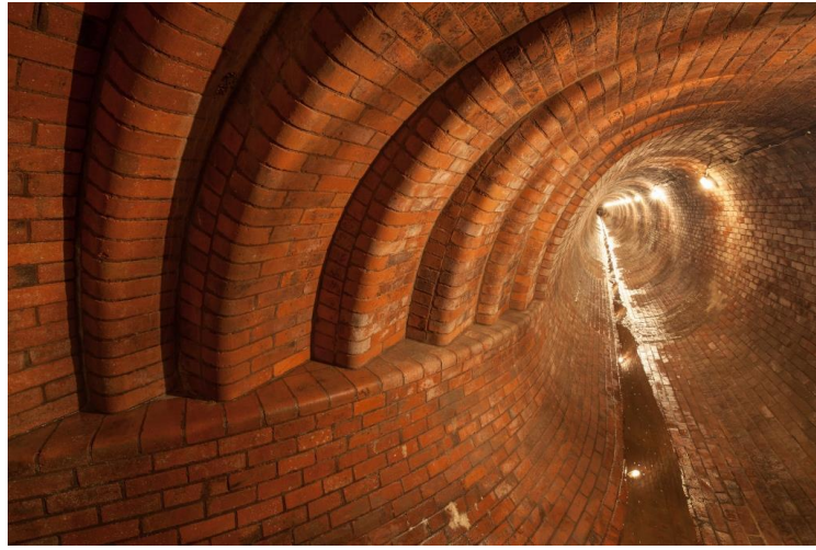
Şekil 2.10. Prag-Bubeneç Atık Su Arıtma Tesisi tuğla altyapı (Anonim, [tarihsiz]j)
