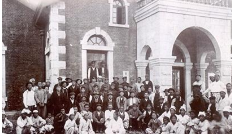
Şekil 2.12. Ttukdo Su Arıtma Tesisi Pompa İstasyonu (Anonim, [tarihsiz]l)
