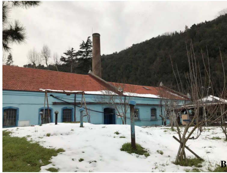
Şekil 4.7. A) Doğu cephesinde yer alan ve 1895 tarihli dergide 500 metreküplük tonozlu depo olarak geçen alan (Kern, 1895) B) Deponun tesiste görülebilen havalandırmaları (Filiz Öztürk, 2022)
