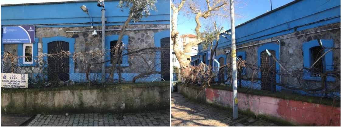
Şekil 4.28. Bağlarbaşı su deposu yapısı kuzey (giriş) cephesi ( Filiz Öztürk, 2022)
