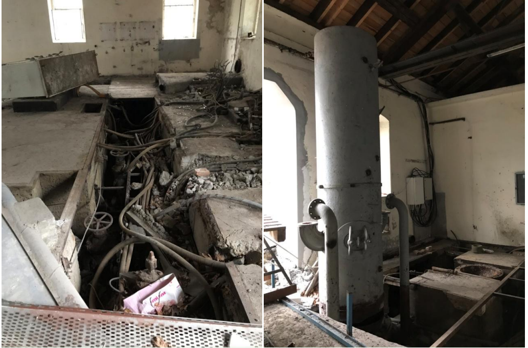
Şekil 4.12. Eski pompalama istasyonu zemin ve tesisat ( Filiz Öztürk, 2020)
