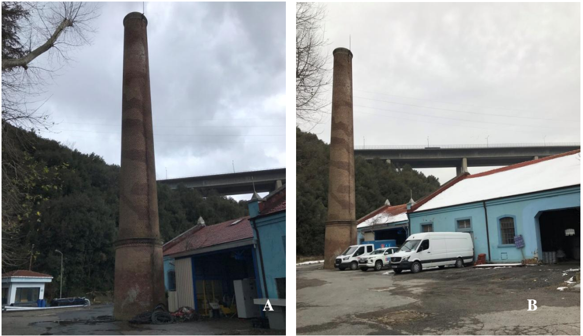
Şekil 4.3.A) Eski pompalama istasyonu bacası (Filiz Öztürk, 2020) B) Eski pompalama istasyonu baca ve yapı ilişkisi (Filiz Öztürk, 2022)
