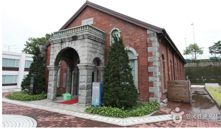
Şekil 2.11. Ttukdo Su Arıtma Tesisi Pompa İstasyonu (Anonim, [tarihsiz]k)
