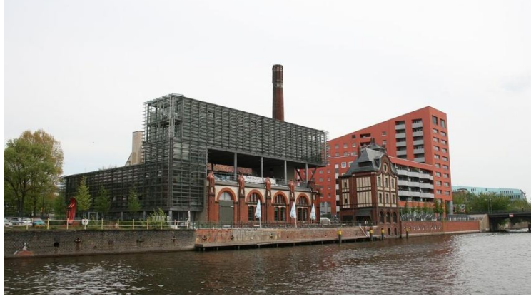
Şekil 2.4. Radialsystem V ve inşa edilen ek bina (Wikipedia Commons, 2008)
