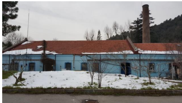
Şekil 4.6. Eski pompalama istasyonu doğu cephesi (Filiz Öztürk, 2022)
