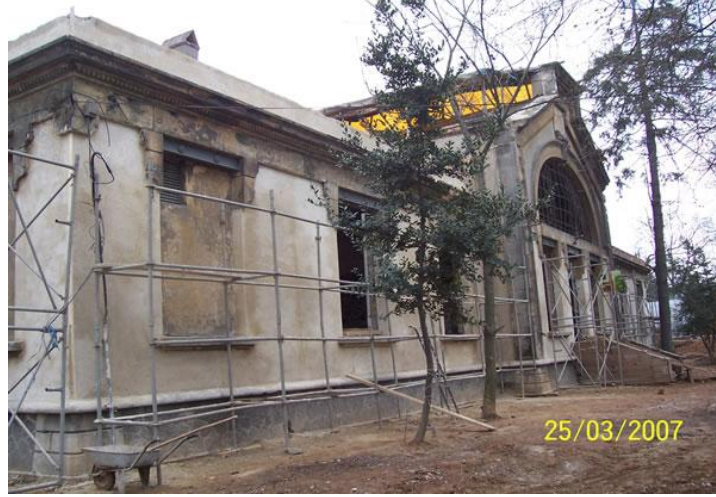
Şekil 2.23. Restorasyon uygulaması sırasında kuzeybatı cephesi (Anonim, 2007)
