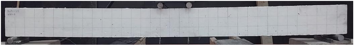
Şekil 4.13 En kesiti 75 mm x 150 mm ( bw/h=1/2 ) ve a/d=6 olan numunede oluşan ilk çatlaklar
