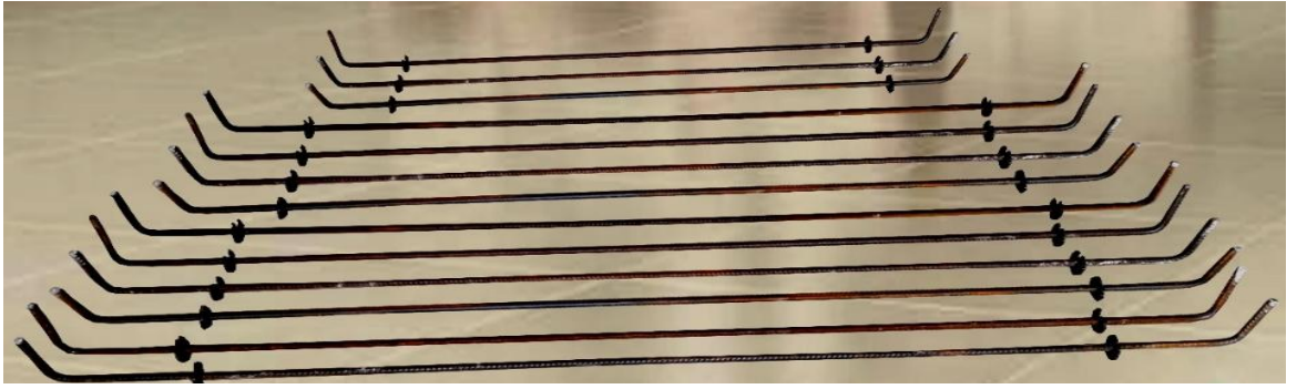
Şekil 3.16. Boyuna donatıların hazırlanması
