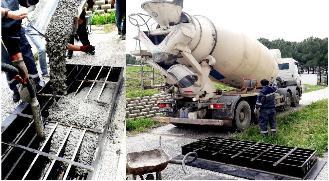
Şekil 3.18. Betonun kalıplara yerleştirilmesi
