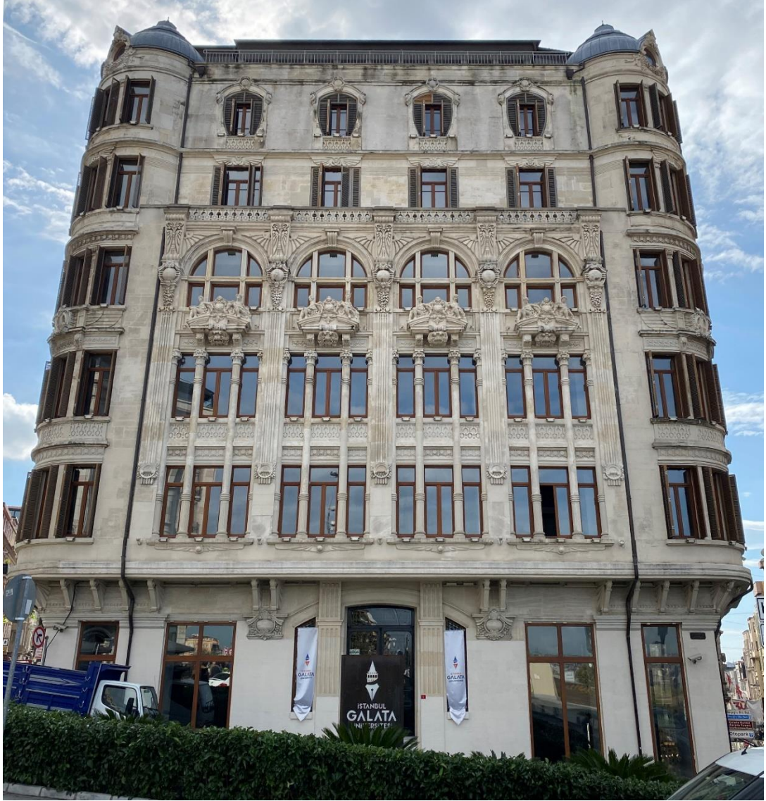
Şekil 3.10. Frej Apartmanının günümüzdeki durumu
