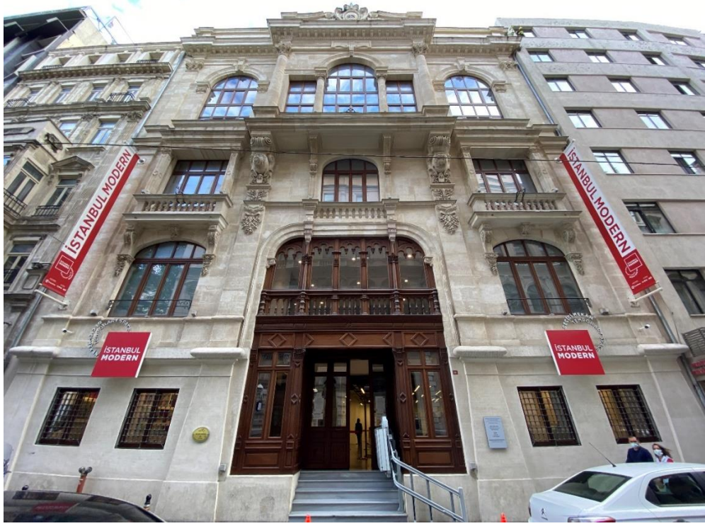
Şekil 3.38. Union Française binasının günümüz durumu
