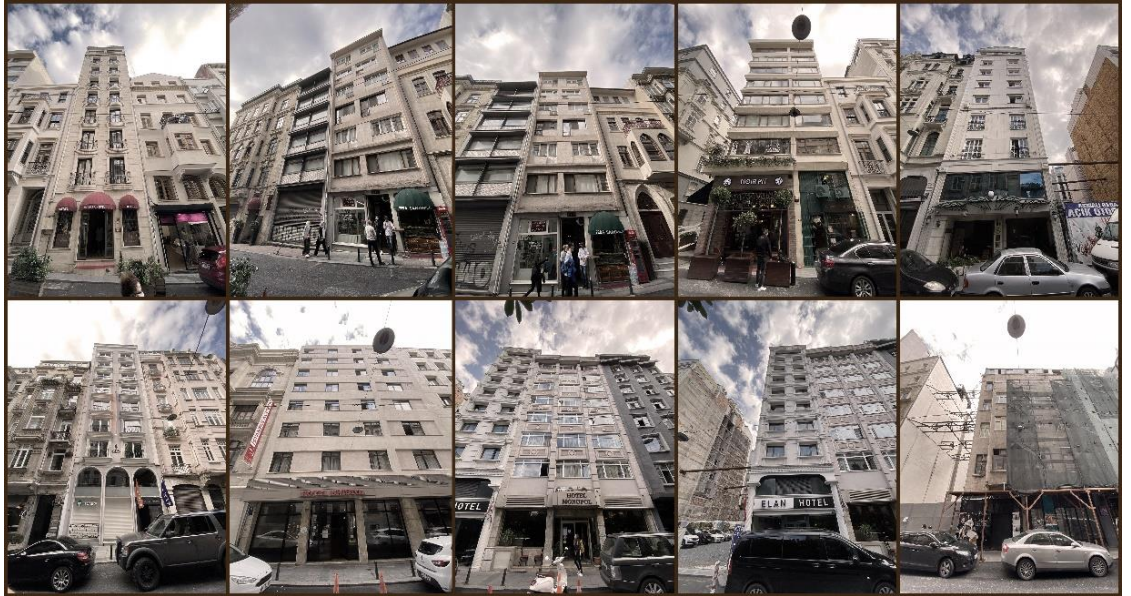
Şekil 4.7. Beyoğlu Belediyesi ve Pera Palas arası betonarme yapılar
