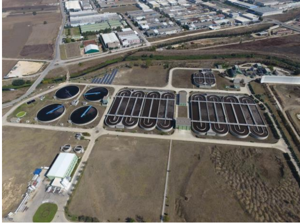
Şekil 3.1. Batı atıksu arıtma tesisi genel görünümü
