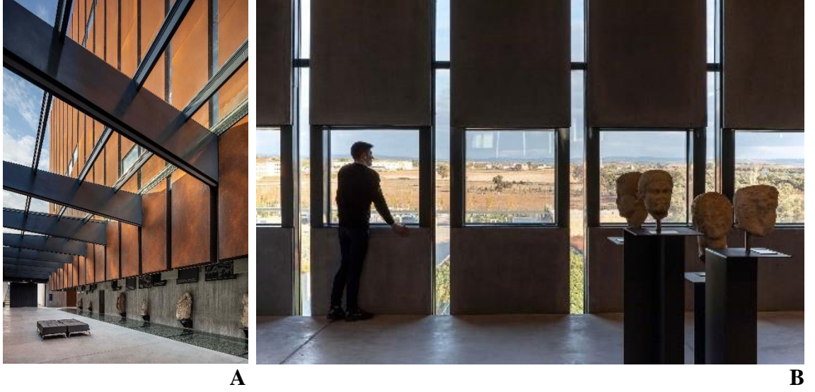
Şekil 3. 12. Troya Müzesi corten çelik paneller arası boşluklar (Kuyrukçu, 2021) A) Corten panellerin dışardan görünüşü B) Corten panellerin içerden görünüşü
