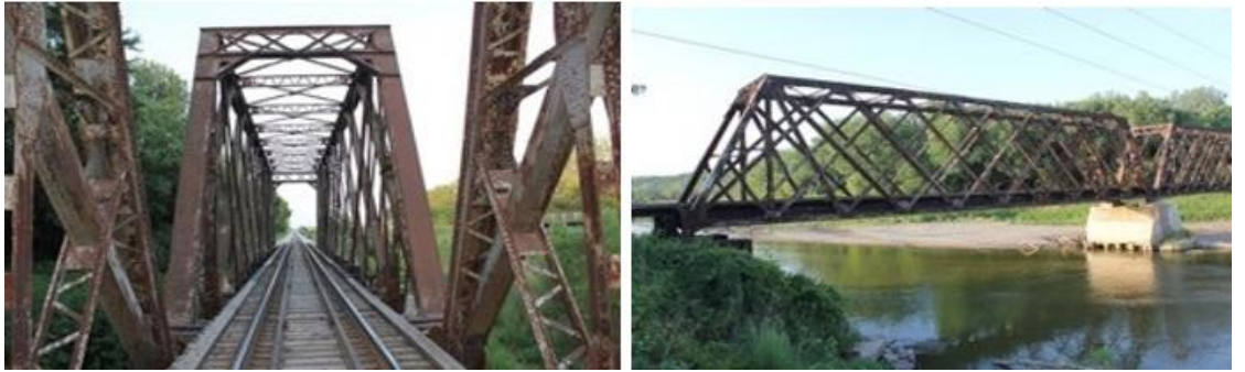
Şekil 2. 15. Raccoon River Köprüsü (Es, 2018)
