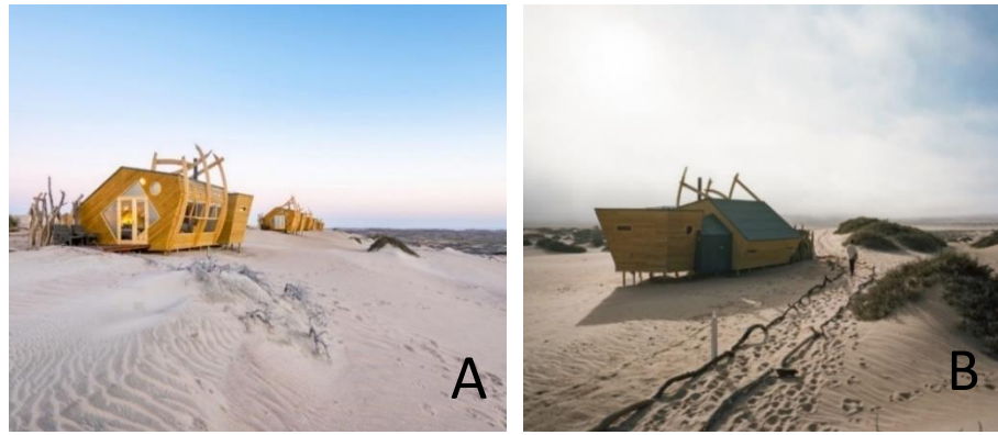
Şekil 2.41. Shipwreck Lodge fotoğrafları A) Ön cephe B) Arka cephe (Anonim, 2021f).
