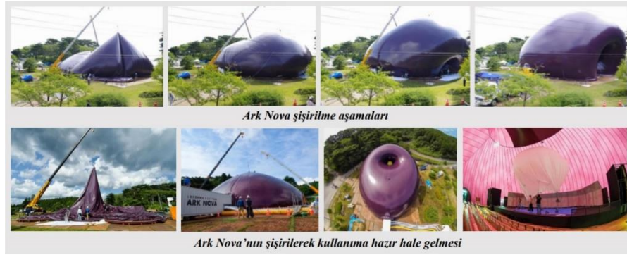
Şekil 3.32. Ark Nova şişirilme aşamaları ve iç mekanı (URL 236, URL 237)
