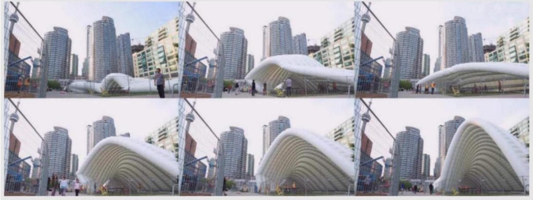
Şekil 3.41. Ontario Pavilion şişme aşamaları (Jungjohann, Woodington, 2016)
