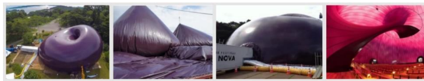
Şekil 3.33. Ark Nova şişirilme aşamaları ve iç mekan tüp yapısı (URL 234)
