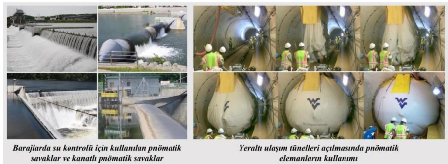
Şekil 3.21. Pnömatik sistemlerin baraj savaklarında ve yeraltı ulaşım tünellerinde kullanımı (Gebhardt, 2019; Martinez, Davalos, Barbero, Sosa, Huebsch, Means, Banta, Thompson, 2012)
