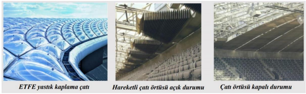
Şekil 3.45. Münich Allianz Arena pnömatrik çatı sistemi ve açılıp kapanabilen güneş koruyucu tenteler (URL 241; Gonçaves, 2017)
