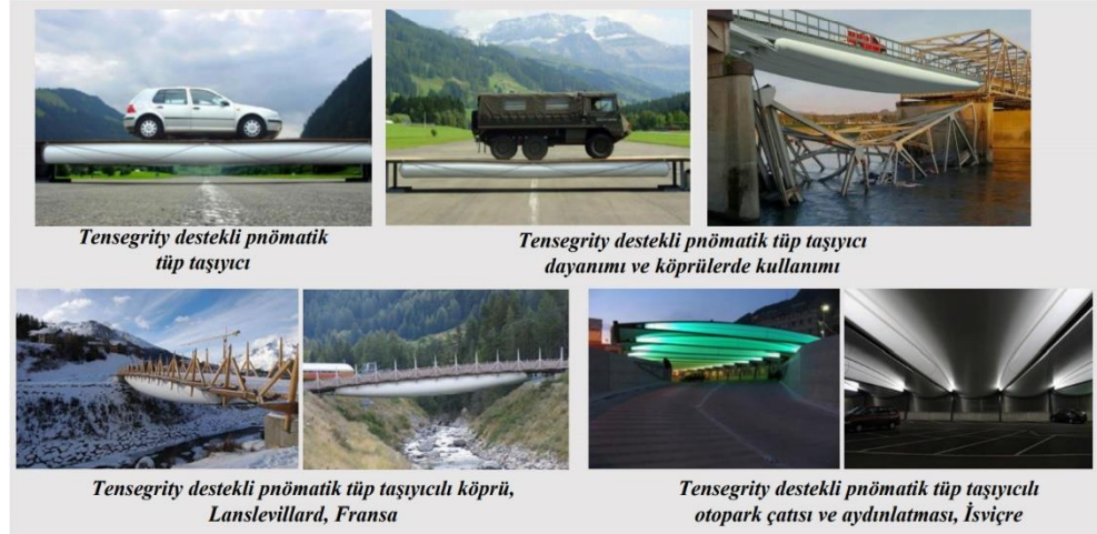
Şekil 3.27. Pnömatik tüplü tensegrity sistemlerin köprü ve çatıda uygulama örnekleri (URL 228, URL 229; Lunchsinger, Pedretti, Reinhard, 2004 s. 141-148)
