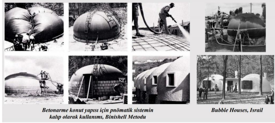
Şekil 3.20. Pnömatik sistemlerin kalıp olarak kullanımı (URL 218; Heifetz, 1972)
