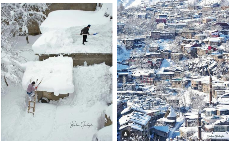
Şekil 3.38. Geleneksel Bitlis Evlerinde düz toprak damların kış mevsimindeki halleri ve temizleme yöntemleri (BG arşivinden alınmıştır)
