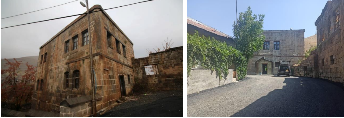
Şekil 4.24. Yapıya eklenti duvarın kaldırılmadan önceki ve sonraki hali
