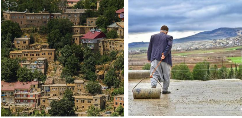
Şekil 3.37. Geleneksel Bitlis Evlerinde düz toprak dam (BG arşivinden alınmıştır)
