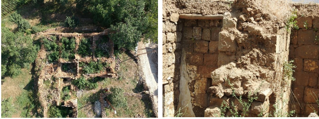
Şekil 3.30. Geleneksel Bitlis Evlerinde duvar ve sıva örnekleri (BÇ arşivinden alınmıştır)
