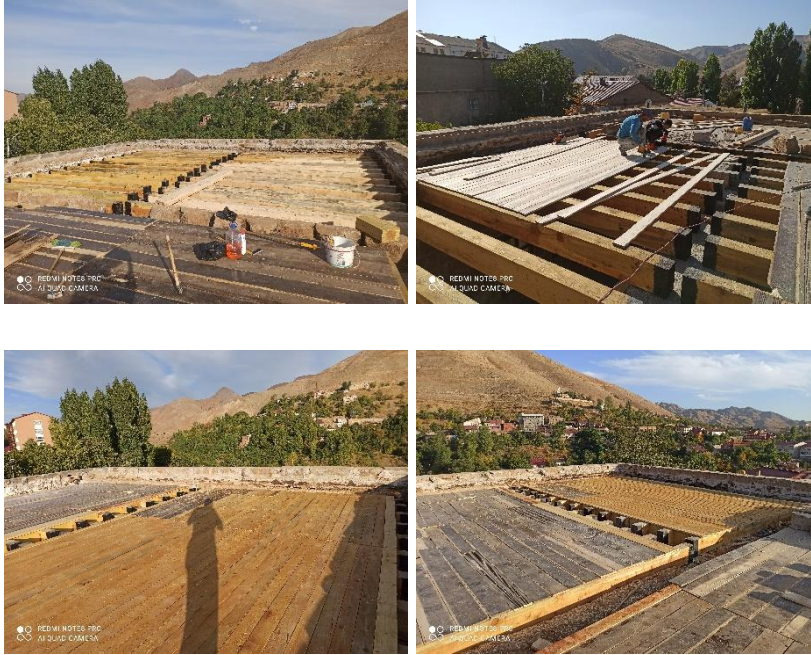
Şekil 4.37. FSBKE çatı ahşap planı aşama 3 detayı şantiye uygulama fotoları
