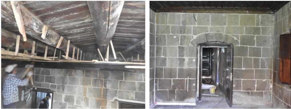
Şekil 4.6. Zemin kat keran döşeme ve niş detayları
