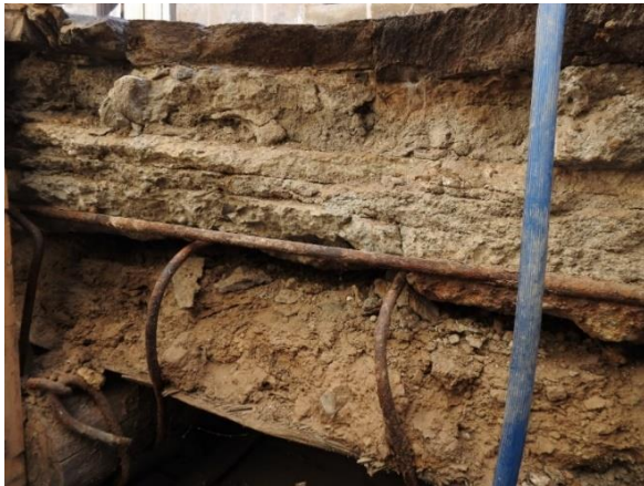
Şekil 4.15. Döşemelerde kullanılan beton tabakası (Şimşek, 2020)
