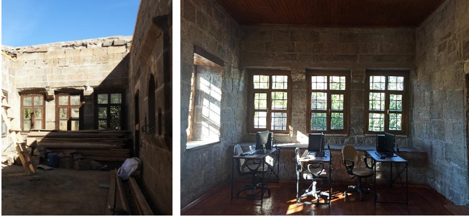
Şekil 4.50. FSBKE restorasyonu pencere üstü kırık alanların imitasyon yapılması
