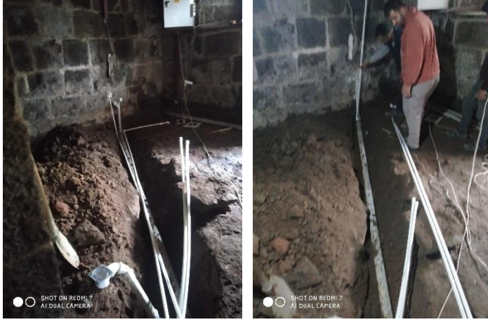
Şekil 4.63. Alt yapı bağlantı kanalları
