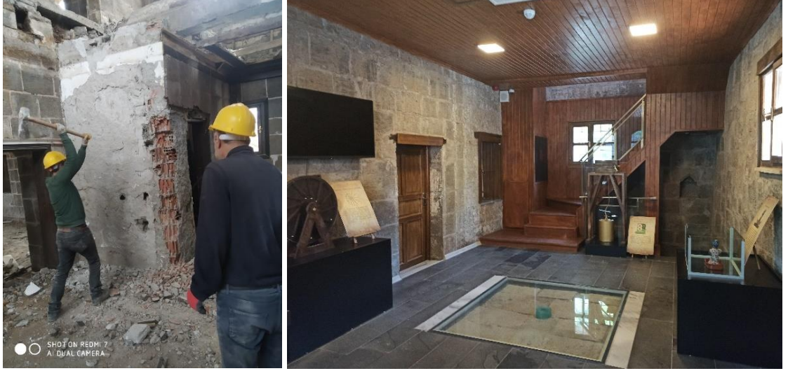
Şekil 4.22. Restorasyonda önceden eklenen mutfak ve tuvalet eklentilerinin kaldırılması
