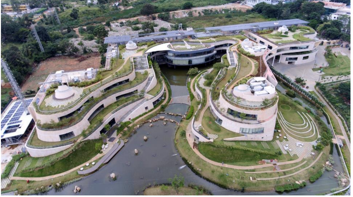
Şekil 2.8. Hindistan/ Titan da bir şirket binası (Anonim, 2017a)
