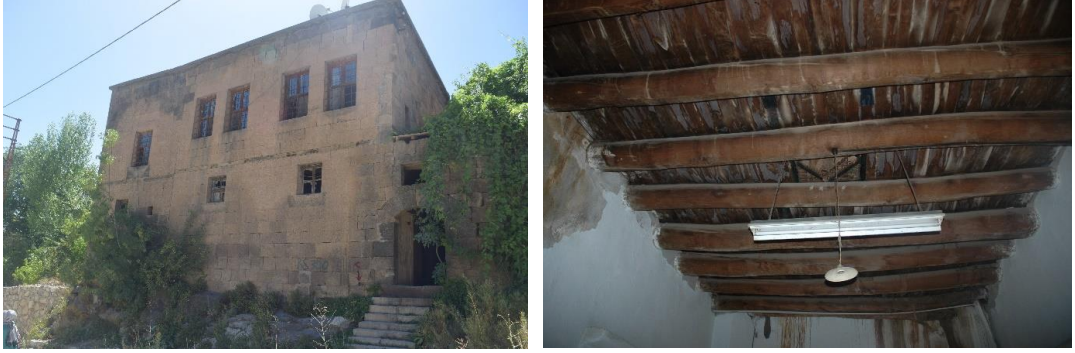
Şekil 3.46. Geleneksel Bitlis Evlerinde ahşap kullanımı (BÇ arşivinden alınmıştır)
