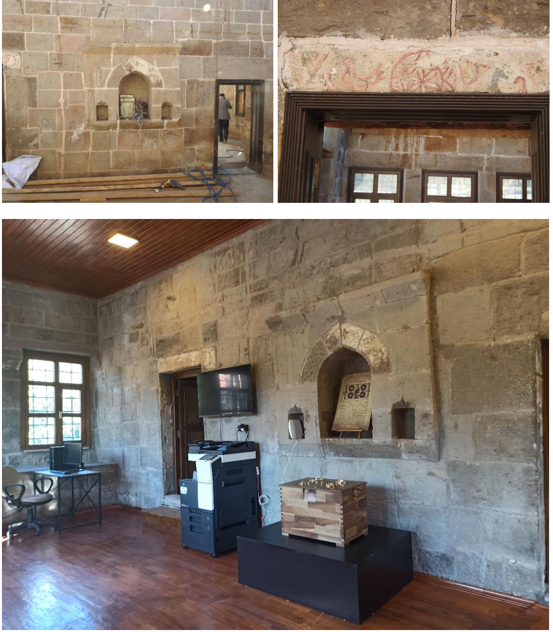
Şekil 4.60. Birinci kat sergi mekanında bulunan inanç nişi ve süslemenin onarılması
