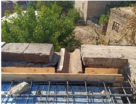
Şekil 4.41. FSBKE çatı yağmur olukları ve meyil betonun döşenmesi aşama 4 detayı şantiye uygulama fotoları
