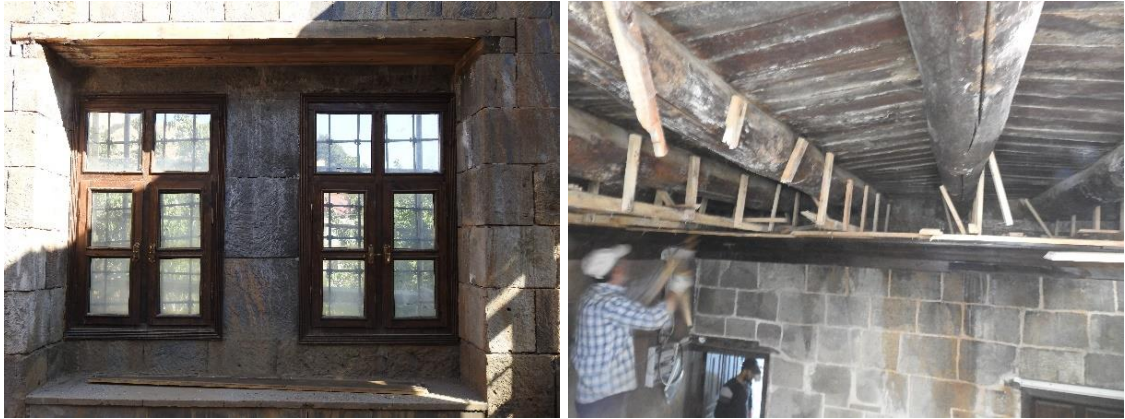
Şekil 4.12. Konağın yapım malzemeleri ve ahşap keran
