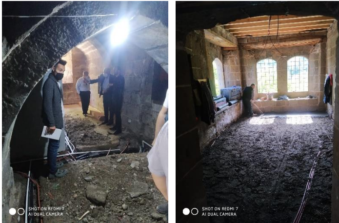
Şekil 4.64. Mekanik bağlantı kanalları
