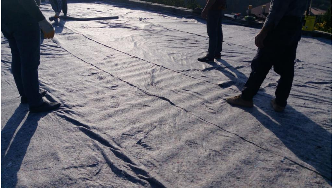
Şekil 4.46. FSBKE çatı drenaj levhası üzerine keçe serilmesi aşama 4 detayı şantiye uygulama fotoları
