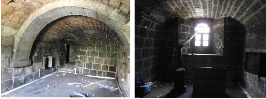
Şekil 4. 5. Bodrum kat tonoz detayları (Çapras, 2020)
