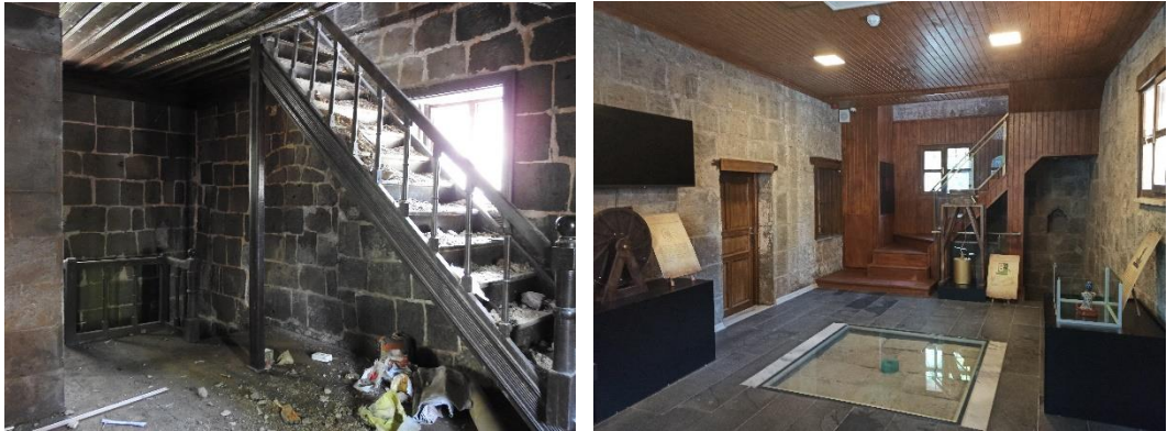
Şekil 4.23. Zemin kat merdivenin sökülüp plan düzleminde yerinin değiştirilmesi öncesi ve sonrası
