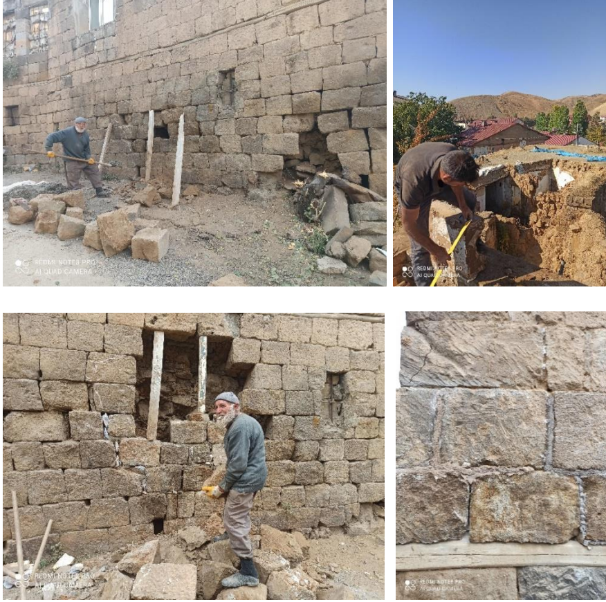
Şekil 4.66. Küfeki taşı onarımı ve derzinin yapılması
