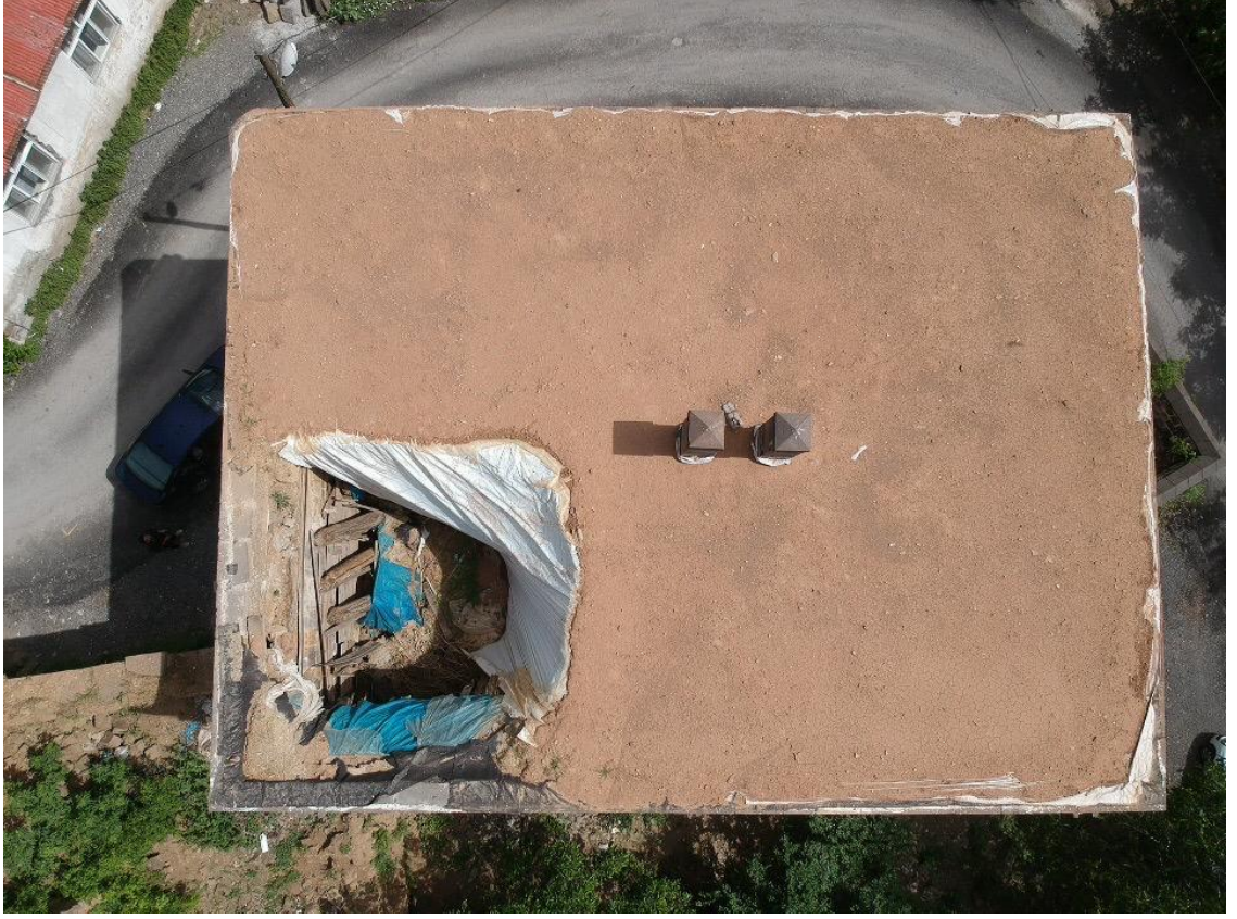
Şekil 4.31. FSBKE Restorasyon öncesi mevcut dam durumu (Çapras 2020)
