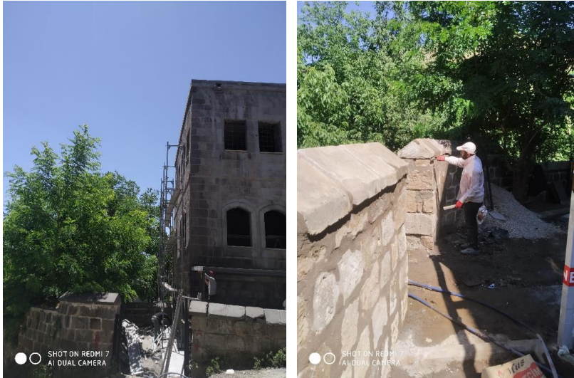
Şekil 4.51. FSBKE restorasyonu bahçe taş duvarların derz ve harpuştanın onarılması
