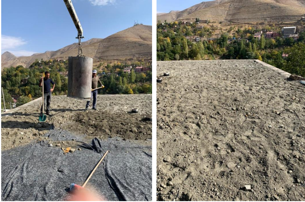
Şekil 4.48. FSBKE çatı düz dam toprak dökme detayı aşama 6 detayı şantiye uygulama fotoları
