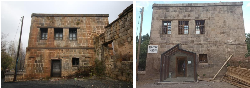
Şekil 4.25. Zemin kat girişinin ilk hali ve şeffaf sundurma eklendikten sonraki son hali
