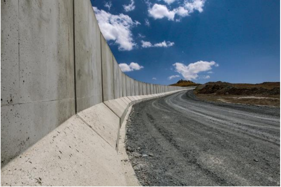
Görsel 2: Türkiye'nin İran Sınırına Yaptığı Beton Duvar (Kaynak: URL-7).
