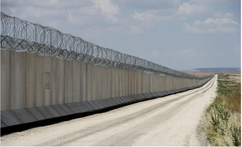
Görsel 1: Türkiye'nin Suriye Sınırına İnşa Ettiği Beton Duvar (Kaynak: URL-6).
