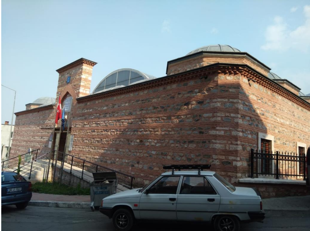
Hançerli Medresesi'nin güney batı cephesi.
