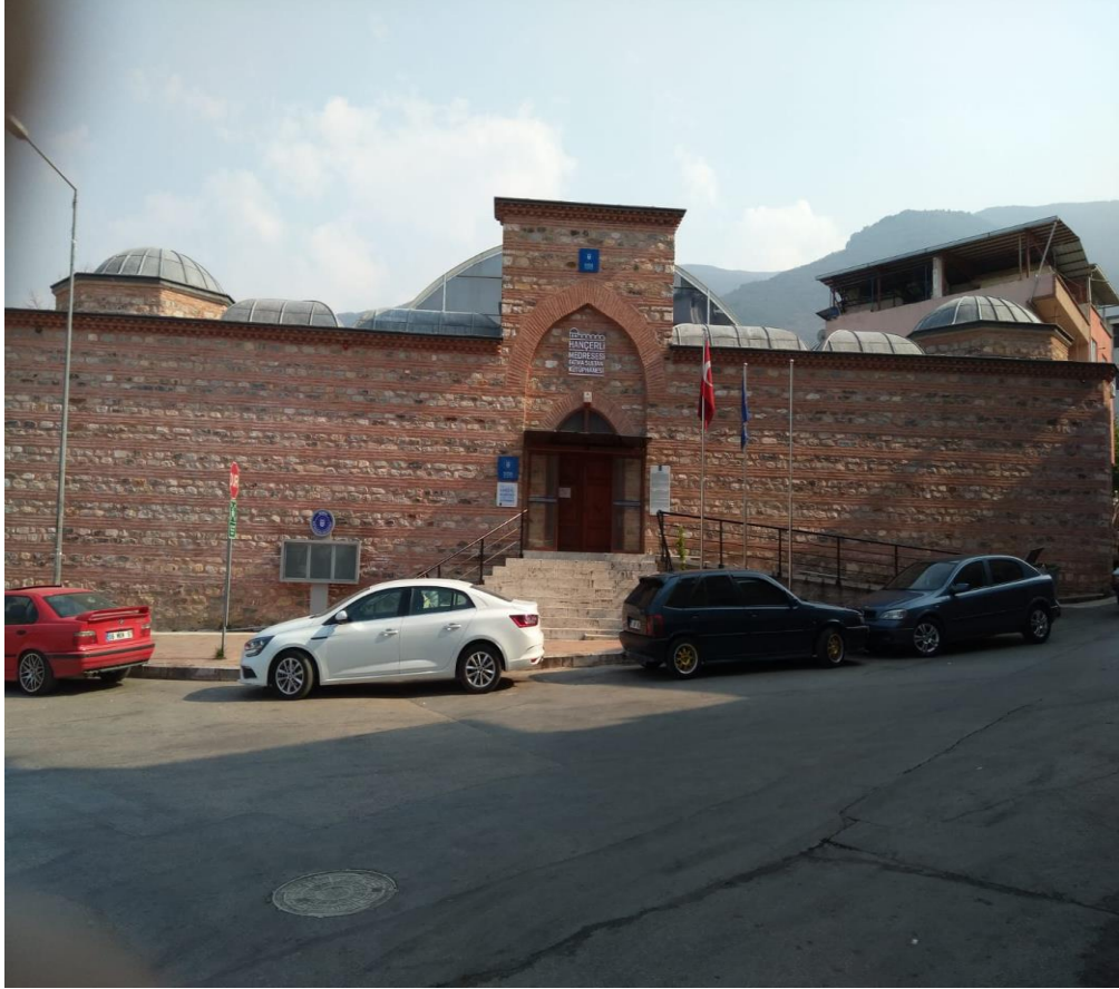
Hançerli Medresesi'nin güney cephesi ve girişi.
