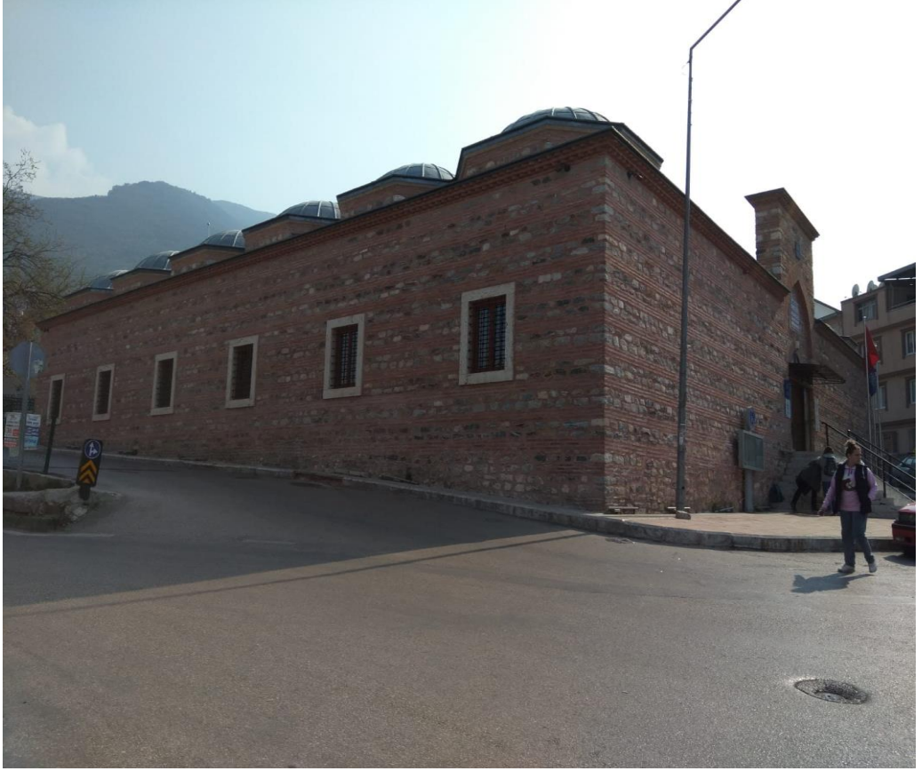
Hançerli Medresesi'nin Doğu Cephesi.
