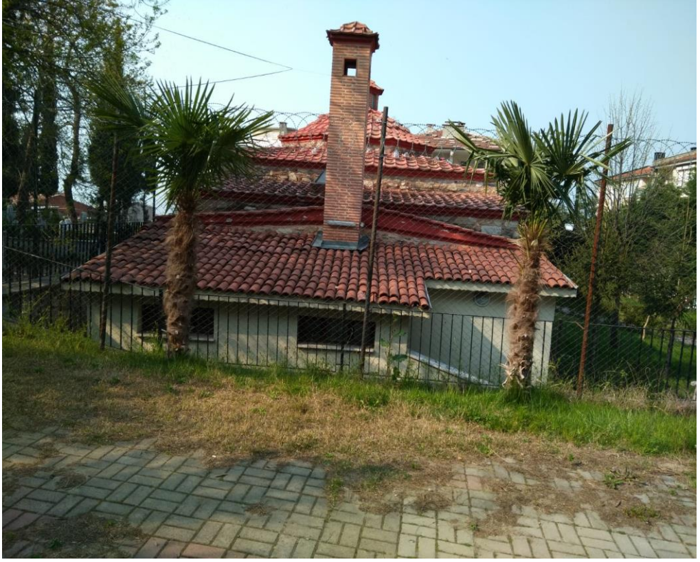
Hançerli Hamamı'nın Güney Cephesi.
