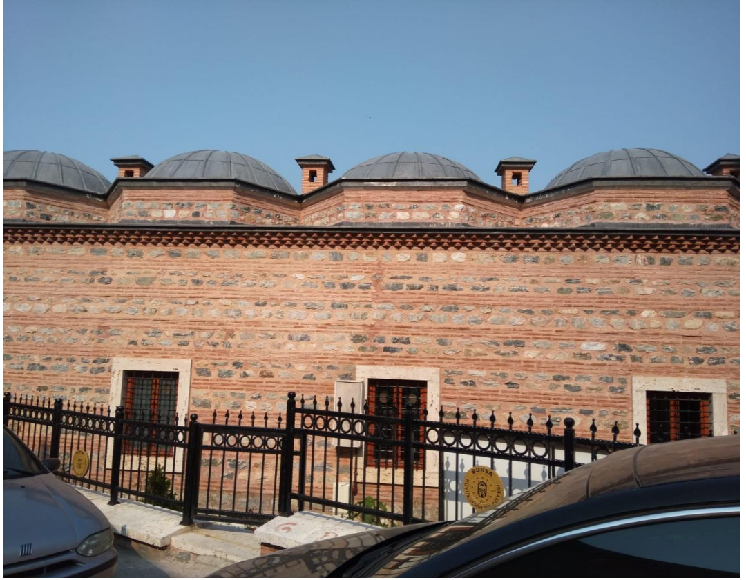
Hançerli Medresesi'nin Batı Cephesi.
