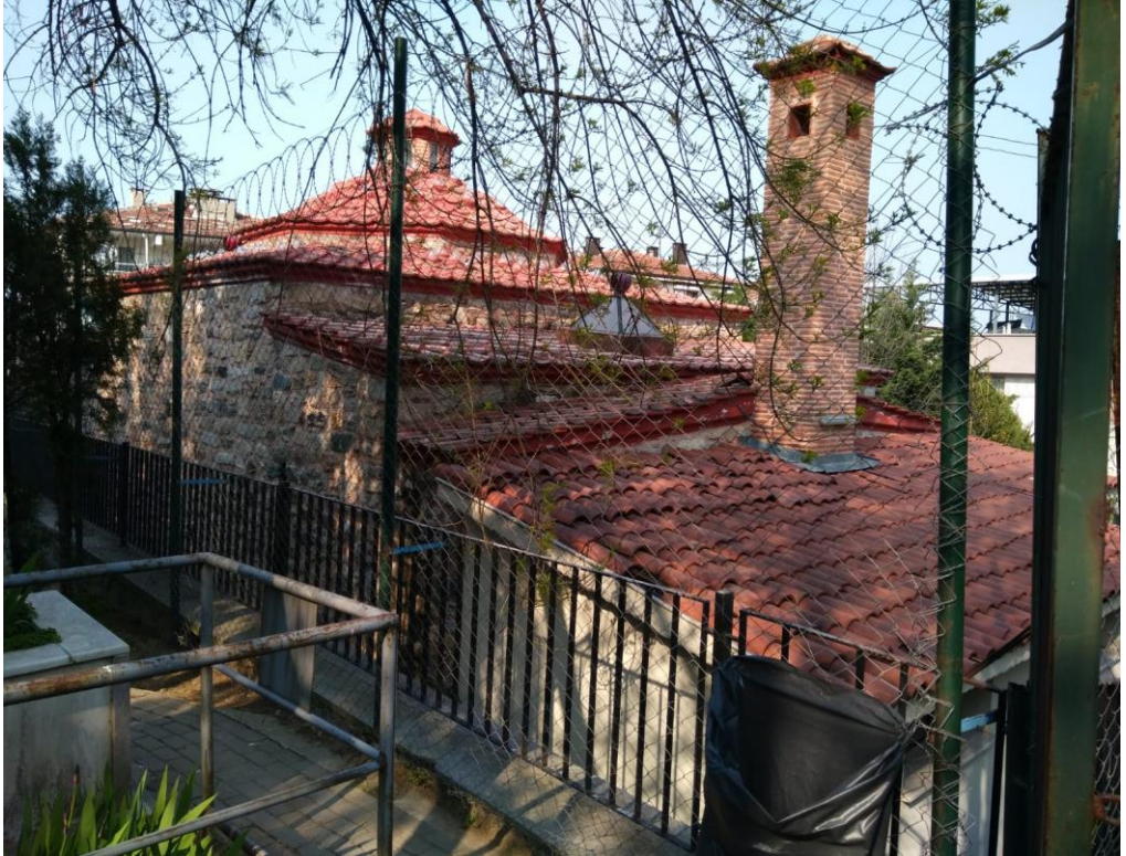
Hançerli Hamamı'nın Batı Cephesi.
