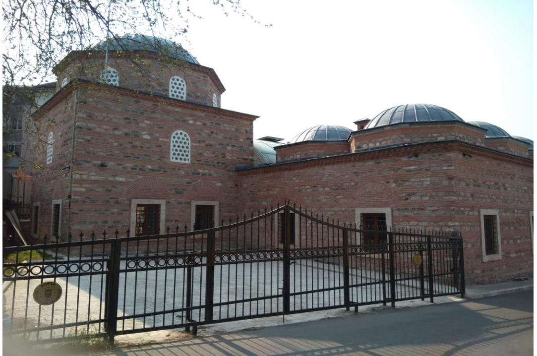
Hançerli Medresesi'nin Kuzey Cephesi.
