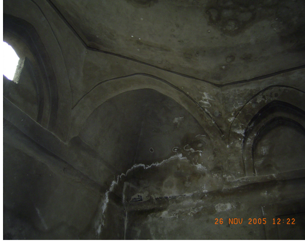
Şekil 3.5 Kubbeye geçişi sağlayan tromplar
