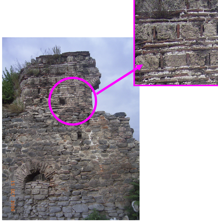
Şekil 3.7 Erkekler soyunmalık güney cephesinin bir sıra taş, üç sıra tuğla ile örülmesi
