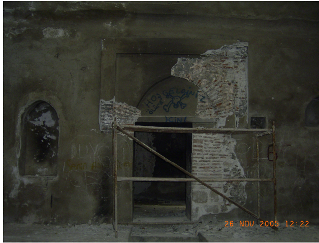
Şekil 3.6 Soğukluktan ılıklığa geçişi sağlayan iki basamakla çıkılan kapı
