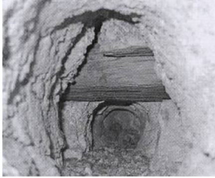
Şekil 2.13 Duvarın içinde bulunan ahşap eleman (Panagia Krina kilisesi, fotoğraf E.Vintzileou)
