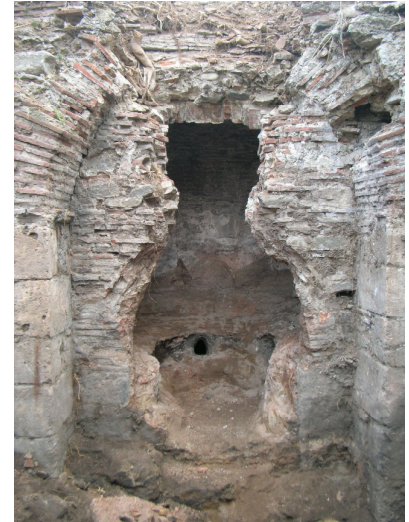
Şekil 3.21 Su deposunda bulunan kazan izi ve duman kanalları
