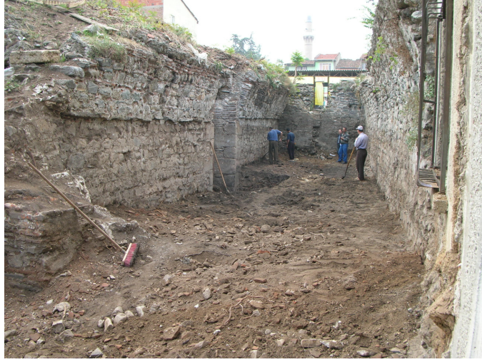
Şekil 3.22 Külhanın yıkık durumda bulunan tonoz örtülü üst örtüsü
