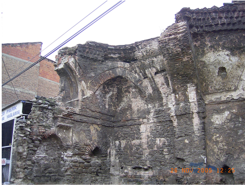
Şekil 3.14 Erkekler soyunmalıkta yıkık duvarlar
