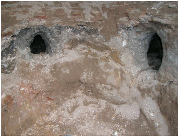
Şekil 3.20 Cehennemlikte bulunan duman kanalları
