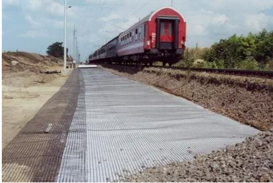
Şekil 2.3. Jeotekstilere örnek: Tren yolu altında uygulama (Anonim, 2020b).
