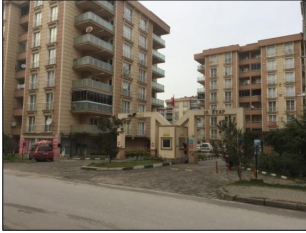
Şekil 5.16. Millet Mahallesi’nde kapalı konut sitelesinin güvenlik sistemi ( Kişisel Arşiv)
