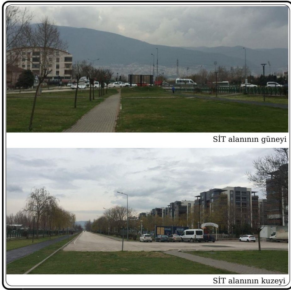
Şekil 5.1. Millet Mahallesi’ndeki kentsel Sit alanının güneyi ( Kişisel Arşiv)
