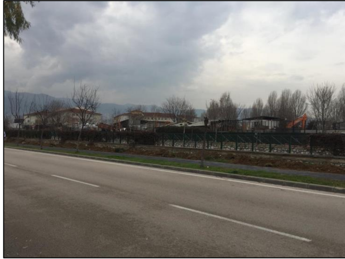
Şekil 4.5. Millet Mahallesi'nin batısında bulunan Osmangazi Hurdacılar ve Geri Dönüşümcüler Sitesi ( Kişisel Arşiv)
