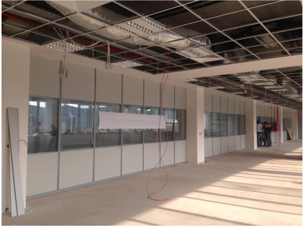
Şekil 4.12. Bosch Fren Sistemleri Fabrikası ofis ve sosyal alanların yer aldığı kısımda asma tavan uygulaması (Kaymaz 2014)
