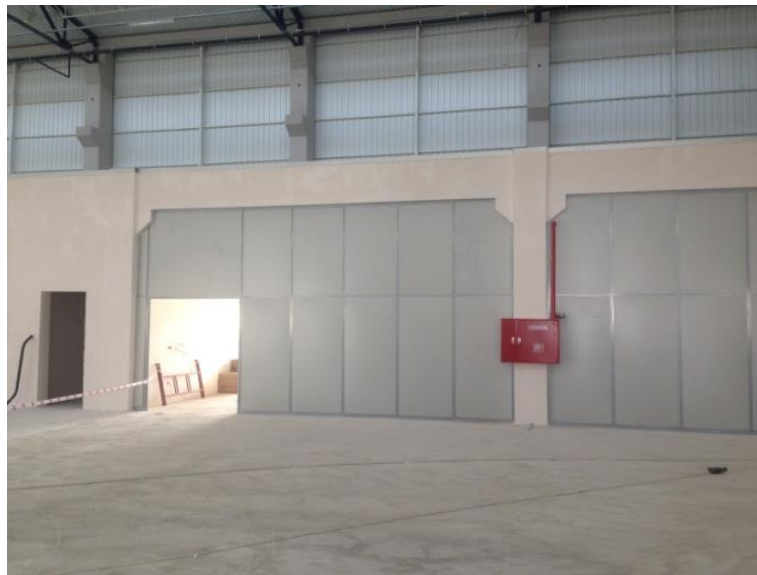
Şekil 4.14. Bosch Fren Sistemleri Fabrikası alçıpan bölme duvarı (Kaymaz 2014)
