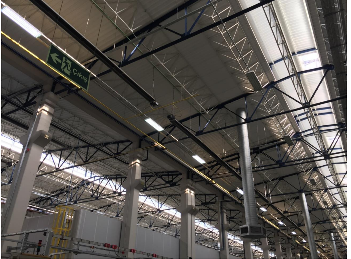
Şekil 4.29. Bosch Fren Sistemleri Fabrikası üretim alanı çatısı (Kaymaz 2016)
