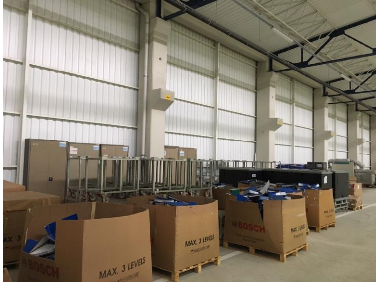
Şekil 4.13. Bosch Fren Sistemleri Fabrikası cephe paneli (Kaymaz 2017)
