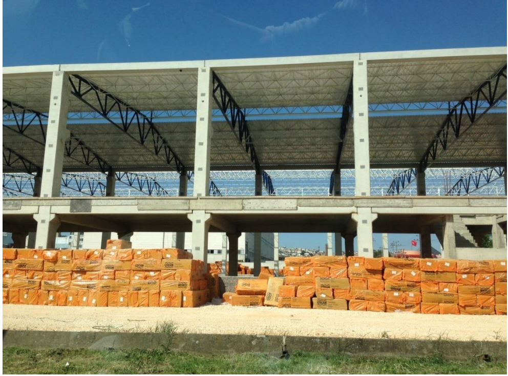
Şekil 4.11. Bosch Fren Sistemleri Fabrikası taşıyıcı sistemi (Kaymaz 2014)
