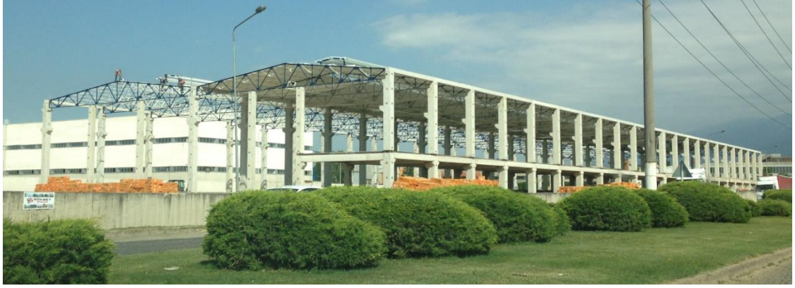
Şekil 4.27. Bosch Fren Sistemleri Fabrikası inşaat aşamasında genel görünüm (Kaymaz 2014)
