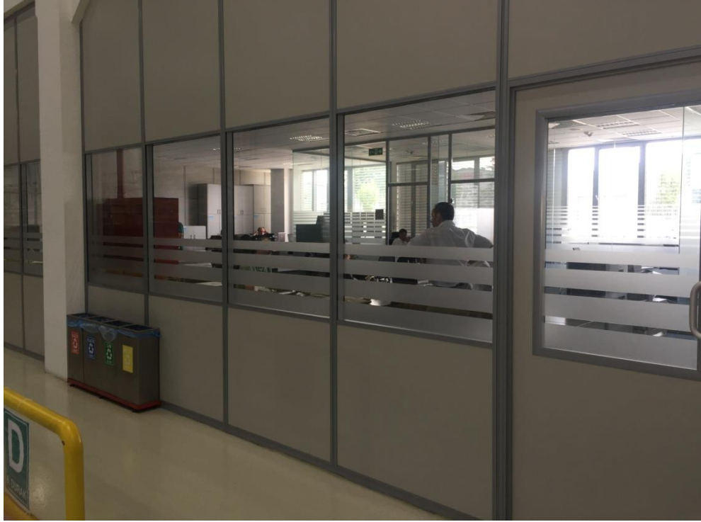
Şekil 4.16. Bosch Fren Sistemleri Fabrikası camlı alçıpan bölme duvar (Kaymaz 2016)
