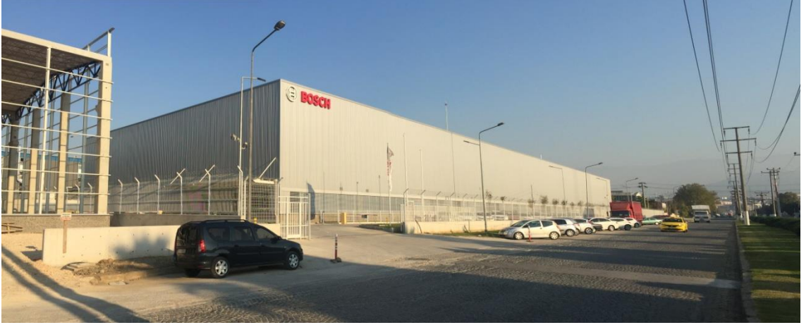
Şekil 4.1. Bosch Fren Sistemleri Fabrikası genel görünüm (Kaymaz 2015)
