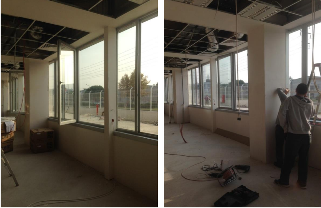
Şekil 4.25. Bosch Fren Sistemleri Fabrikası ofis bölümü pencereleri (Kaymaz 2014)
