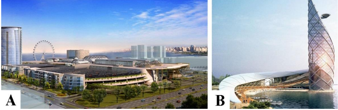
Şekil 4.56. Sahil bölgesinde simgesel yapılar A) Bakü mall ve sahil bölgesinde yer alan dönme dolap B) Deniz içerisinde yer alan otel binası (Beyaz şehir, 2021)
