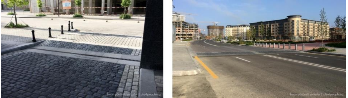
Şekil 4.22. Kaldırım seviyesine yükseltilmiş yerleşim yerlerine giriş ve ana yol örneği. (Aliyev 2021 arşivinden alınmıştır)
