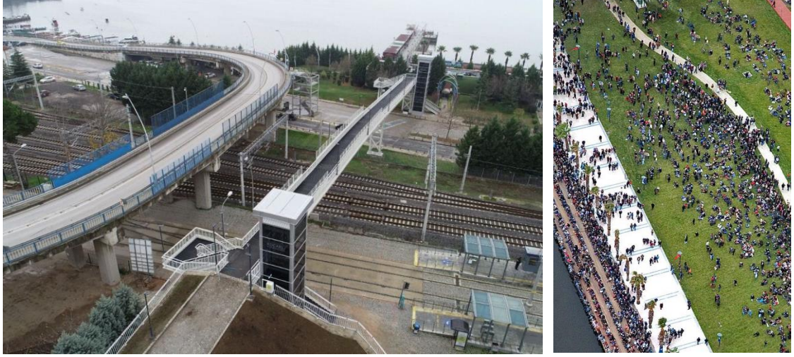
Şekil 2.83. Tren yolu üzerinde yaratılan köprü ve denize inen merdivenler. (Uzun, 2014)
