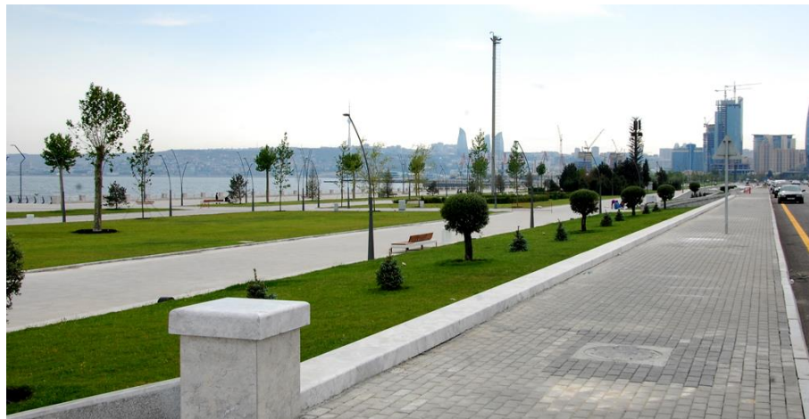
Şekil 4.3. Beyaz şehir bulvarının tamamlanmış bölümü (Aliyev 2022 arşivinden alınmıştır)
