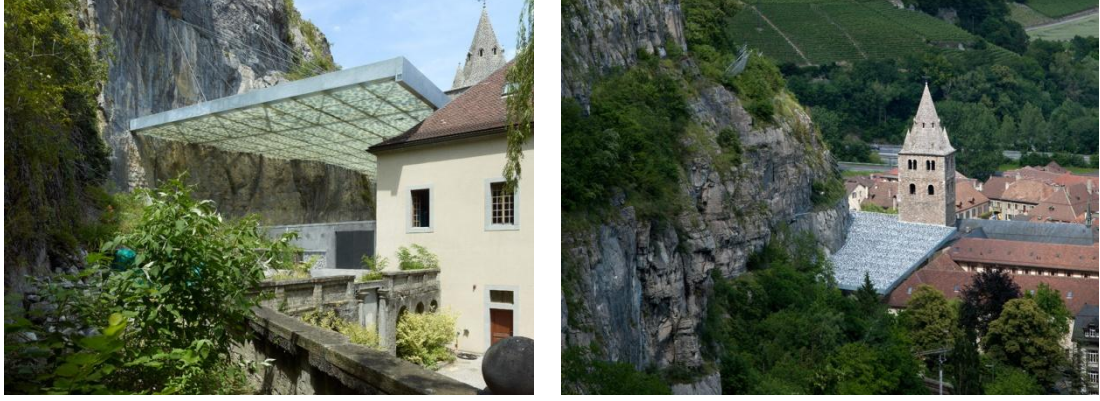
Şekil 38. (a) Saint Maurice Koruyucu Çatısı fotoğrafı, (b) Saint Maurice Koruyucu Çatısı hava fotoğrafı (Thomas Jantscher Arşivi, 2010)
