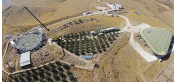
Şekil 154. Göbeklitepe Koruma Çatıları hava fotoğrafı (İrepoğlu, 2019)
