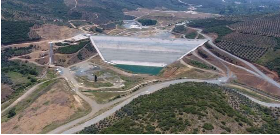
Şekil 3.12. Baraj gövdesi ve diğer ünitelerinin tamamlanmış son durumu
