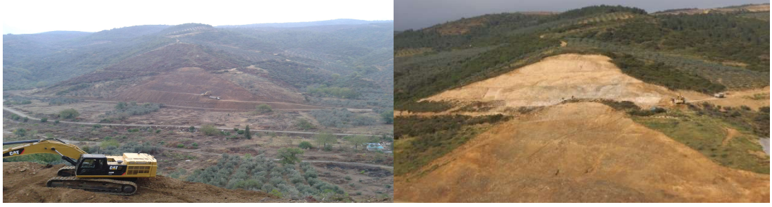
Şekil 3.6. Baraj gövde sıyırma ve şev kazıları öncesi doğal zemin görüntüsü
