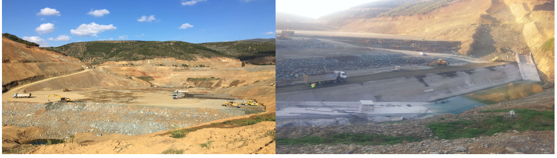
Şekil 3.11. Baraj gövdesi topuk plağı betonu ve gövde dolgusunun yapımı
