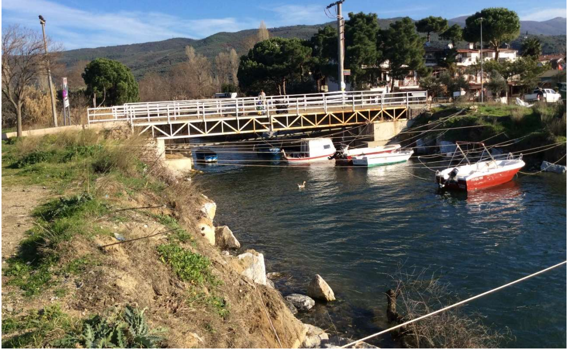
Ek Şekil 6. Derenin deniz ile birleştiği bölgesindeki köprü
