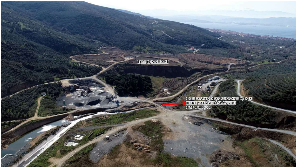
Ek Şekil 2. Büyükkumla Barajı depo sahası
