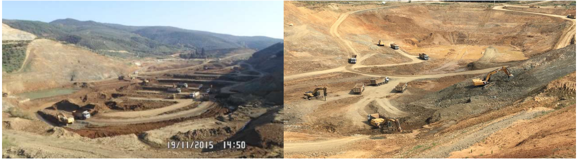
Şekil 3.8. Baraj gövdesi temel kazıları
