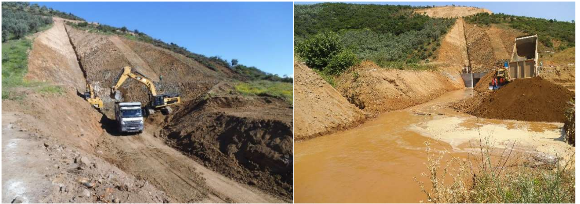
Şekil 3.5. Su alma yapısı temel kazıları
