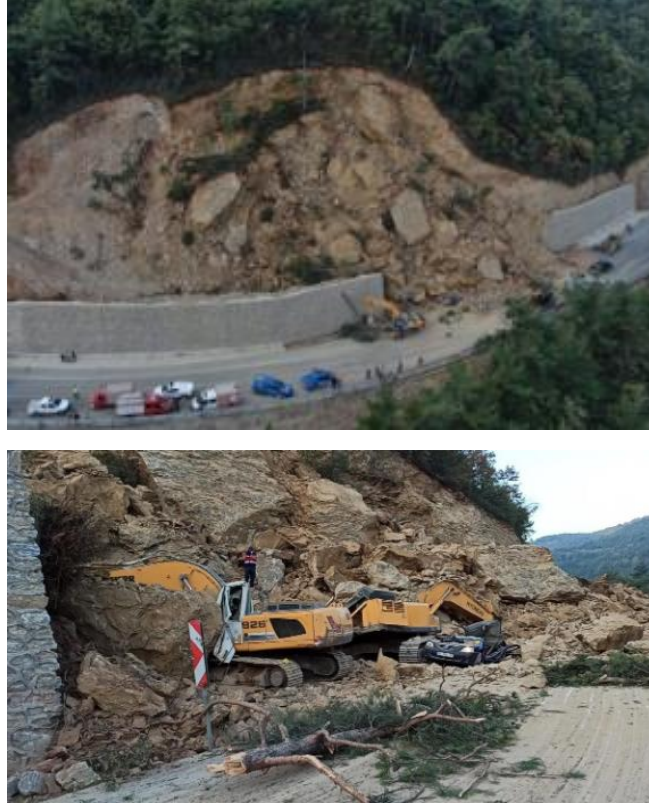
Fotoğraf 9. 2020'de Osmangazi'nin Doğancı Mahallesi'nde meydana gelen heyelana ait fotoğraf (Bursada Bugün Gazetesi, 2020)
