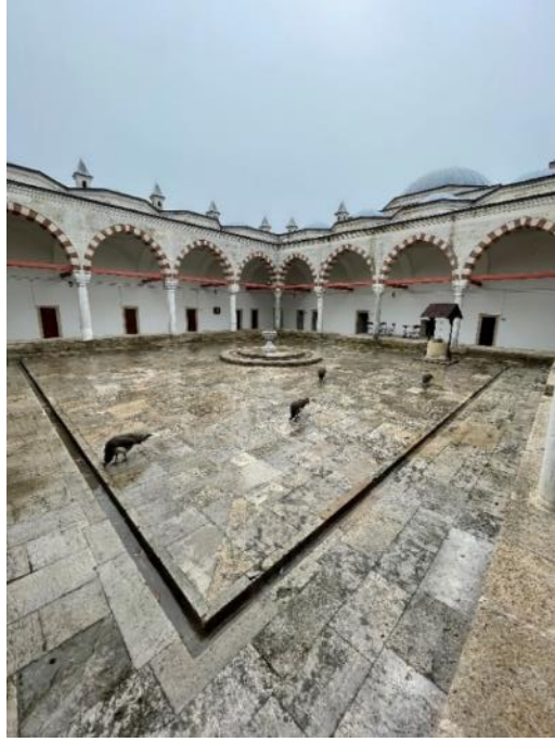
Resim 718. Edirne Bayezit II Medresesi, Güneybatıdan Görünüş 19. 03. 2021
