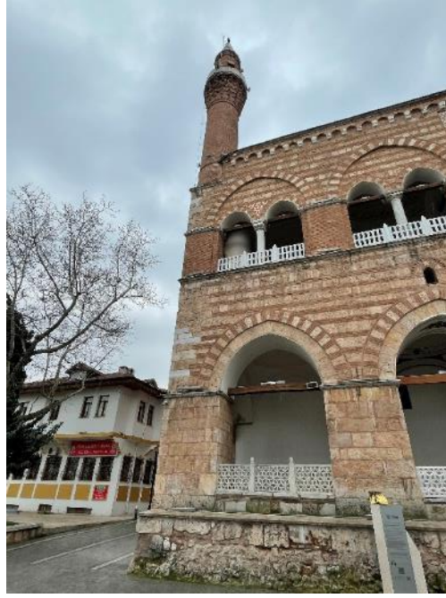
Resim 14. Bursa Hüdavendigâr Camii, Minare 31. 03. 2021
