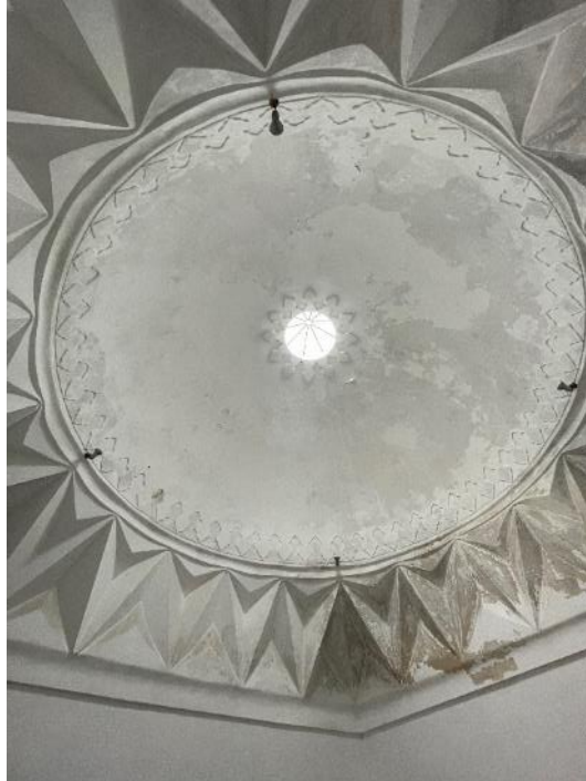
Resim 92. Bursa Hüdavendigâr Hamamı, Kubbe 31. 03. 2021
