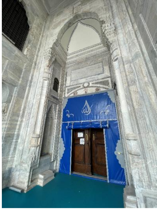
Resim 116. Bursa Yıldırım Camii, Taçkapıdan Detay 31. 03. 2021
