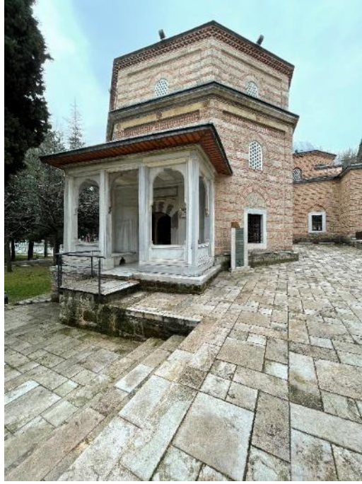
Resim 348. Bursa Şhzade Ahmed Türbesi, Kuzeybatıdan Görünüş 31. 03. 2021
