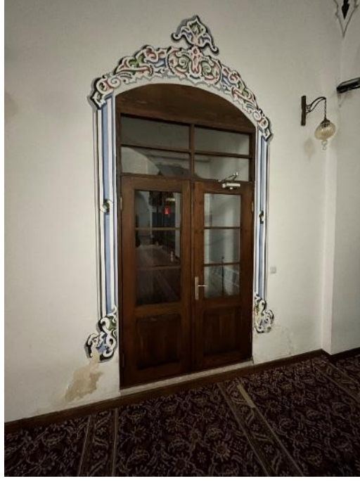
Resim 321. Bursa Muradiye Camii, Batı Eyvandan Detay 31. 03. 2021
