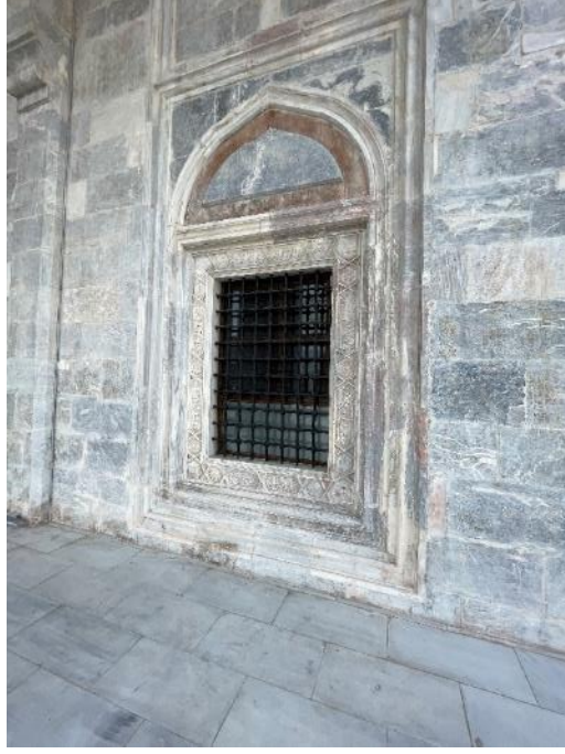
Resim 111. Bursa Yıldırım Camii Son Cemaat Yeri, Batıdan Pencere Görünüşü 31. 03. 2021
