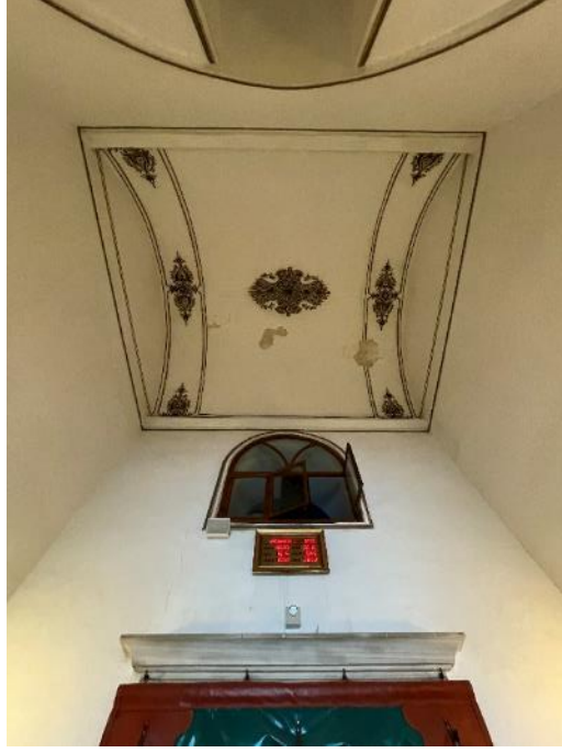
Resim 33. Bursa Hûdavendigâr Camii, Geçiş Koridoru Tonozu 31. 03. 2021
