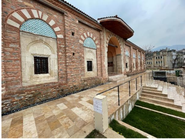
Resim 240. Bursa Yeşil Medrese, Kuzeydoğudan Görünüş 31. 03. 2021
