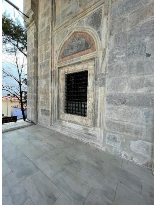
Resim 106. Bursa Yıldırım Camii Son Cemaat Yeri, Doğudan Pencere Görünüşü 31. 03. 2021
