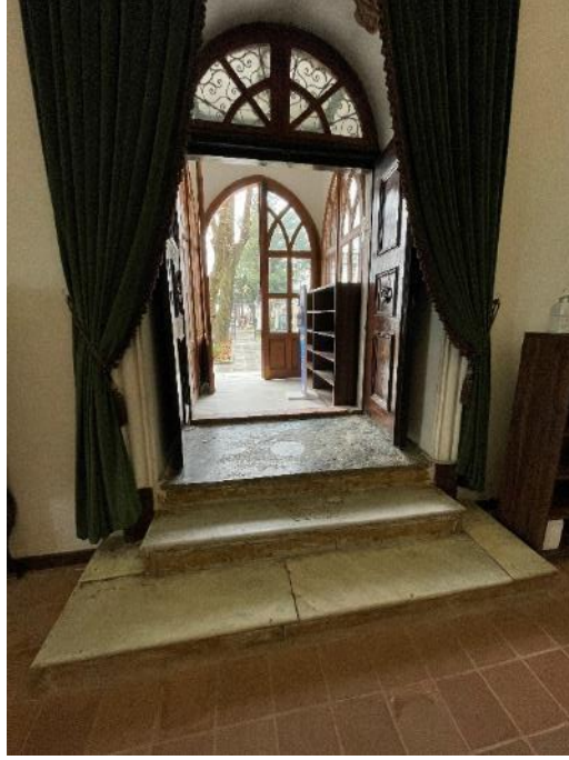
Resim 75. Bursa Hüdavendigâr Türbesi, Giriş Hacmi 31. 03. 2021
