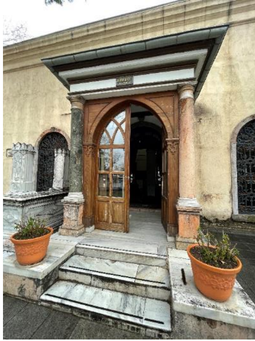
Resim 72. Bursa Hüdavendigâr Türbesi, Kuzeyden Görünüş 31. 03. 2021
