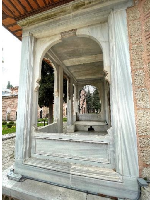
Resim 350. Bursa Şehzade Ahmed Türbesi, Revak Kemerleri 31. 03. 2021
