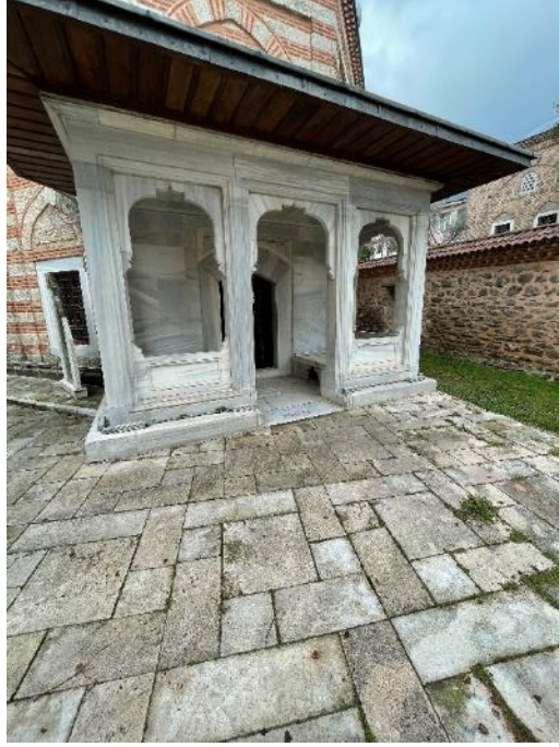
Resim 376. Bursa Şehzade Mahmud Türbesi, Revak Görünüşü 31. 03. 2021
