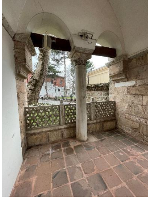
Resim 20. Bursa Hüdavendigâr Camii Son Cemaat Yeri, Batı İkiz Kemerli 31. 03. 2021
