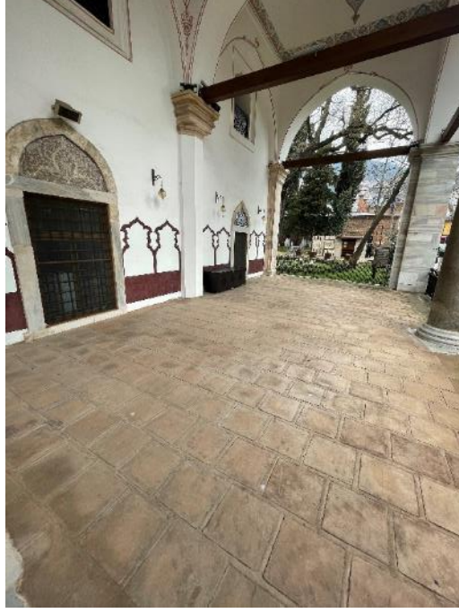
Resim 297. Bursa Muradiye Camii Son Cemaat Yeri, Batıdan Görünüş 31. 03. 2021
