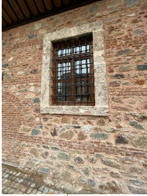
Resim 87. Bursa Hüdavendigâr İmaretî, Güneyden Pencere Görünüşü 31. 03. 2021
