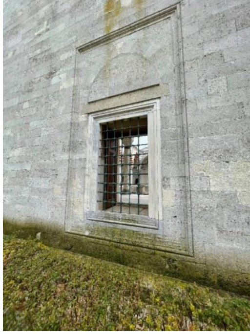
Resim 577. Edirne Bayezit II Camii, Kuzeyden Pencere Görünüşü 19. 03. 2021
