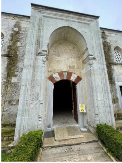
Resim 703. Edirne Bayezit II Dârüşşifası, Taçkapının Kuzeyden Görünüşü 19. 03. 2021
