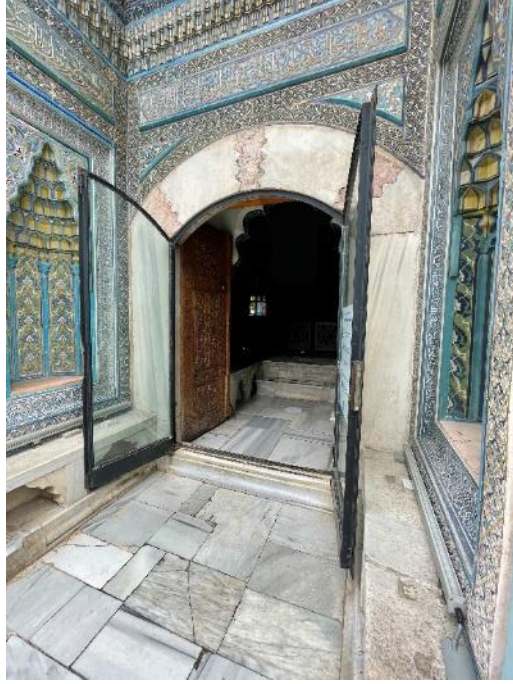
Resim 268. Bursa Yeşil Türbe, Portal Kemer 31. 03. 2021
