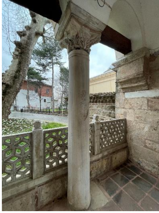
Resim 21. Bursa Hüdavendigâr Camii Son Cemaat Yeri, Batı Sütunu 31. 03. 2021
