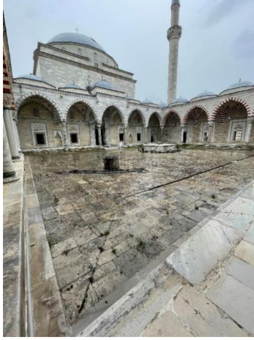
Resim 589. Edirne Bayezit II Camii, Avlunun Kuzeydoğudan Görünüşü 19. 03. 2021
