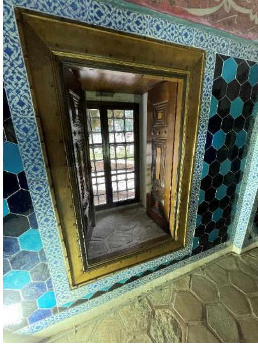
Resim 352. Bursa Şehzade Ahmed Türbesi, İç Mekândan Pencere Görünüşü 31. 03. 2021
