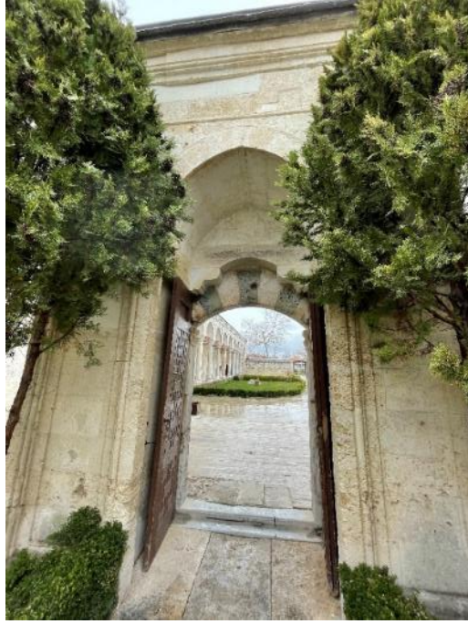
Resim 688. Edirne Bayezit II Dârüşşifası, Taçkapının Kuzeyden Görünüşü 19. 03. 2021
