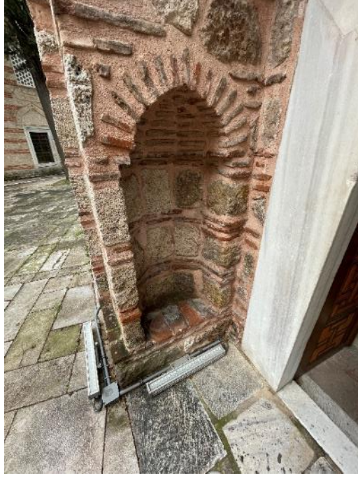
Resim 383. Bursa Gülşah Hatun Türbesi, Doğudan Niş Görünüşü 31. 03. 2021
