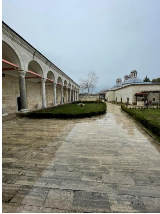
Resim 672. Edirne Bayezit II Dârüşşifası, Güneyden Görünüş 19. 03. 2021
