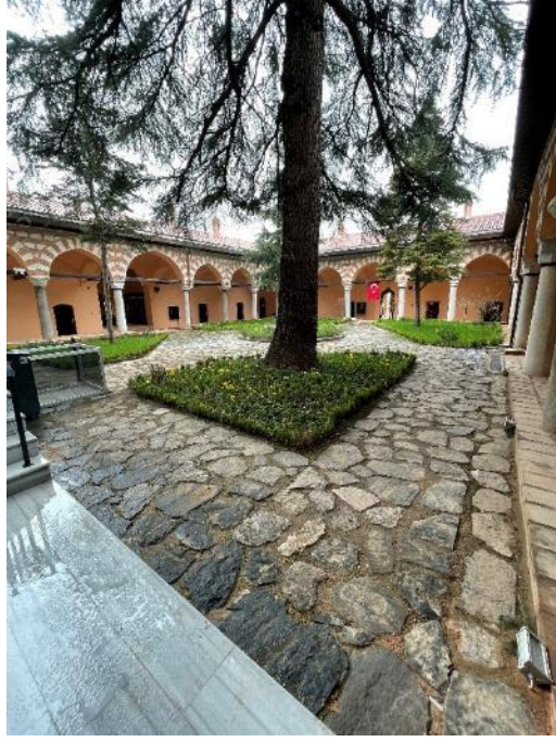
Resim 247. Bursa Yeşil Medrese, Avlunun Kuzeybatıdan Görünüşü 31. 03. 2021
