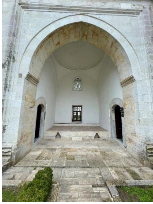
Resim 697. Edirne Bayezit II Dârüşşifası, Batı Eyvan Kemerli 19. 03. 2021
