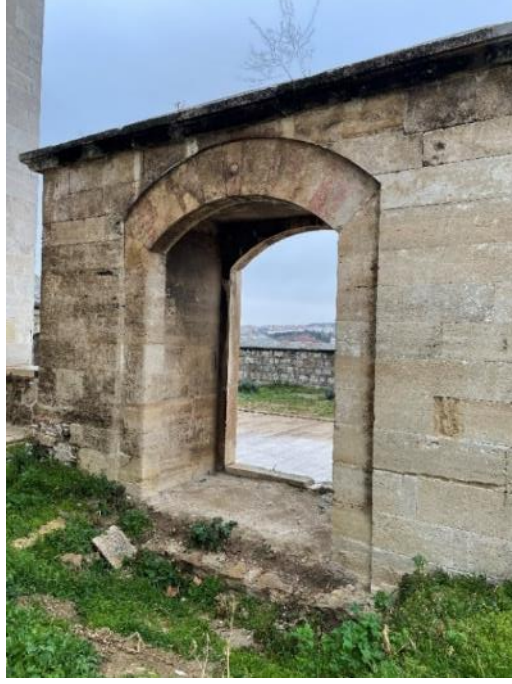
Resim 463. Edirne Murâdiye Camii, Güneyden Hazireye Giriş Kapısı 17. 03. 2021
