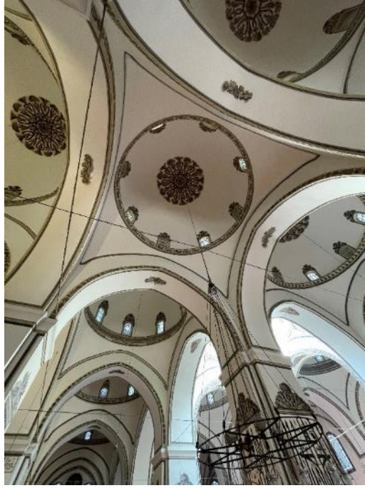
Resim 178. Bursa Ulu Cami, Kubbe Görünüŧü 31. 03. 2021
