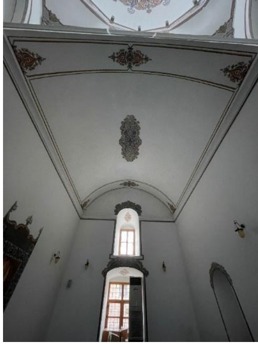
Resim 57. Bursa Hüdavendigâr Camii, Batı Eyyvanı Tonozu 31. 03. 2021
