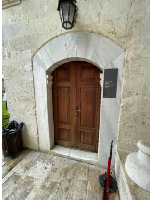
Resim 684. Edirne Bayezit II Dârüşşîfası, Eyvan Hacminin Güneydoğu Odası 19. 03. 2021
