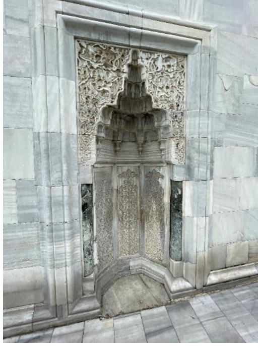
Resim 197. Bursa Yeşil Cami, Kuzeyden Mihrap Görüntüsü 31. 03. 2021
