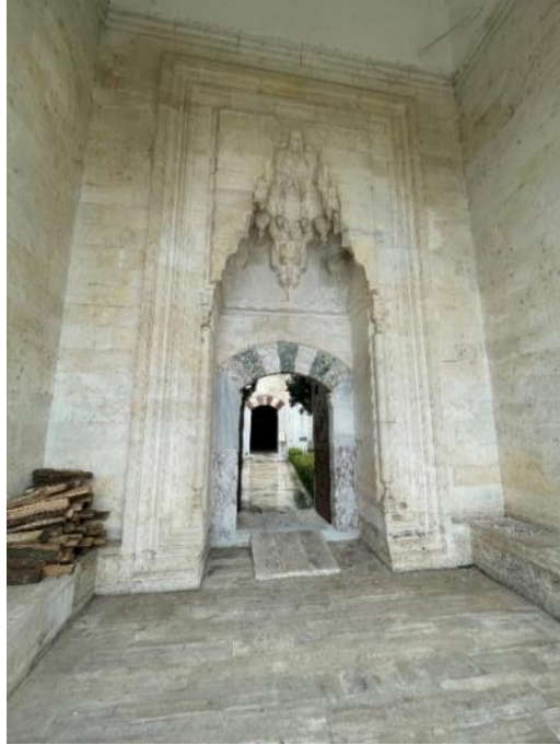
Resim 686. Edirne Bayezit II Dârüşşifası, Taçkapının Kuzeyden Görünüşü 19. 03. 2021
