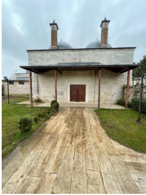
Resim 668. Edirne Bayezit II Kervansarayı, Kuzeyden Görünüş 19. 03. 2021
