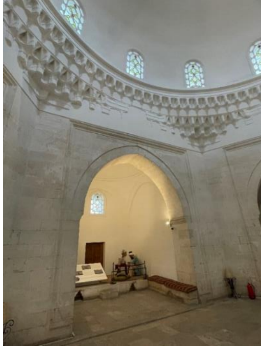
Resim 708. Edirne Bayezit II Dârüşşifası, Kubbeye Geçiş Görünüşleri 19. 03. 2021
