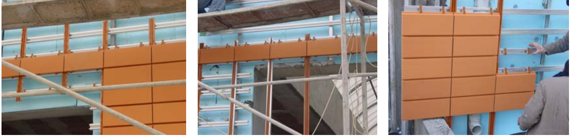
Şekil: 4.4; T fuga profilin uygulanması “Şaypa Market, Nilüfer, Bursa, 2005” (Özgür, S. 2008).
