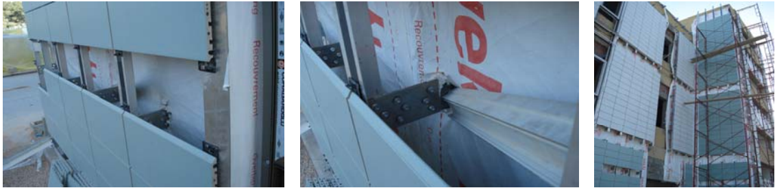
Şekil: 4.3; Rüzgar ve su kesici malzemesinin uygulanması “Misurata Hastanesi, Libya, 2008” (Özgür, S. 2008).
