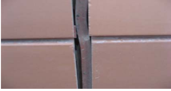
Şekil:3.8T fuga profilin deforme olması“Merinos Kültür Merkezi, Merinos, Bursa”, (Tair, G. 2009).
