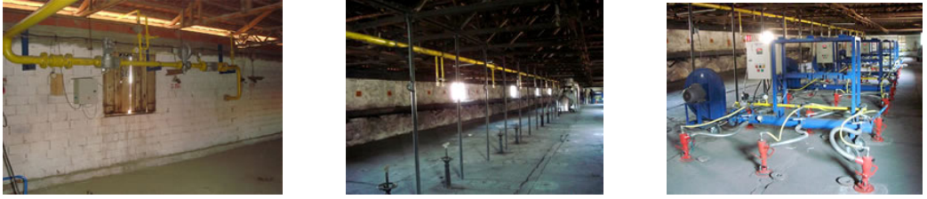
Şekil: 4.2; Hoffman Fırınları İçin Doğalgaz Yakma Sistemi. “Şekerpinar Gebze Kocaeli” (Anonim, 2010), (www.keramik.com.tr).
