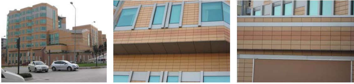
Şekil: 3.2; Cephe tuğlasının yatay yüzeylerinde uygulanmaması “Acıbadem Hastanesi, Nilüfer, Bursa,” (Tair, G. 2008).
