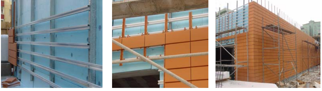
Şekil: 2.16; Yatay sistemin üzerine kaplama plakaların uygulanması “Şaypa Market, Nilüfer, Bursa, 2005” (Özgür, S. 2008).
