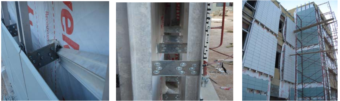
Şekil: 2.14; Düsey sistemin üzerine kaplama plakaların uygulanması “Misurata Hastanesi, Libya, 2008” (Özgür, S. 2008.).
