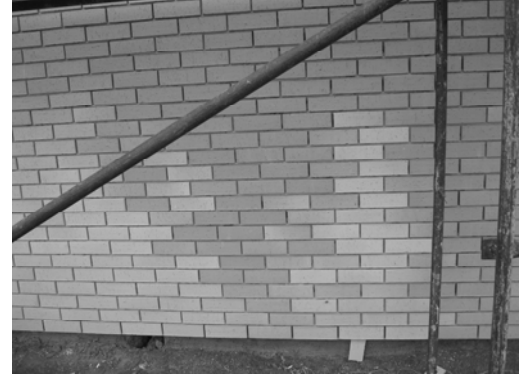
Şekil:3.21; Tuğla plakaların renk uyumsuzluğu ‘Atıcılar Mahalle Konağı, Atıcılar, Bursa’ (Tair, G. 2009).
