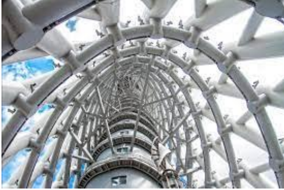
Şekil 3.20. Yapının dış diagrid sistemi a) iç sarmal örgü ve çekirdek, b) dış görünüş (Anonim e,2021)
