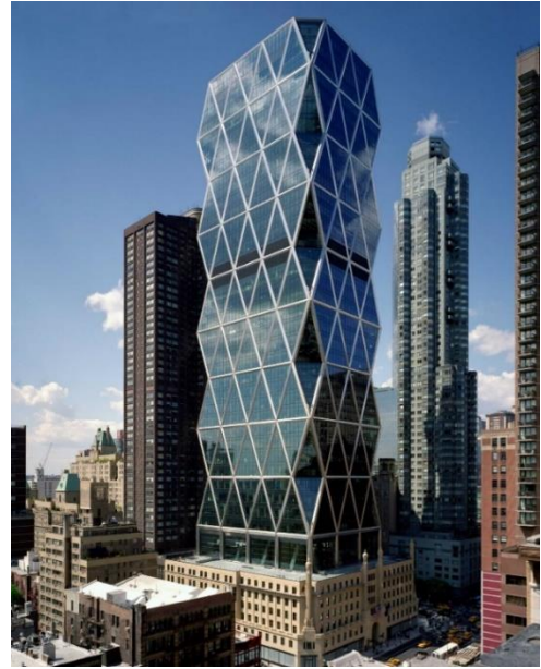
Şekil 3.15. Diagrid sistemler a) IBM binası ve b) Hearts kulesi (Anonim a, 2021)
