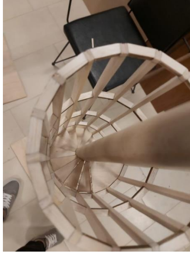
Şekil 4.7. Merdiven montaj aşaması
