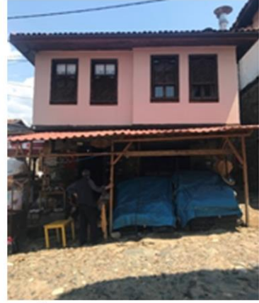
Ön cephe görünüşü
