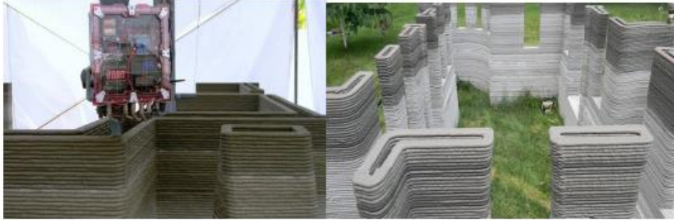
Şekil 2.9. Beton duvar yapımı (Bedir ve ark., 2018)
