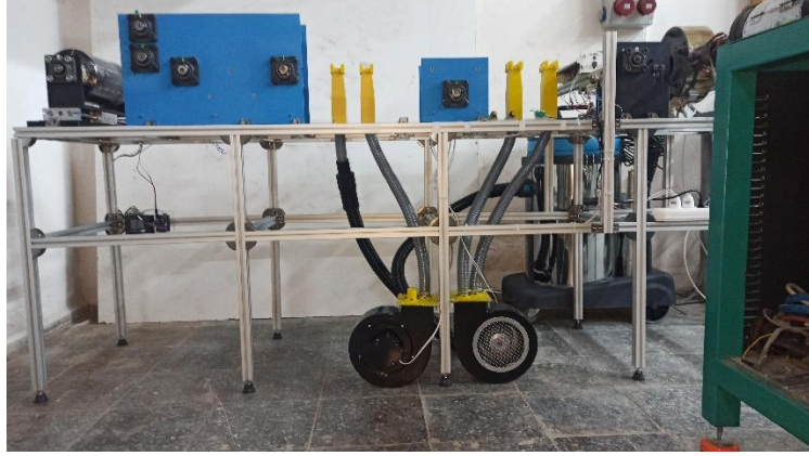
Şekil 3.50. Hava kulelerine vakum ve üfleme hortumlarının bağlanması
