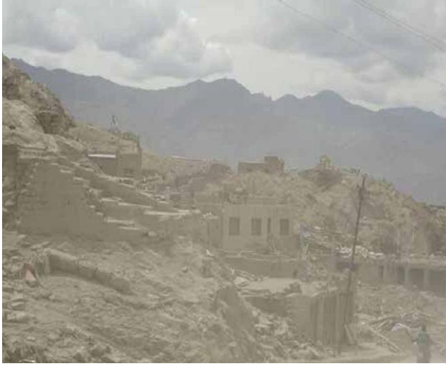
Şekil 2.3. Hindistan 2010’daki bulut patlaması nedeniyle Leh’teki kültürel mirasın hasarı (Jigyasu ve ark. 2013).
