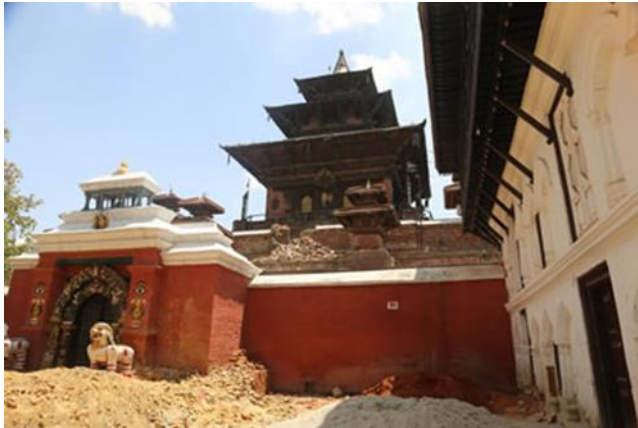
Şekil 2.5. Bhaktapur Durbar Meydanı genel olarak hasar durumu (Vatan 2015).
