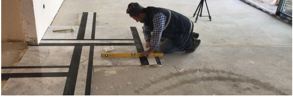
Şekil 2.24. Doğal taş döşeme kaplama uygulaması (Şahin 2019 arşivi)
