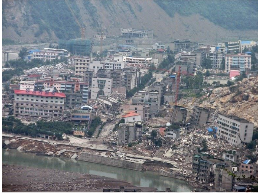
Şekil 2.10. Wenchuan Depremi sonrası hasar durumu (Patowary, 2014)
