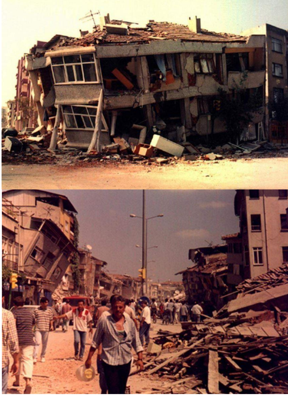
Şekil 2.26. 1999 Depremi sonrası Adapazarı'nda meydana gelen hasarlar (“17 Ağustos 1999 Depremi”, 2019)
