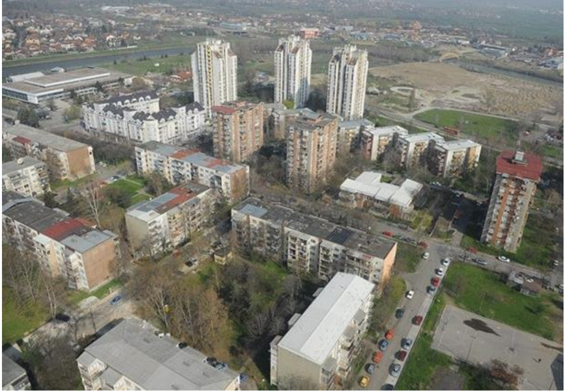
Şekil 2.8. Prefabrike konut yapılarından oluşan Karpos IV, Üsküp (“Karpos’ta bir binada”, 2019)
