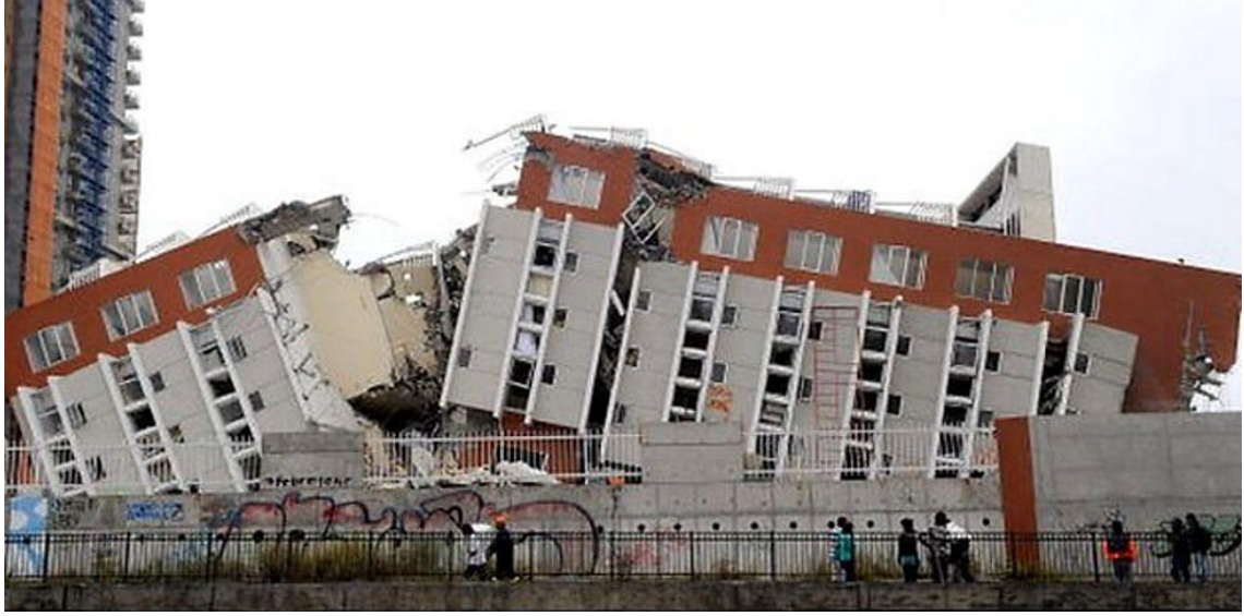
Şekil 2.16. Şili Depremi sonrası konut alanlarında yaşanan hasarlar (Manning, 2021)
