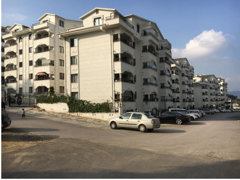
Şekil 3.12. Kentin güney çeperine yakın seçilen Topçular Mahallesi'nde bulunan Beyaz Saraylar Sitesi (Uzuner Arşivi, 2019)
