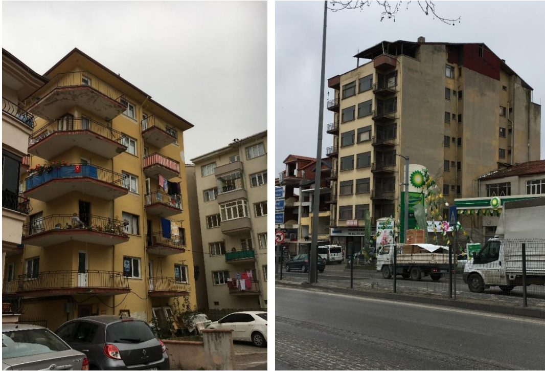
Şekil 3.7. Değirmendere ve çevresinde bulunan fiziksel eskimeye uğramış yüksek katlı konut yapıları (Uzuner Arşivi, 2020)
