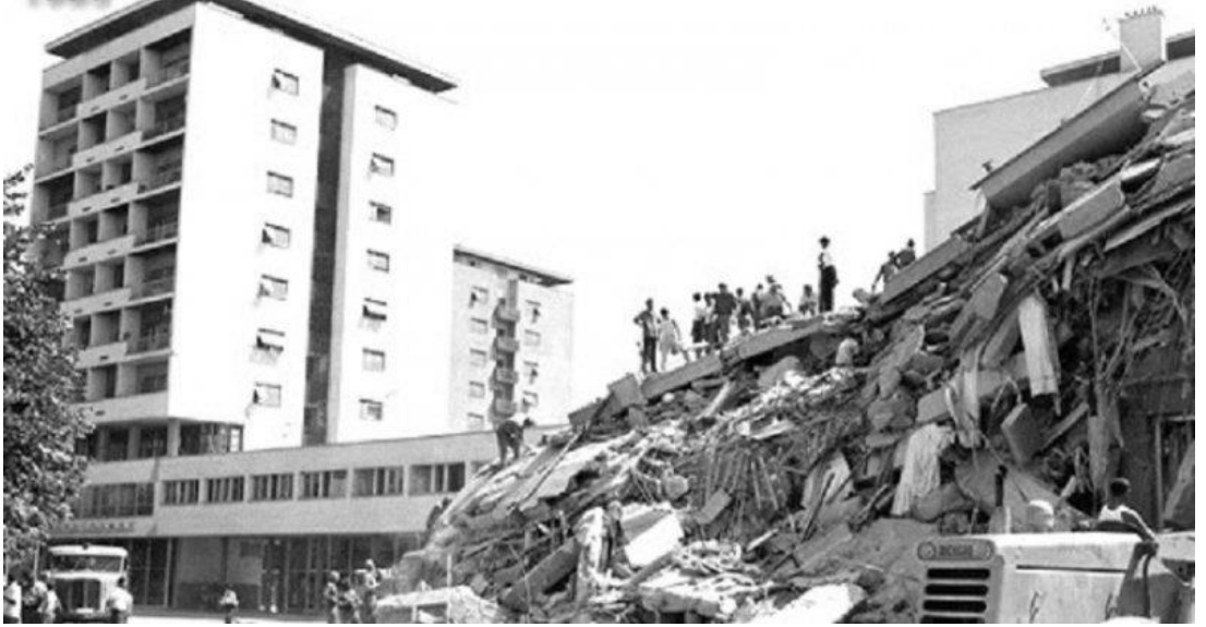
Şekil 2.5. Üsküp'te meydana gelen deprem sonrası konut alanlarındaki hasar durumu (Haykır, 2018)
