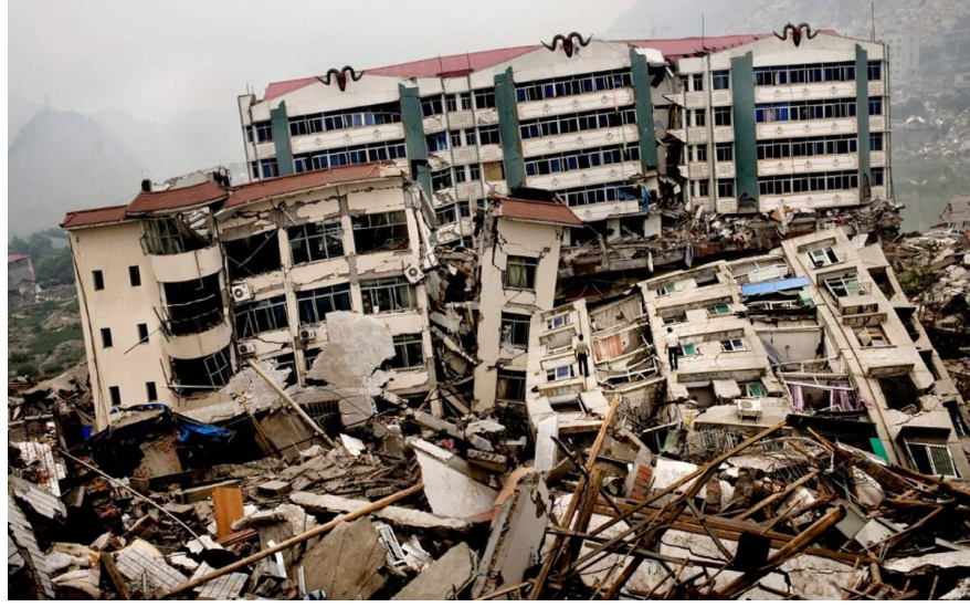
Şekil 2.11. Wenchuan Depremi sonrası hasar durumu (Nevres, 2017)
