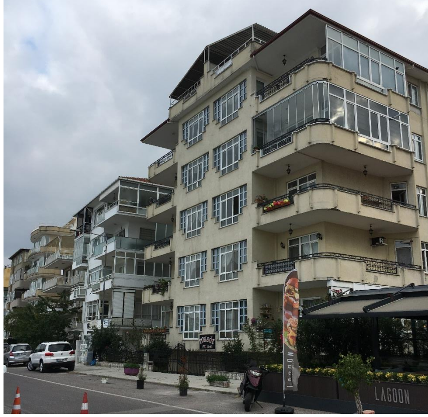
Őekil 4.1. Seilen ada sınırı evresinde bulunan eski ve yksek katlı yapılařmalar, deprem gvenliđi aısından risk faktr oluřturmaktadır (Uzuner Arřivi, 2019)
