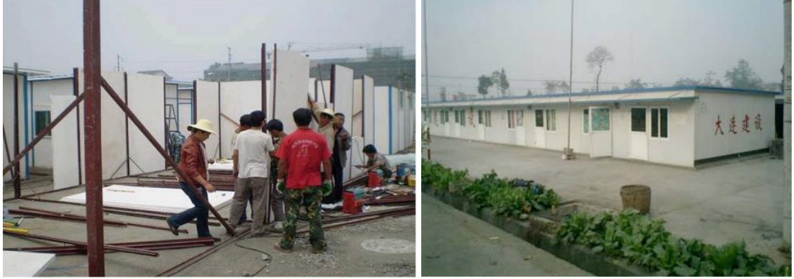
Şekil 2.12. Depremden sonra üretilen geçici konut birimleri (UNCRD, 2009)
