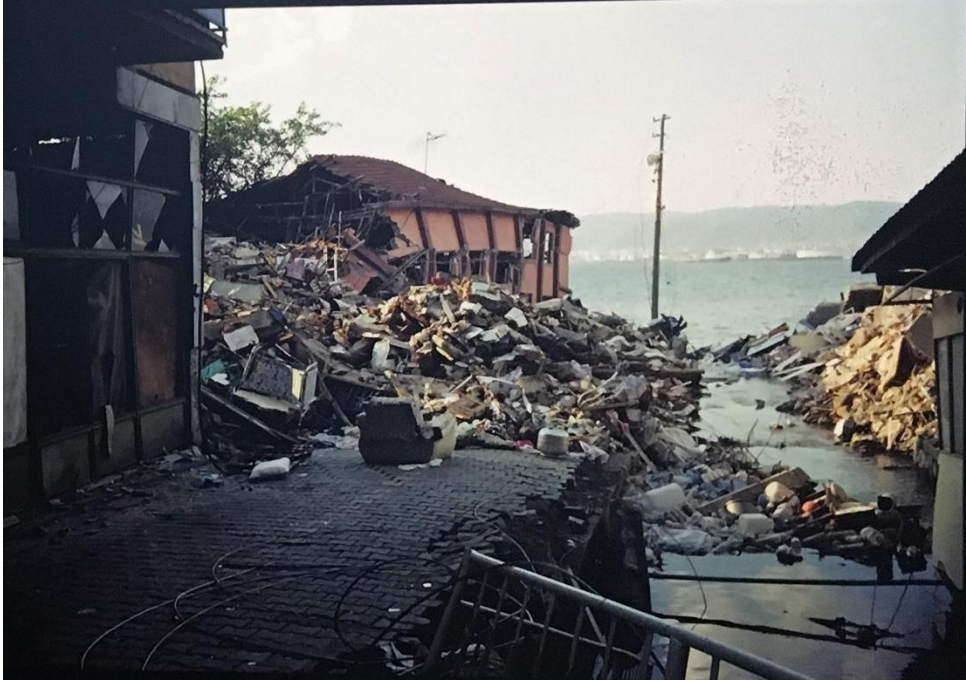
Şekil 3.2. 1999 Depremi sonrası Gölcük kıyı alanlarındaki hasar durumu (İsmail İkiz Arşivi)
