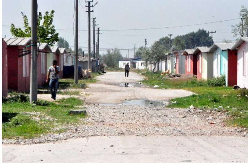
Şekil 2.27. Alancuma prefabrik mahallesi (“Adapazarı’ndaki Prefabrikler”, 2013)
