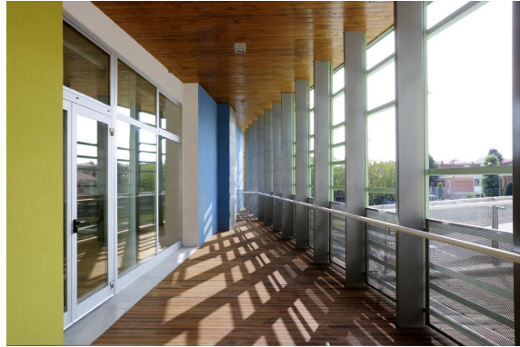
Şekil 3.29. Barbapapà Anaokulu Trombe duvar uygulaması (Anonim 2021p)
