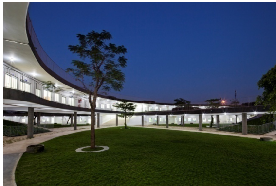
Şekil 3.22. Tarım Anaokulu güneş kırıcısı çatı uygulaması (Anonim 2021m)
