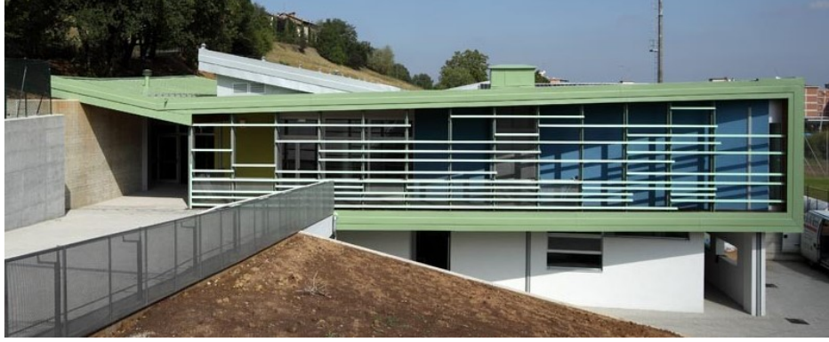
Şekil 3.26. Barbapapà Anaokulu güneş kırıcı panel uygulaması (Anonim 2021p)
