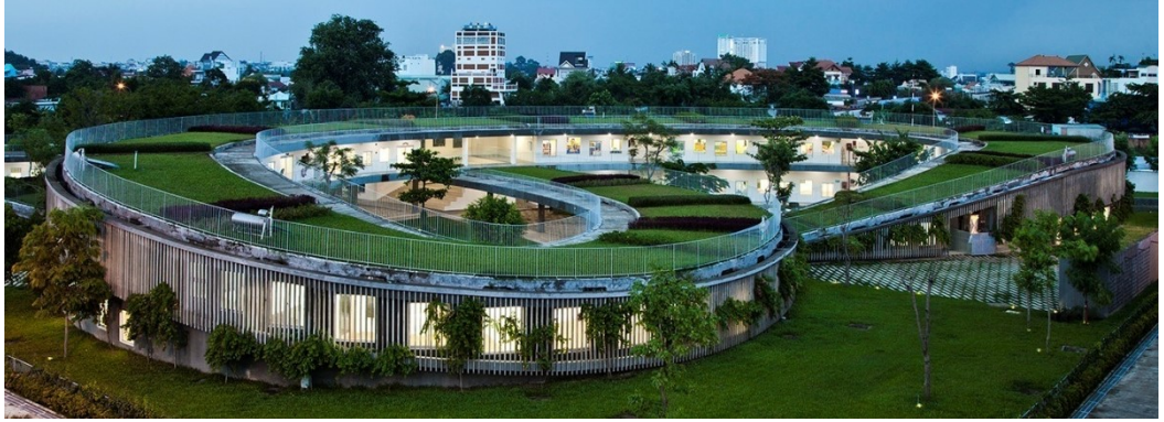
Şekil 3.20. Tarım Anaokulu güneş kırıcı panel uygulaması (Anonim 2021m)
