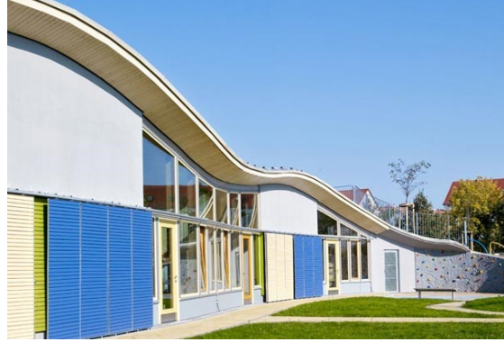
Şekil 3.33. Heidenau Anaokulu güneş kırıcı panel uygulaması (Anonim 2021o)
