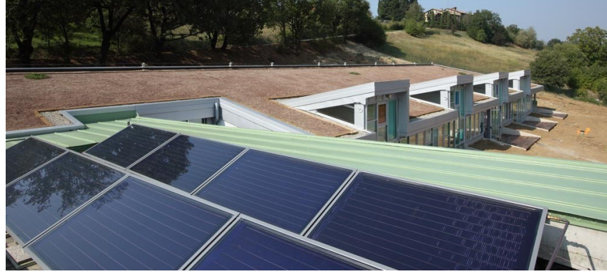
Şekil 3.28. Barbapapà Anaokulu güneş kolektörleri ve PV uygulaması (Anonim 2021p)
