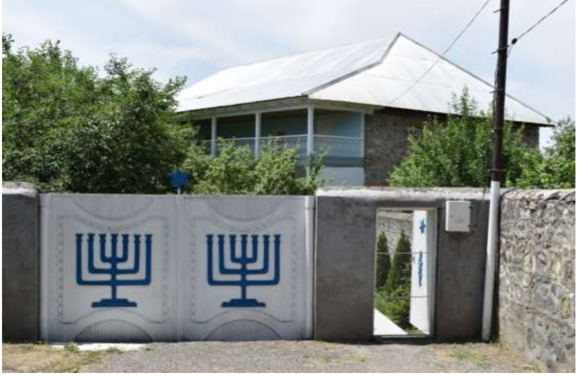
Oğuz Şehri Aşağı Mahalle Sinagogunun dıştan görünümü. Yapım tarihi 1849.
