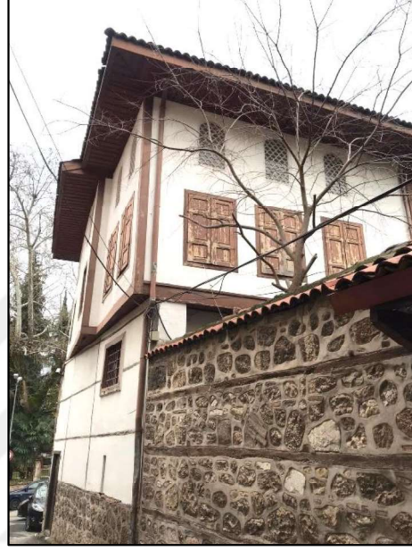
Şekil 3.37. Bursa Muradiye Osmanlı Evi cephesinde pencereler
