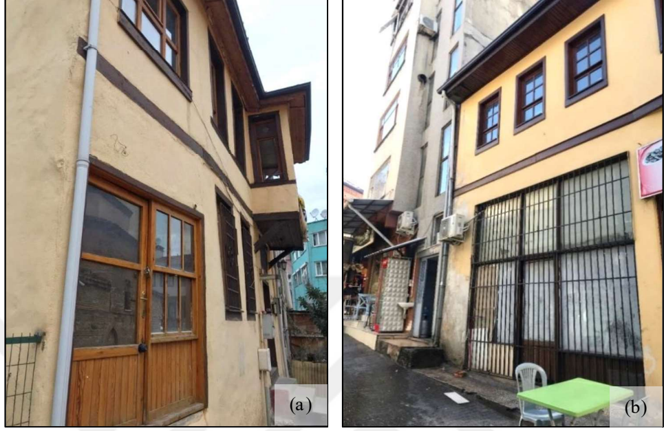
Şekil 3.33. (a) Geleneksel evde yapılan modern düzenlemede oran sorunu (a) Muradiye Mahallesi’nde bir ev, (b) Reyhan Mahallesi’nde bir ev
