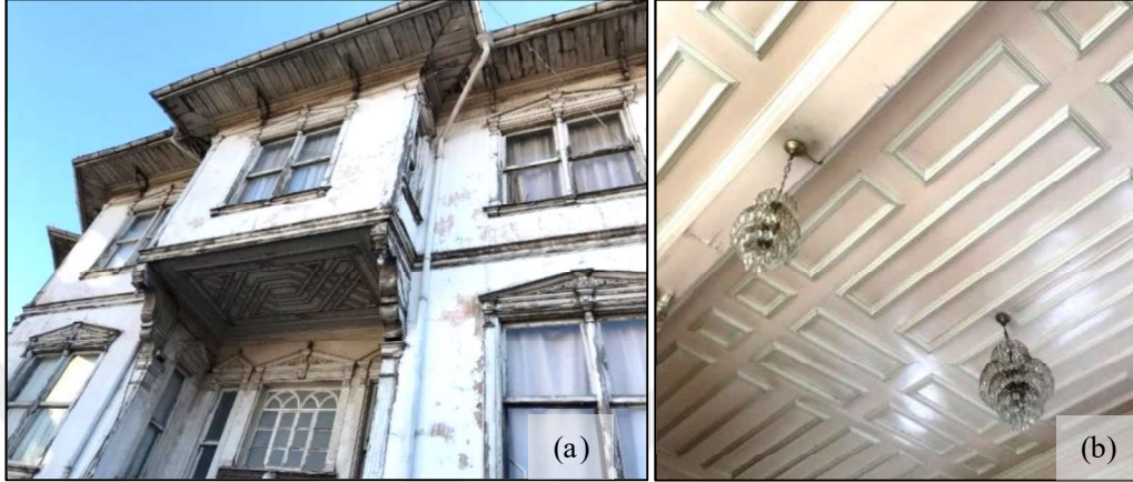
Şekil 3.45. Reyhan Mahallesi'nde bir evin (a) cephesinde süslemeler, (b) odasının tavanda çıtalama
