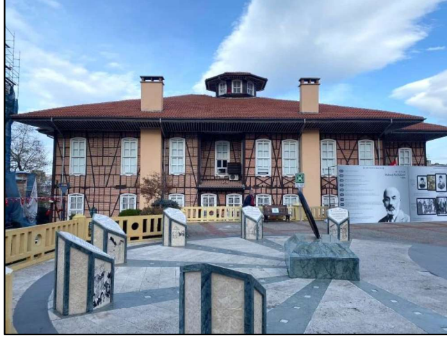
Şekil 3.43. Eski Belediye Binası çatı üzerinde cihannüma örneği
