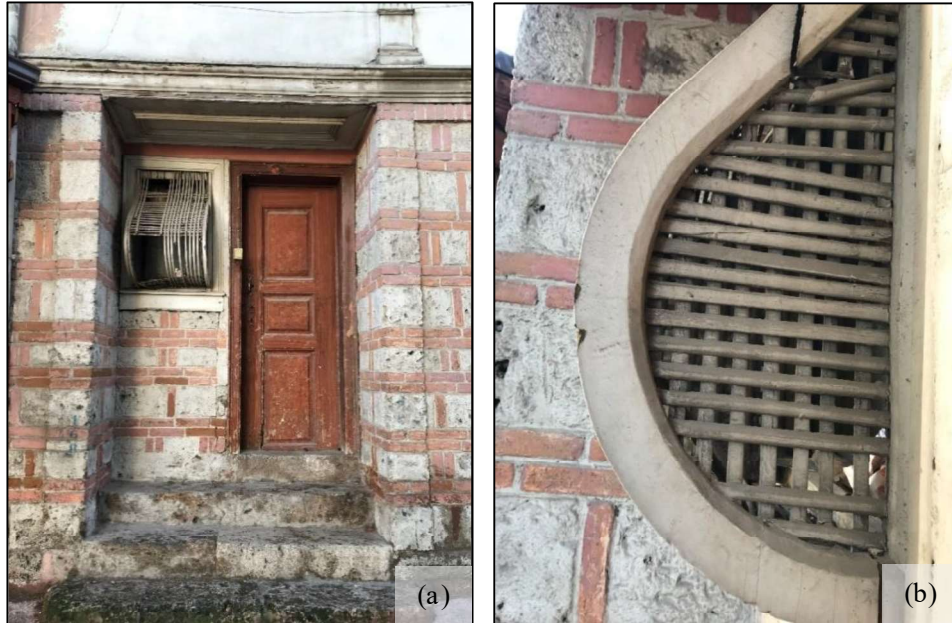
Şekil 3.19. (a) Reyhan Mahallesi’nde bir ev cephesindeki kapı ve kafes pencere, (b) kafes pencere yakın görünümü
