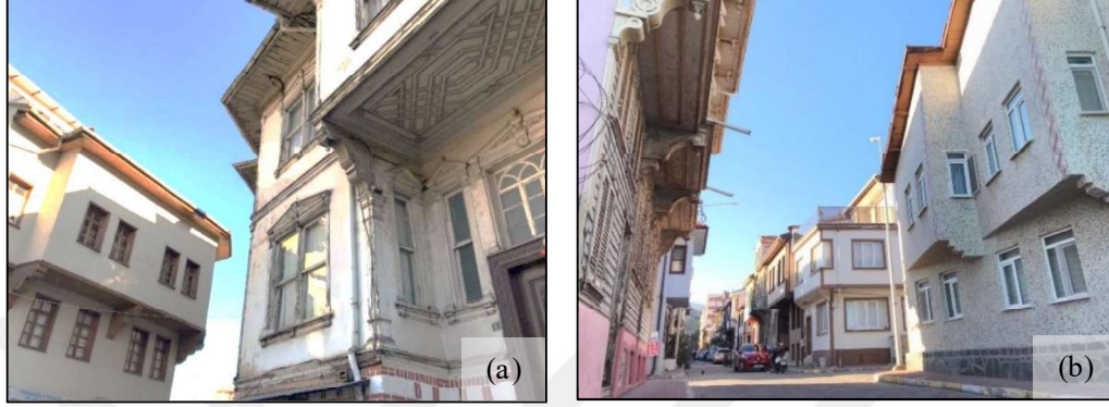
Şekil 4.3. (a) Reyhan Mahallesi'nde betonarme konutta ve geleneksel evde yapılan çıkma ve (b) Mudanya'da geleneksel evde ve betonarme konutta yapılan çıkma
