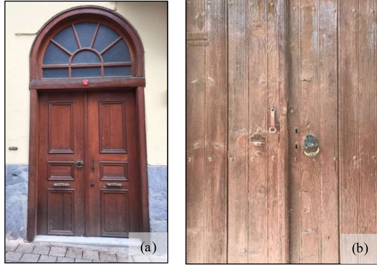
Şekil 3.20. (a) Ahşap kapı üstünde tepe penceresi, (b) ahşap kapı tokmakları
