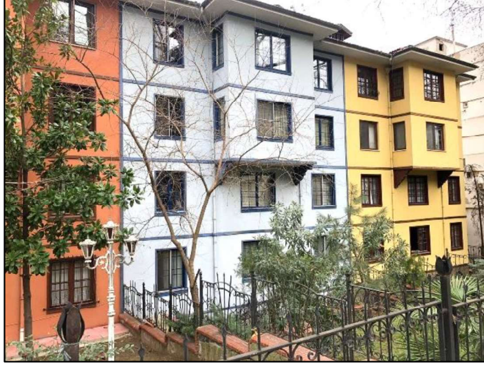
Şekil 3.50. Çekirge Caddesi'nde betonarme konutlarda cephede cumba
