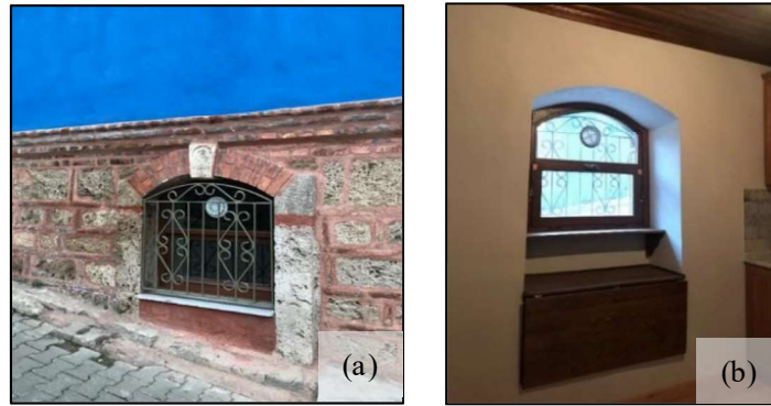
Şekil 3.39. Tahtakale'de bir evin (a) zemin katında mutfak penceresi (b) içten görünümü
