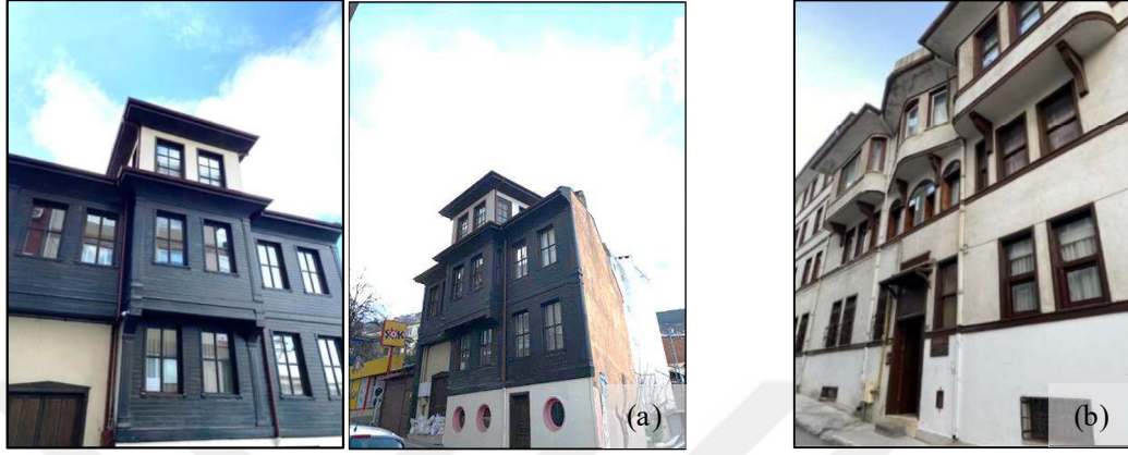
Şekil 3.49. (a) Maksem’de yalnızca ön cephesi ahşapla kaplanan yapı (b) Tophane’de betonarme konut cephesinde oran-orantı-ölçek sorunu
