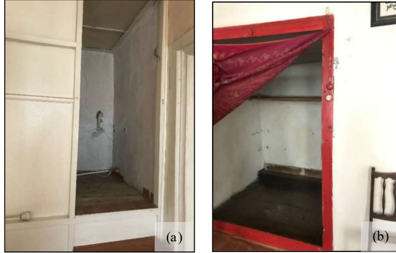
Şekil 3.32. (a) Hisar'da bir evin gusülhanesinin dolap işlevinde kullanımı, (b) yüklük işlevinde kullanımı
