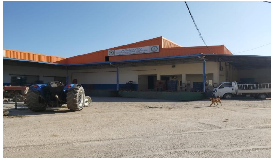
Fotoğraf 22: Ağaköy Mahallesi'ndeki Tarımsal Kalkınma Kooperatifi ve Soğuk Hava Tesisleri
