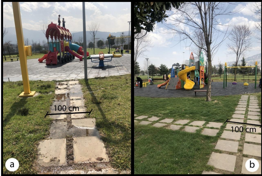
Şekil 4.73. Hüdavendigâr Kent Parkı çocuk oyun alanları (a)deforme olmuş giriş yolu,(b) çocuk oyun alanı adım taşı girişi (Büşra AKGÜN PİŞKİN,2020-Orijinal)
