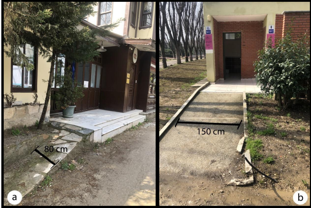
Şekil 4.42. Soğanlı Botanik Parkı rampa örnekleri: (a) Restoran girişi, (b) Engelli WC girişi (Büşra AKGÜN PİŞKİN 2020-Orijinal)
