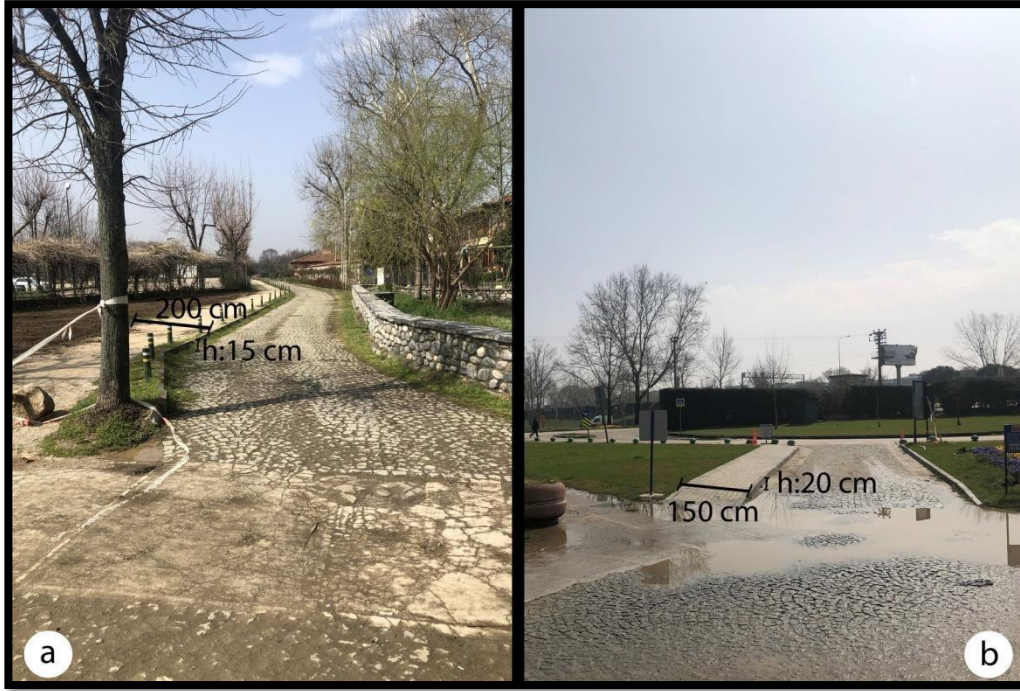
Şekil 4.44. Soğanlı Botanik Parkı kaldırım örnekleri: (a) ara yol üzerindeki kaldırım, (b) giriş kısmı (Büşra AKGÜN PİŞKİN 2020-Orijinal)
