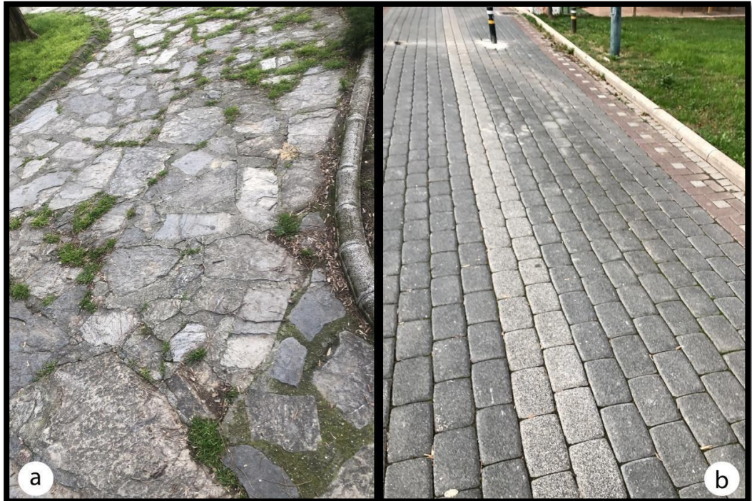
Şekil 4.6. Reşat Oyal K lt rparkı yolların malzeme nitelięi: (a) kayrak taŐı (b) parke taŐı (B řra AKG N PİŐKİN, 2020-Orijinal)
