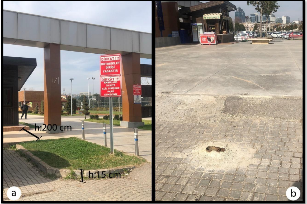
Şekil 4.62. Hüdavendigar Kent Parkı Giriş Kaldırım örneği: (a)Kaldırım ölçüleri, (b)Kaldırım yolunun malzeme niteliği (Büşra AĞÜN PİŞKİN, 2020-Orijinal)
