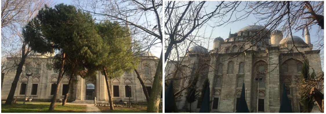
Şekil 3.11. Solda; Şehzade M. Camii kuzey cephesi. Sağda; Şehzade M. Camii güney cephesi. (Mohtasib 2021)
