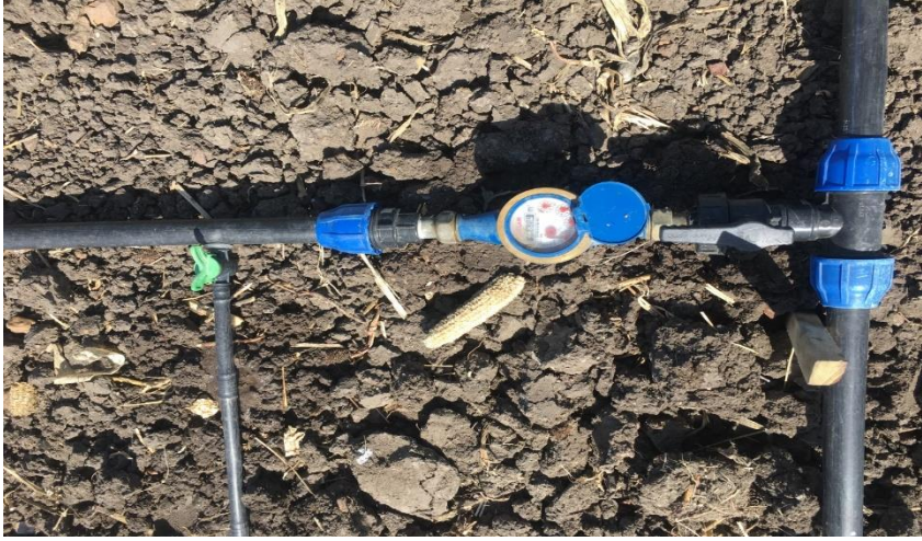
Şekil 3.3. Ana boru hattına gelen suyun yan boru hattına iletilmesi
