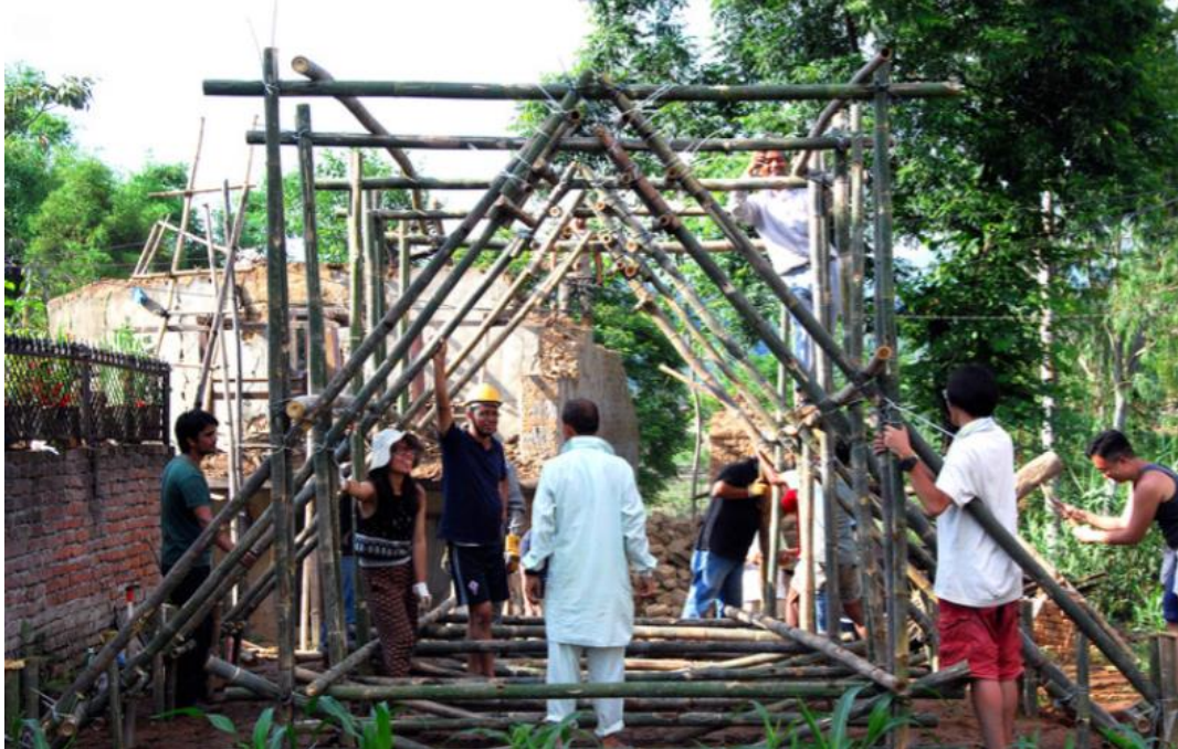
Şekil 3.12. Nepal'deki geçici barınak yapım aşaması (Anonim 2017b)
