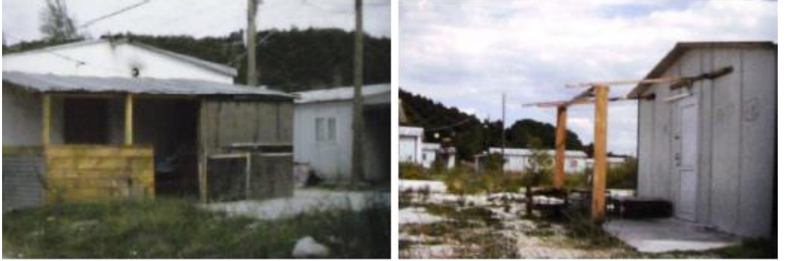
Şekil 3.48. Yalova 9. Bölge prefabriklerinde eklenen depo alanı veya gölgelik gibi ek mekanlar (Onur 2005)
