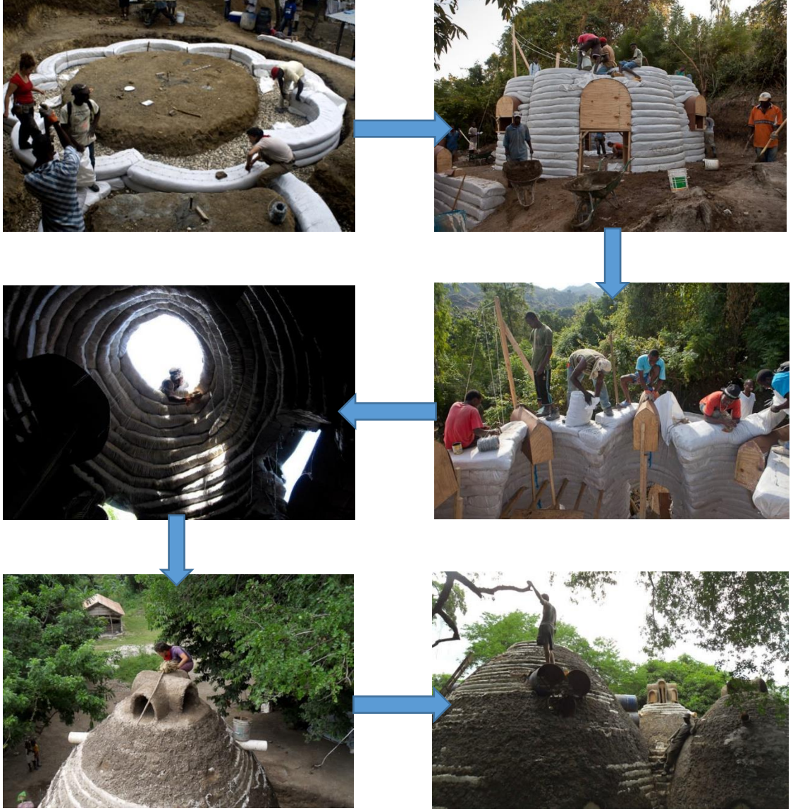
Şekil 3.8. Konbit barınağı yapım aşamaları (Anonim 2019d)
