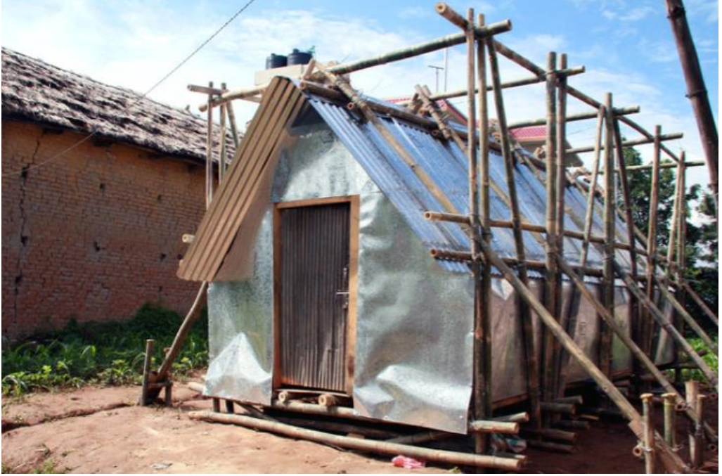
Şekil 3.11. Nepal'deki deprem sonrası halkın katılımıyla yapılan barınma birimi (Anonim 2017a)
