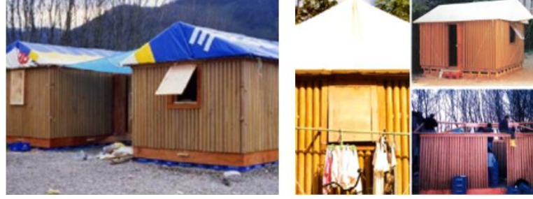
Şekil 3.57. Düzce’de yapılmış geçici barınma birimleri (Bektaş 2004)
