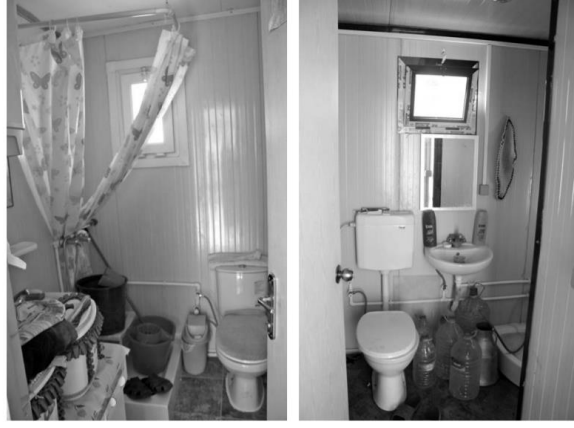
Şekil 3.62. Anadolu konteynır kentindeki geçici barınma birimleri banyo görselleri (Ünal 2017)
