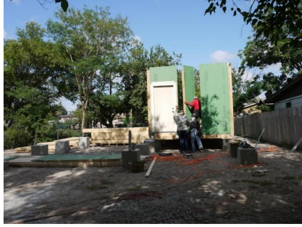
Şekil 3.23. Rapido geçici barınma inşa süreci (Anonim 2021g)
