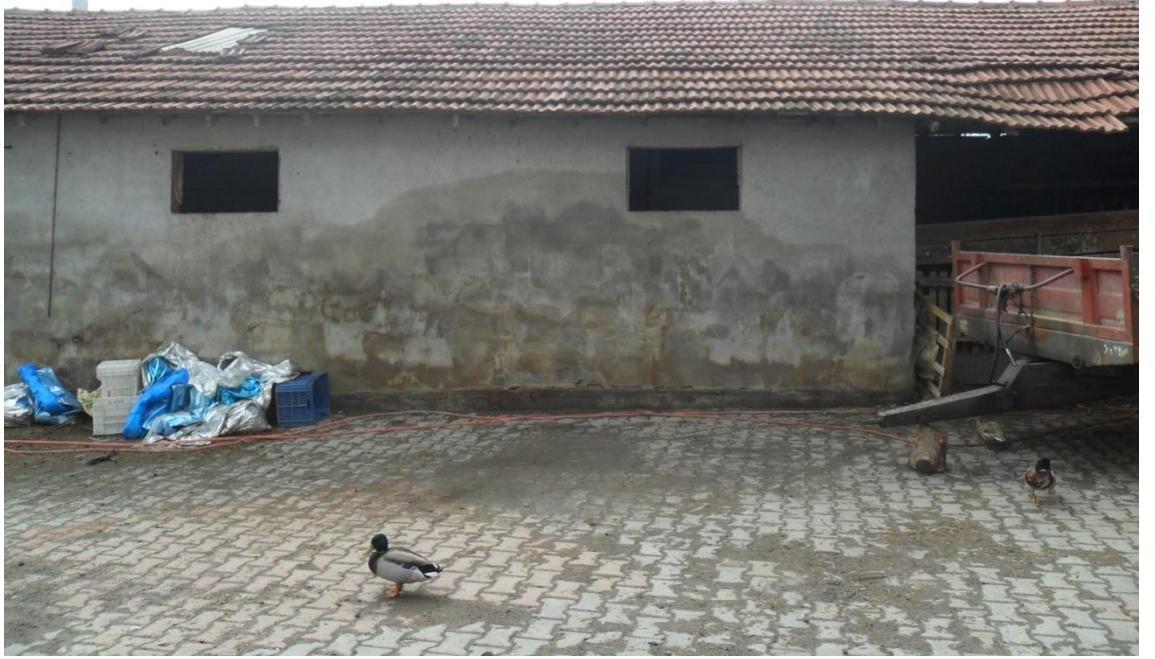
Şekil 4.7. Ağıl yan duvarında bırakılmış boşluklar
