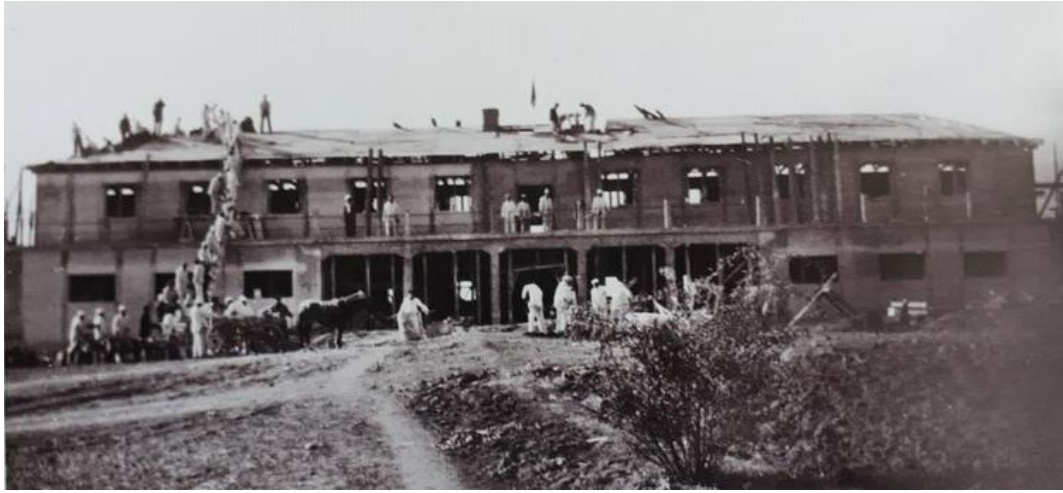
Şekil 3.16. Merkez bina (1 numaralı yapı) eğitmen adayları tarafından inşa edilirken (Aydoğan 2015)
