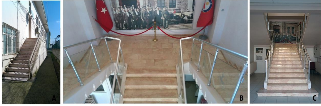
Şekil 4.11. “Merkez bina” (1 numaralı yapı) merdivenleri A) Enstitü döneminde meydana yapıya ulaşılan merdiven B) Yapının içerisindeki merdiven C) Yapının içerisindeki merdiven (Savaş 2020)
