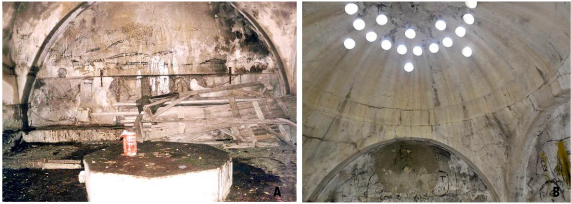
Şekil 3.21. Öğrencilerin inşa ettikleri hamam (44 numaralı yapı) A) Özgün halinde mermer kaplı olan göbek taşı 2018 yılına ait fotoğrafı B) Hamamdaki ışıklık tasarımı 2018 yılına ait fotoğrafı (Karabey Aydoğan Arşivi)
