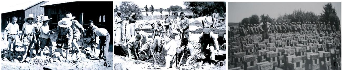
Şekil 2.17. A) Köy Enstitülerinde tuğla hamurunun çignenmesi B) Köy Enstitülerinde tuğla hamurunun karılması C) Göl Köy Eğitim Kursu öğrencilerinin ürettiği enstitü yapılarında kullanılan tuğlalar (Anonim 2012)
