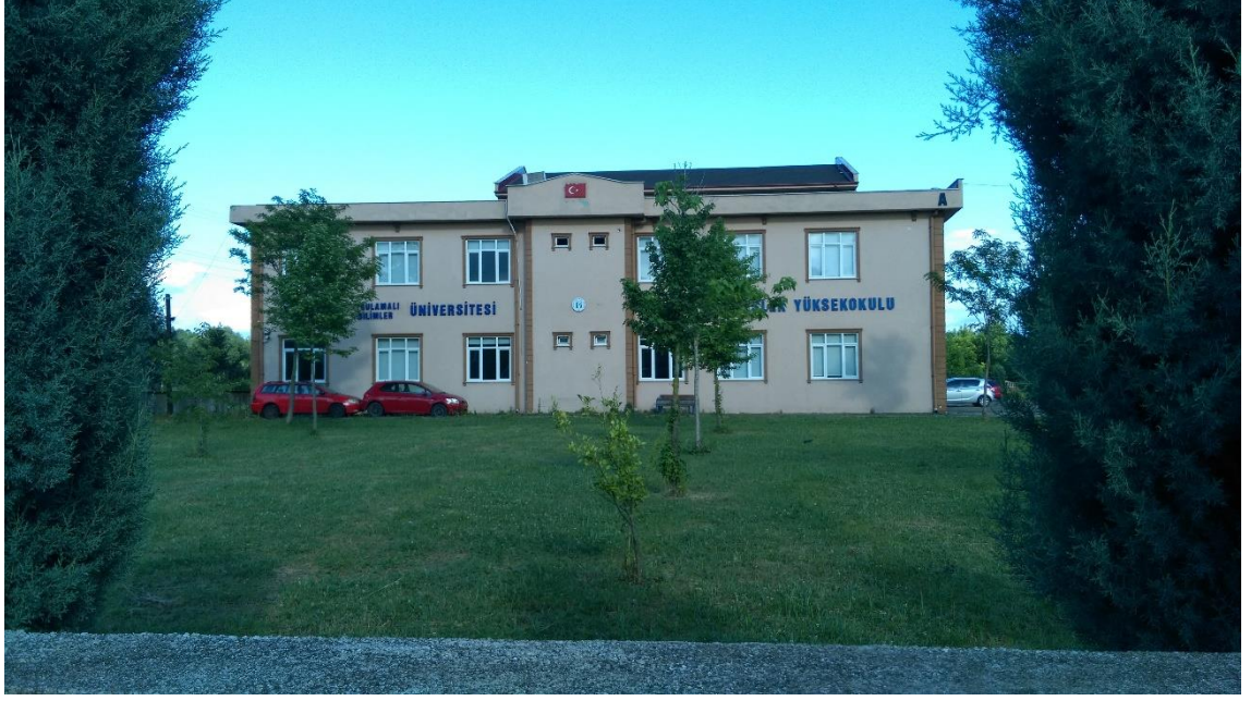
Şekil 4.55. 35 numaralı üniversite binası (Savaş 2020)
