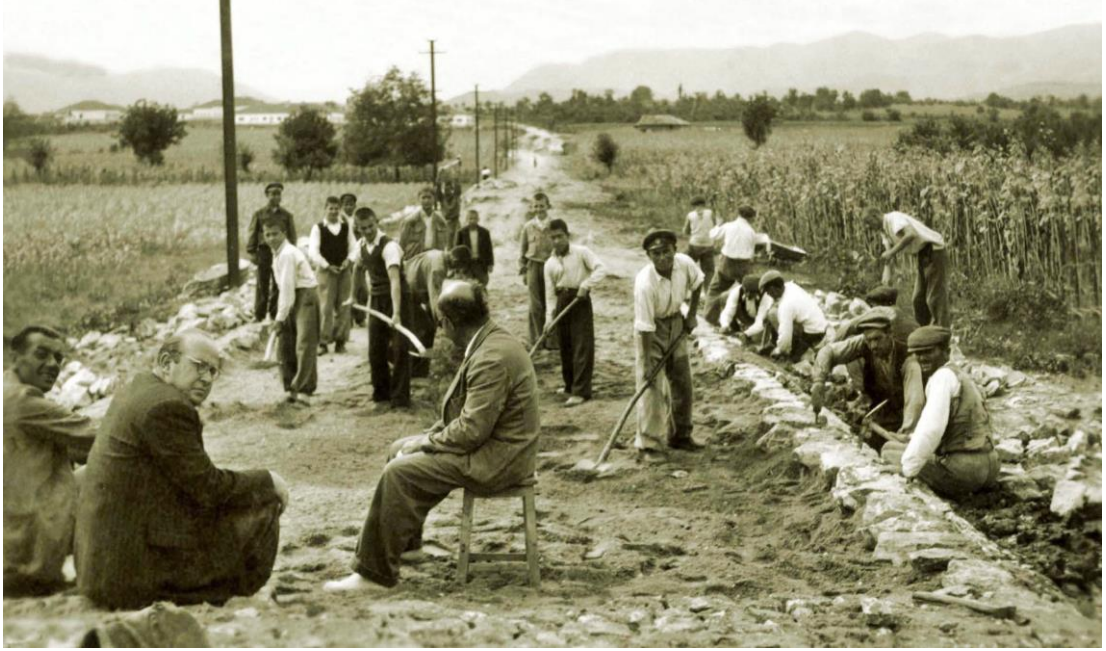
Şekil 3.18. Alan 1 ve Alan 2 yerleşkeleri arasındaki yol yapımı (Karabey Aydoğan Arşivi)
