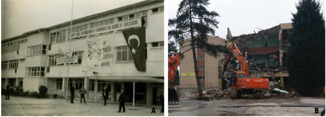
Şekil 4.48. A) Arifiye Öğretmen Lisesi binası B) Arifiye Öğretmen Lisesinin yıkımı 2018 yılı fotoğrafı (Gül Aygün Arşivi)
