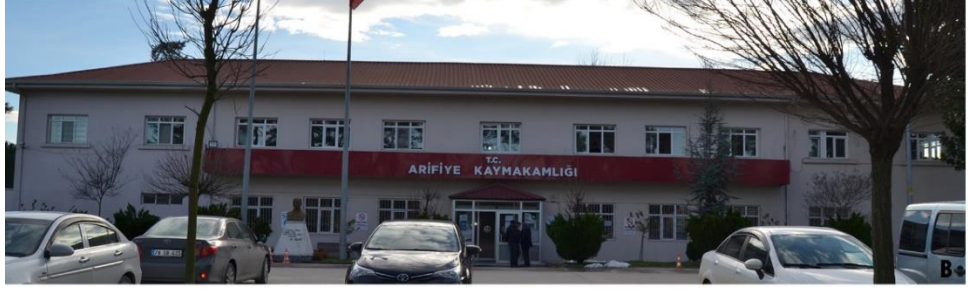
Şekil 4.8. A) Eğitimci adayları tarafından inşa edilen “merkez bina” (1 numaralı yapı) (Karabey Aydoğan Arşivi) B) Arifiye Kaymakamlık binası (Savaş 2021)
