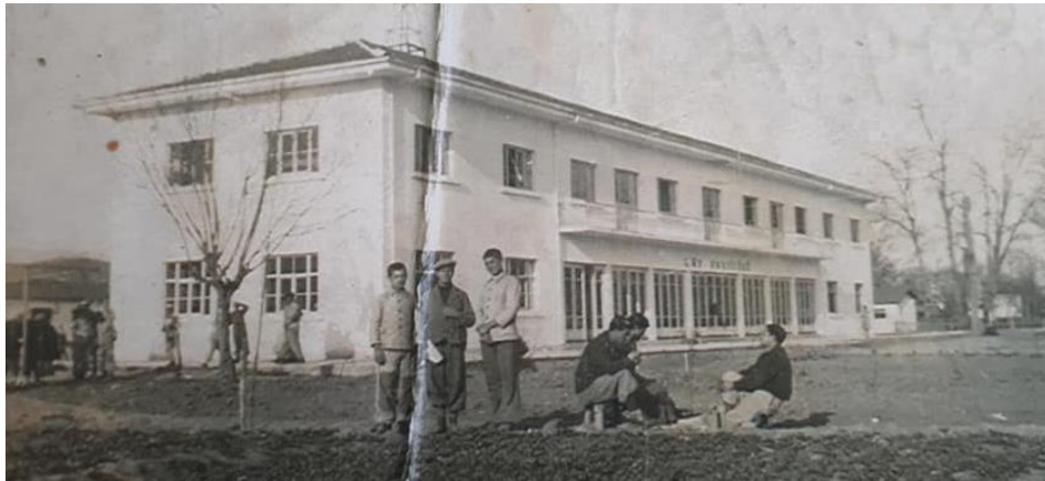
Şekil 4.12. Arifiye Köy Enstitüsünde “merkez bina” (1 numaralı yapı) (İşsever 2019)
