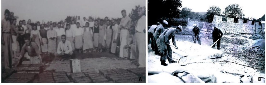
Şekil 3.17. A) Arifiye Eğitim Kursu kerpiç üretimi 1937 yılı (Aydoğan 2015) B) AKE kireç söndürme işlemi (Anonim 2012)
