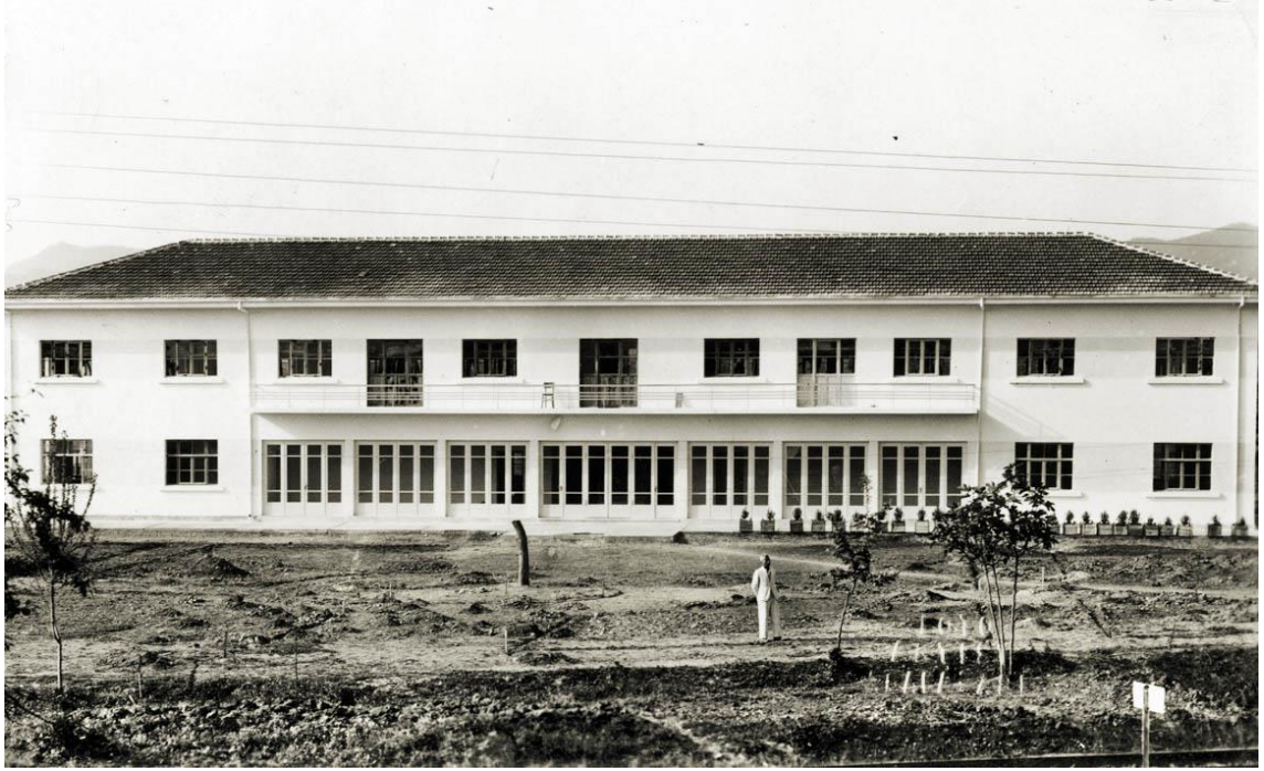
Şekil 3.15. Eğitimciler tarafından inşa edilen “merkez bina” (1 numaralı yapı) (Karabey Aydoğan Arşivi)
