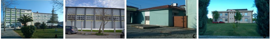
Şekil 4.32. AKE Eğitim Kursu Alanı (Alan 1) 1990-2020 yılları arasında inşa edilen 32, 33, 34 ve 35 numaralı yapıların günümüzdeki durumu (Savaş 2021)
