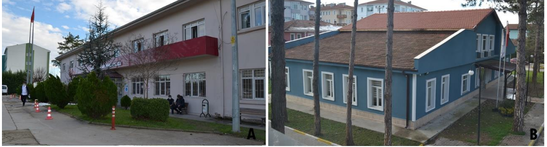
Şekil 4.30. AKE Eğitim Kursu Alanı (Alan 1) A) Eğitim Kursu döneminde inşa edilen 1 numaralı yapının günümüzdeki durumu B) Köy Enstitüsü döneminde inşa edilen 14 numaralı yapının günümüzdeki durumu (Savaş 2021)
