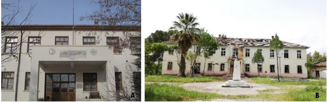
Şekil 2.16. A) Hasanoğlan Yüksek Köy Enstitüsü binası hitap balkonu (Baysal 2012) B) Ortaklar Köy Enstitüsü idare binası (Çetin ve Kahya 2017)
