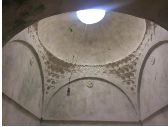
Yıldırım Hamamı sıcaklık kubbesi
