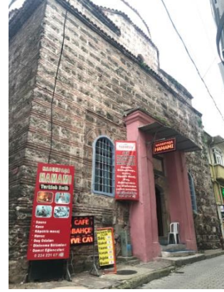
Nasuhpaşa Hamamı giriş cephesi
