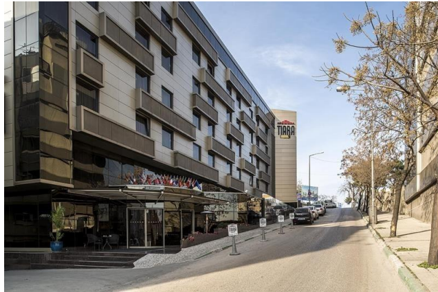
Tiara Hotel &amp; SPA genel görünüm
