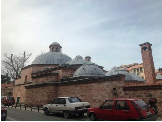
Mahkeme Hamamı güney cephesi
