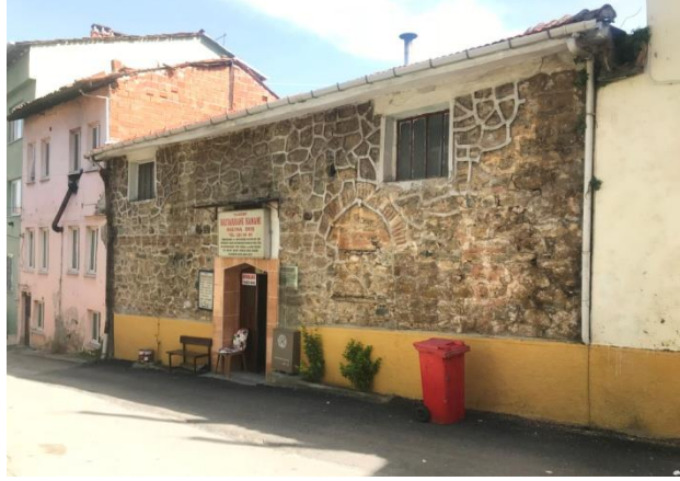
Haydarhane Hamamı giriş cephesi
