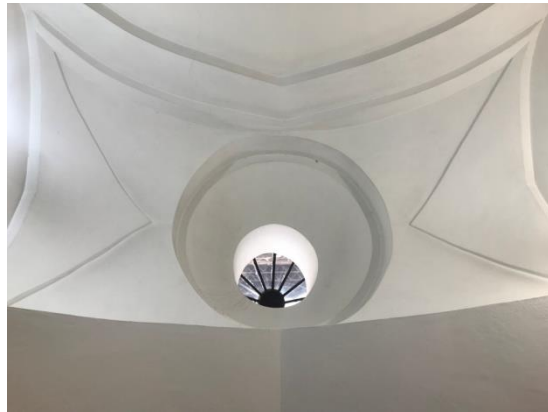
Perşembe Hamamı sıcaklık eyvanı örtüsü
