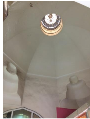
Şengül Hamamı sıcaklık kubbesi
