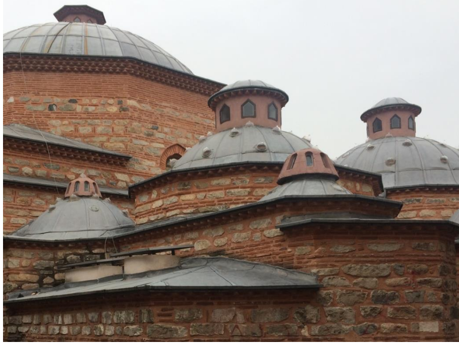
Şekil 3.5. İncirli Hamamı, çatı feneri ve filgözleri
