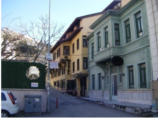
Boyugüzel Kaplıcası'nın içinde yer aldığı Boyugüzel Termal Oteli, Selvi Sokak'tan giriş
