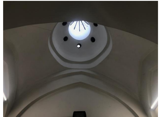
Perşembe Hamamı sıcaklık eyvanı örtüsü
