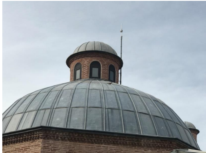
Şekil 3.4. Mahkeme Hamamı, çatı feneri örneği
