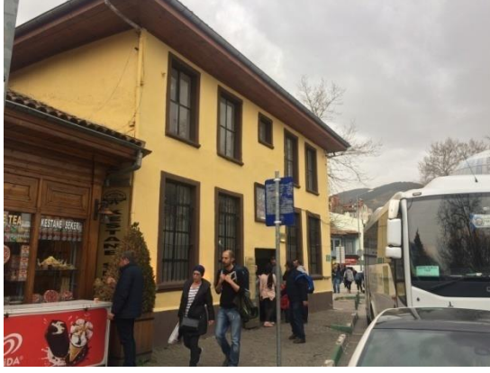
Yeşil Hamamı giriş cephesi
