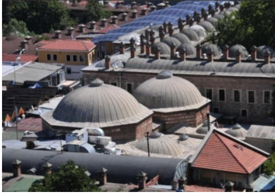
Orhangazi Hamamı batı yönünden bakış
