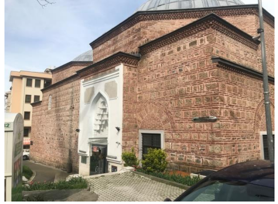
Mahkeme Hamamı güneydoğu yönünden görünüş
