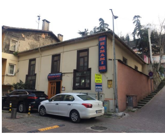
Yahudiler Hamamı giriş cephesi
