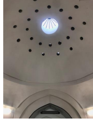
Perşembe Hamamı sıcaklık kubbesi
