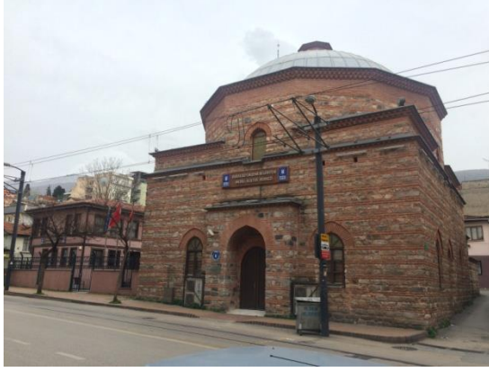
İncirli Hamamı giriş cephesi
