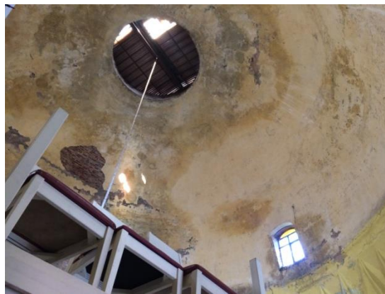
Bitpazarı Hamamı soyunmalık kubbesindeki aydınlık feneri
