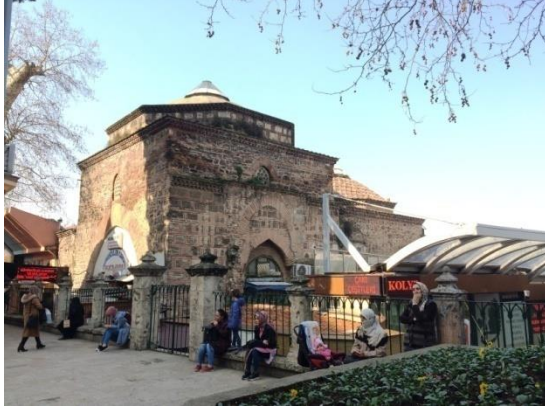
Şengül Hamamı güneydoğu yönünden görünüm
