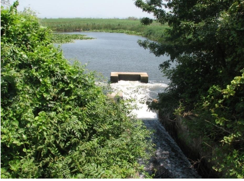
Şekil 3.5. Ulubat Pompa İstasyonu 3. istasyon pompanın bulunduğu yerin görünümü
