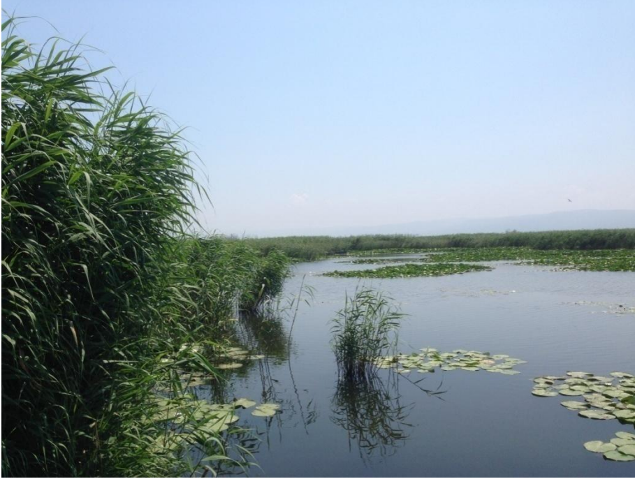
Şekil 3.4. Ulubat Pompa İstasyonu 3. istasyon genel görünümü
