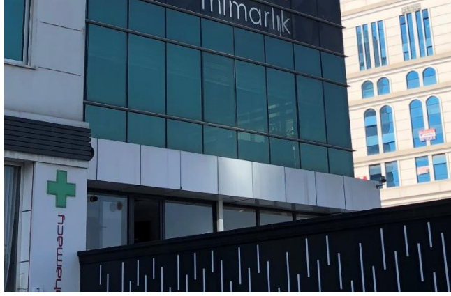
Şekil 4.37 Şentürkler İş Merkezi – Yüzey Kirlenmesi
