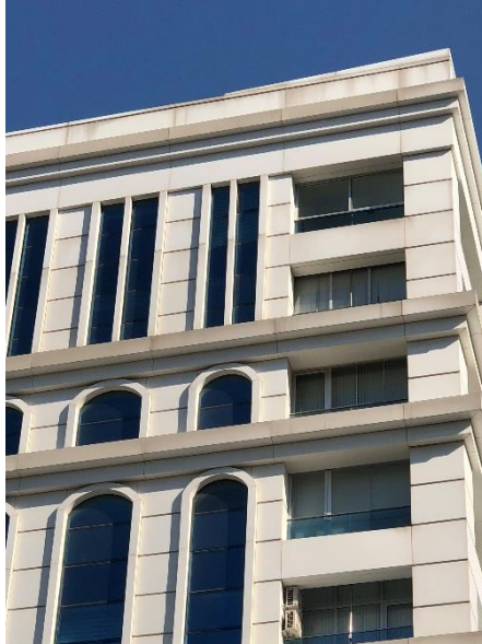
Şekil 4.32 Kızılay Plaza- Yüzey Kirlenmesi ve Lekelenmesi
