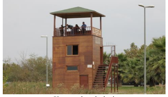
Kuş gözlem kulesi
