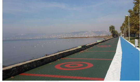
Şekil 4.111. Sahil boyunca devam eden güvenlik betonu (Fotoğraf Ziynet Yiğit 2018)
