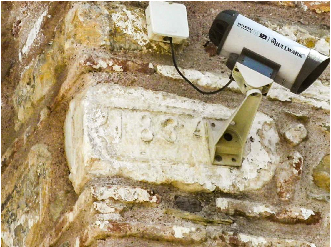
Şekil 53: Tirilye Ayios Yeoryios Kilisesi Güney Duvarı Batı Köşesinde Üzerine 1834 Tarihi Kazınmış Kesme Taş
