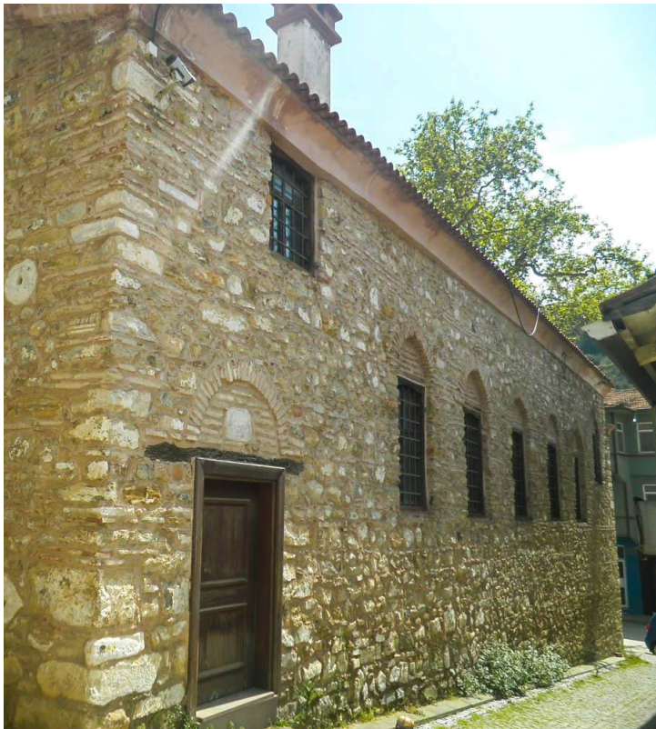
Şekil 55: Tirilye Ayios Yeoryios Kilisesi Güney Cephe Görünümü (2019).
