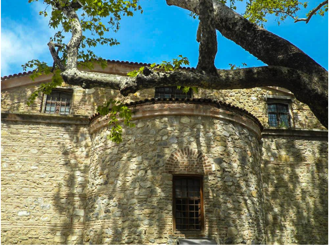
Şekil 56: Tirilye Ayios Yeoryios Kilisesi Doğu Cephe Görünümü (2019).
