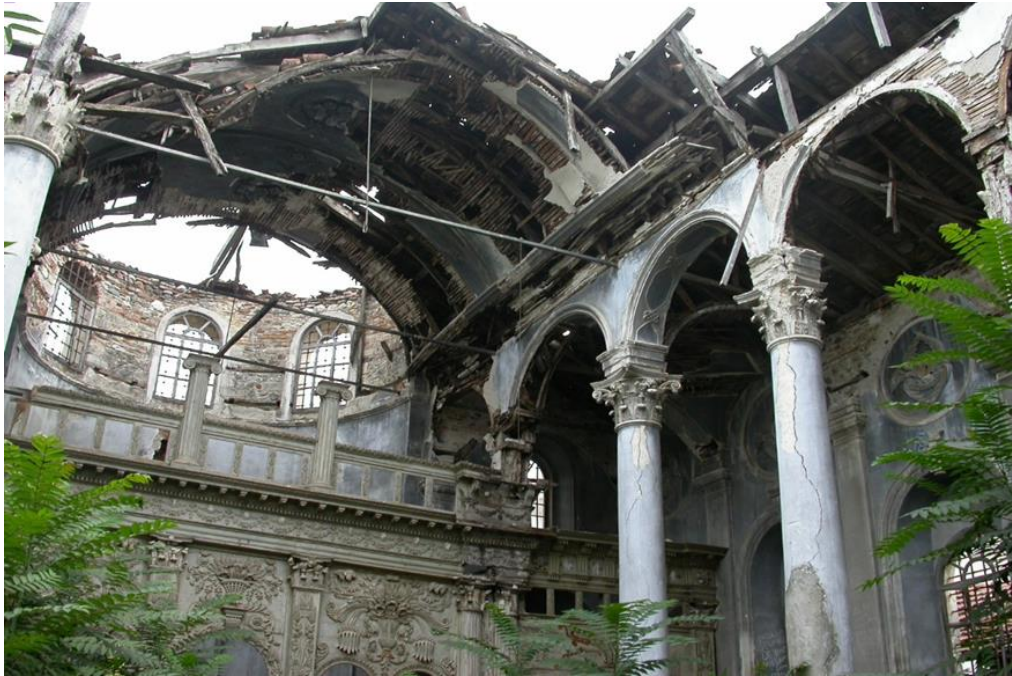
Şekil 41: Dereköy Ayia Paraskevi Kilisesi Günümüze Ulaşmayan Naos Sütunları ve Orta Nefin Beşik Tonozu (Sacit Pekak Arşivi, 2004).
