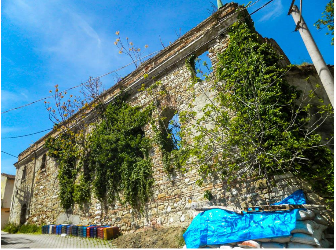
Şekil 19: Aydınpınar Ayios Ioannes Kilisesi Güney Cephe Görünümü (2019).
