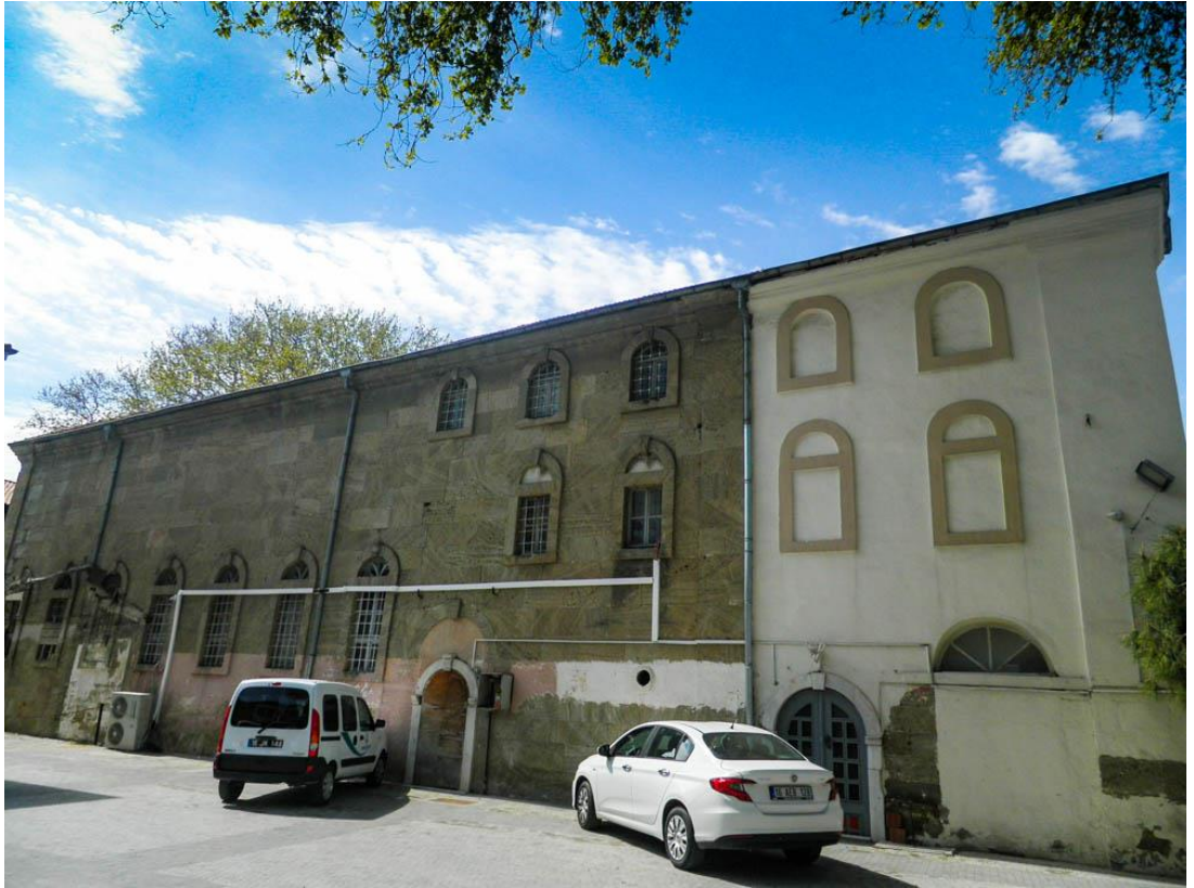
Şekil 6: Mudanya Ayios Yeoryios Kilisesi Kuzey Cephe Görünümü (2019).
