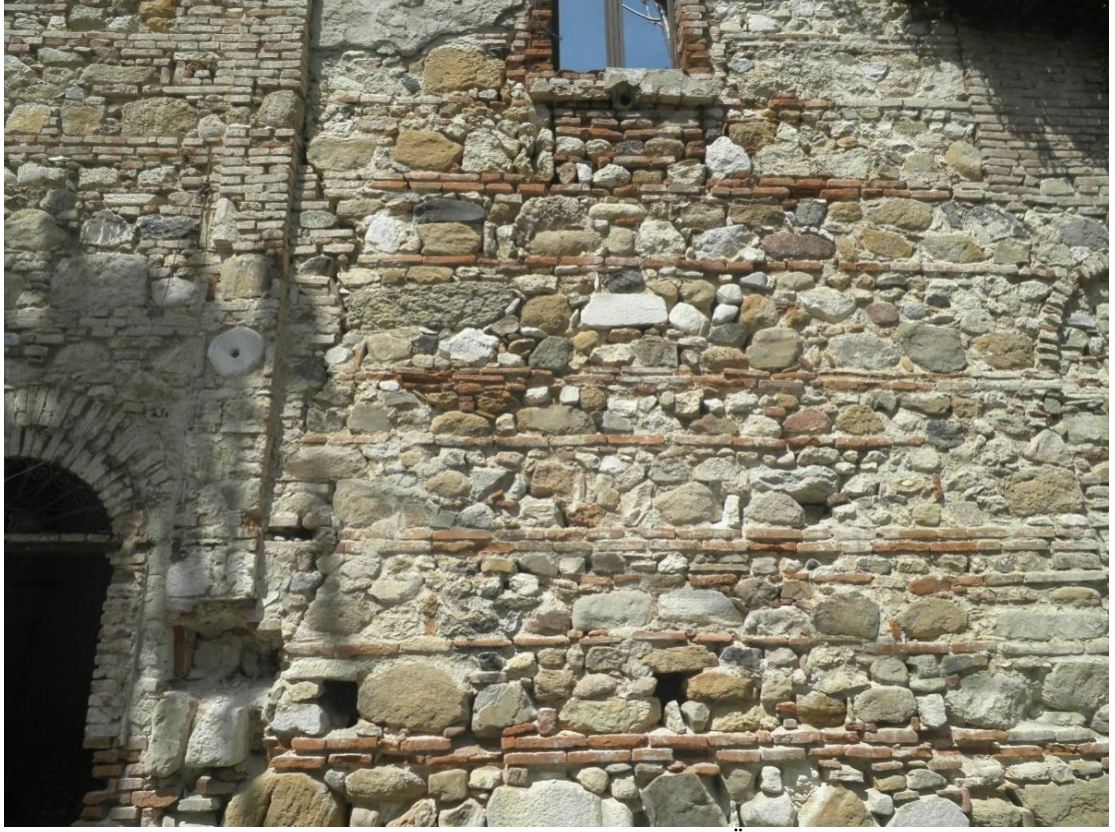
Şekil 24: Aydınpınar Ayios Ioannes Kilisesi Güney Duvar Örgüsü Detay (2019).
