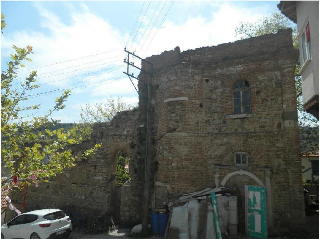
Şekil 64:Tirilye Ayios Ioannes Kilisesi Kuzey Cephe Görünümü (2019).
