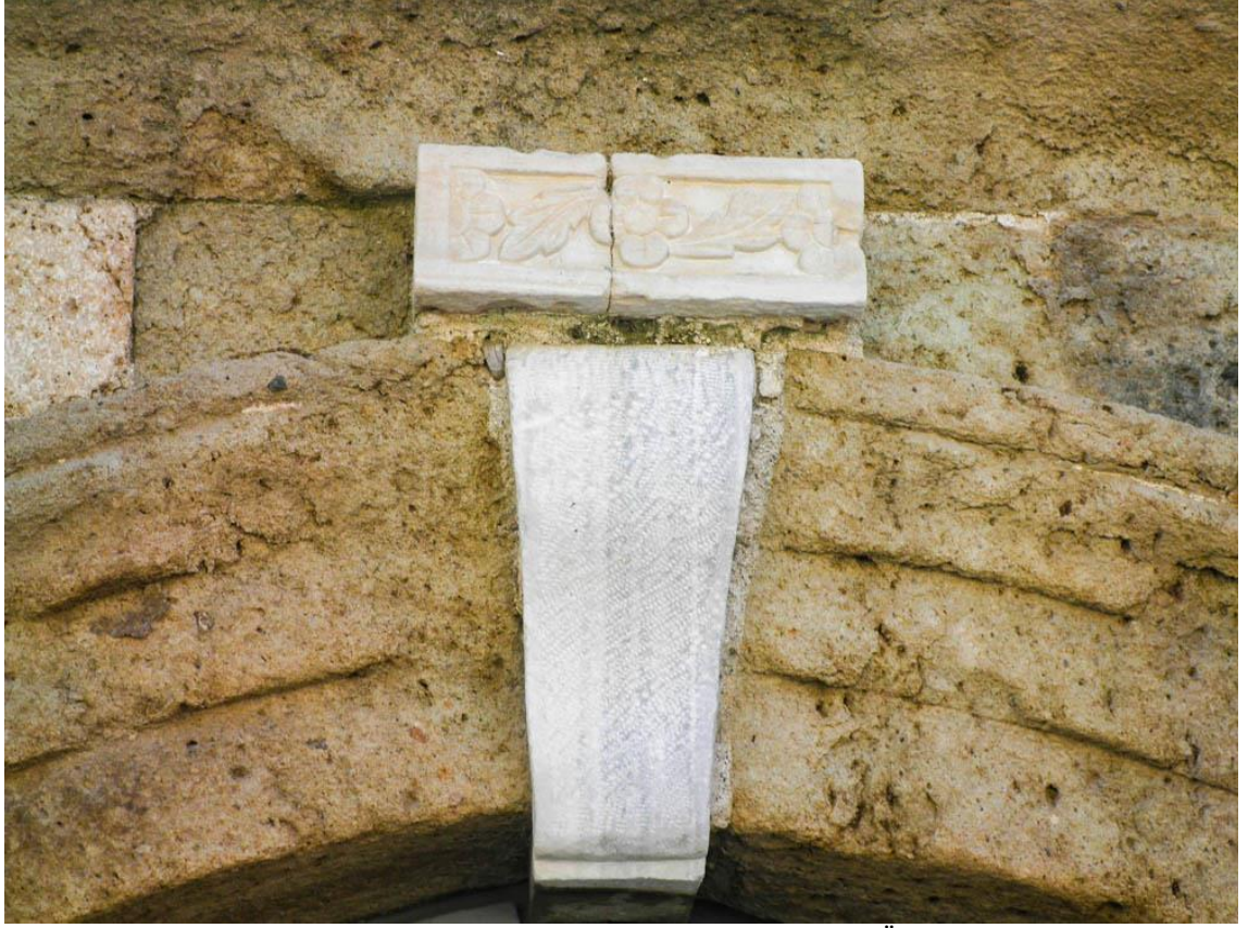
Şekil 9: Mudanya Ayios Yeoryios Kilisesi Ana Giriş Kapısı Kilit Taşı Üzerindeki Devşirme Mermer Bezeme Levhası (2019).
