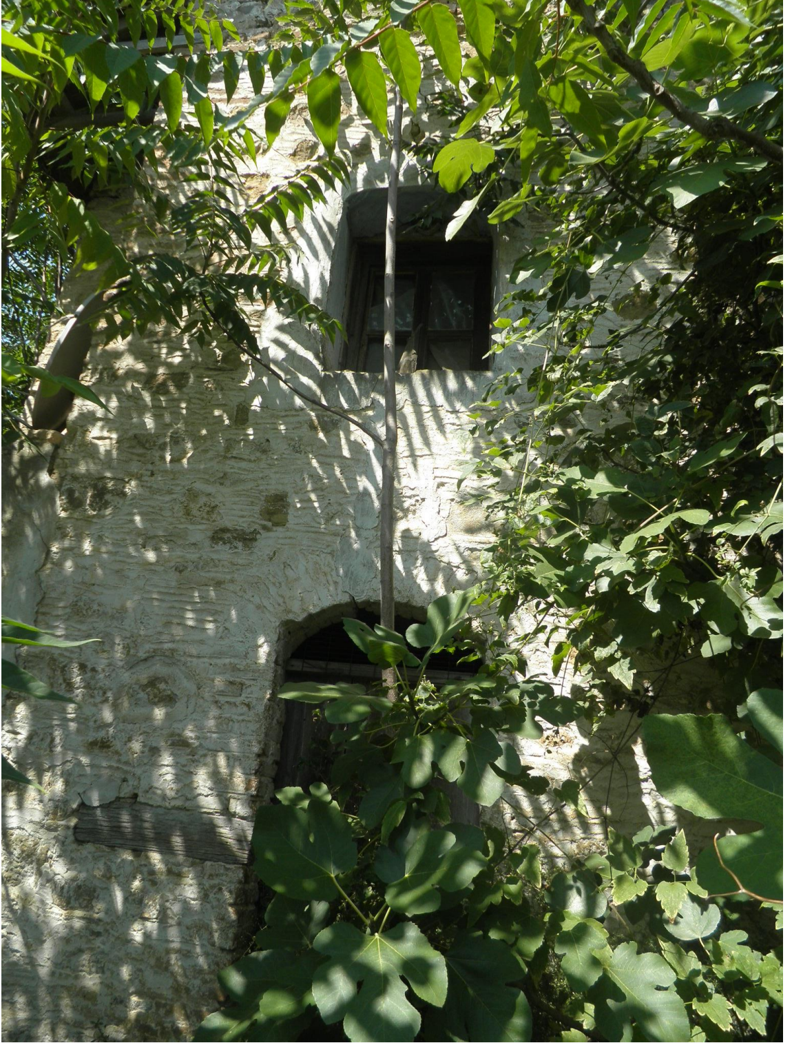
Şekil 70: Tirilye Mezarlık Kilisesi Doğu Cephe Görünümü (2019).
