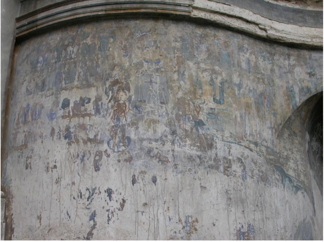
Şekil 45: Dereköy Ayia Paraskevi Kilisesi Güney Merdiven Kulesi Mahşer Sahnesi (Sacit Pekak Arşivi, 2004).
