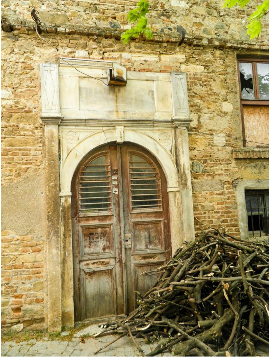
Şekil 62: Tirilye Ayios Ioannes Kilisesi Ana Giriş Kapısı (2019)
