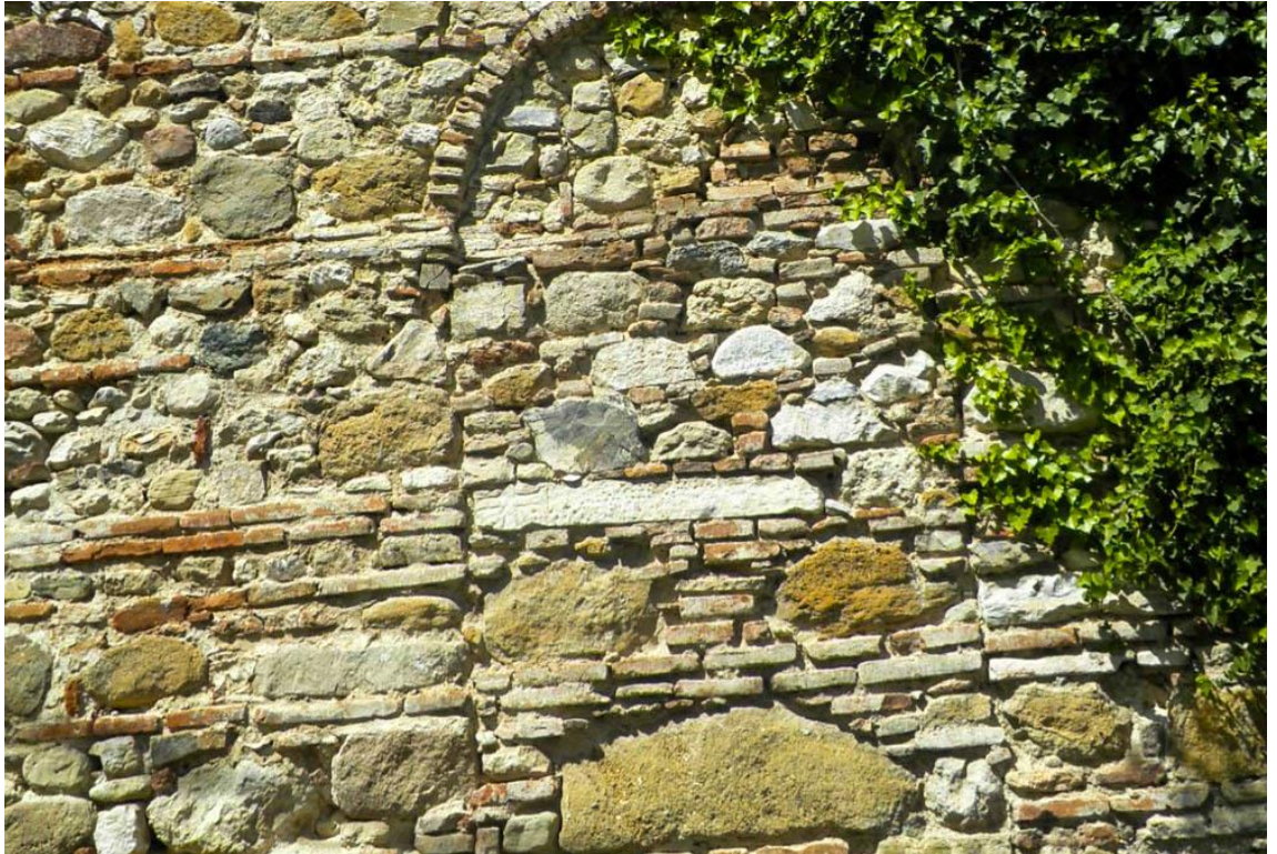
Şekil 25: Mudanya Ayios Yeoryios Kilisesi Güney Duvar Örgüsü İçindeki Kazıma Haç Motifli Devşirme Mermer Blok (2019).
