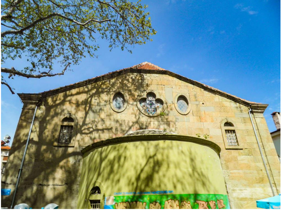
Şekil 7: Mudanya Ayios Yeoryios Kilisesi Doğu Cephe Görünümü (2019).
