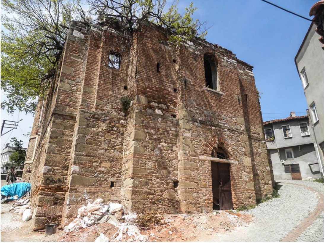
Şekil 65: Tirilye Ayios Ioannes Kilisesi Doğu Cephe Görünümü (2019).
