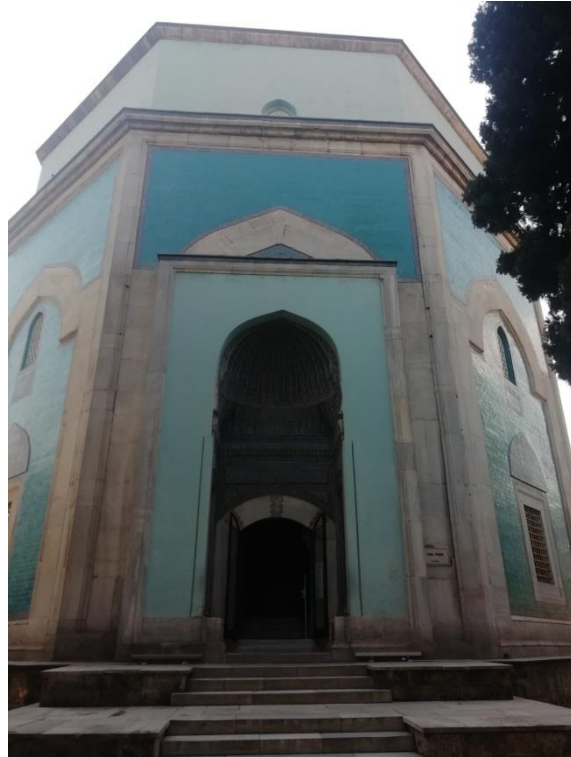
14.Resim. Bursa Yeşil Türbesi Dış Cephesi
