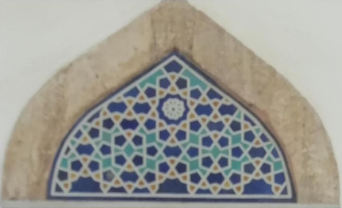
28.Resim. Bursa. Muradiye Camii Sağ Cephe İkinci Pencere Alınlığındaki Çini Levhalar
