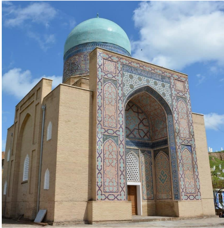
61.Resim. Semerkant. Şah-i Zinde Kadızâde-î Rumî Türbesi Dış Cephe Genel Görüntüsü
