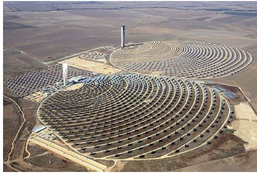
Şekil 4.8. Güneş güç kulesi (Şenol 2009).
