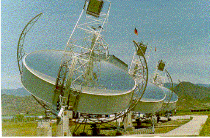
Şekil 2.17. Parabolik çanak güneş ısı elektrik santrali (İspanya)
