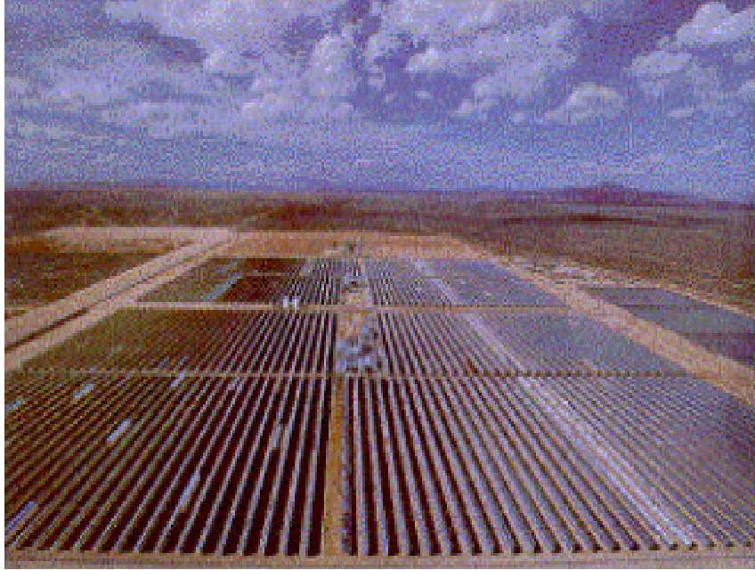
Şekil 2.14. 350 MW gücünde parabolik oluk güneş santrali-Kaliforniya
