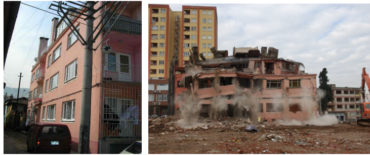
Şekil 5.7-Şekil 5.8. Alanda yer alan bir binanın yıkım öncesi ve sonrasında görüntüleri (Osmangazi Belediyesi ve TOKİ, 2010)
