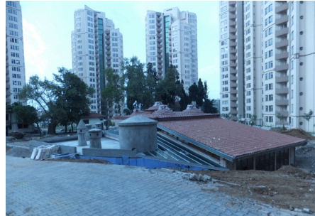
Şekil 5.24. Kiremitçi Hamamı restorasyonu
