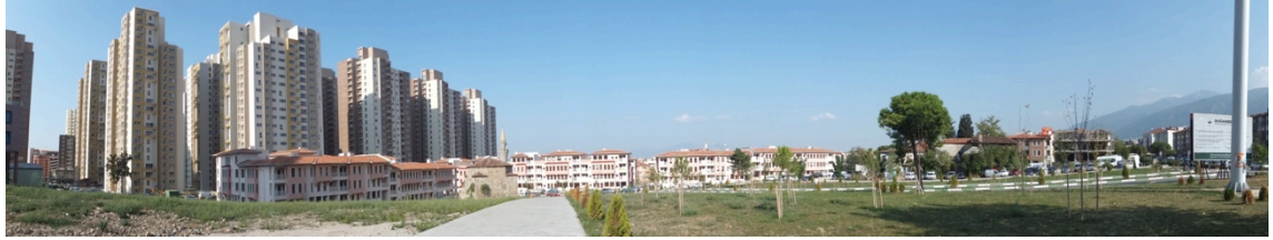
Şekil 5.3. Doğanbey Kentsel Dönüşüm Uygulaması
