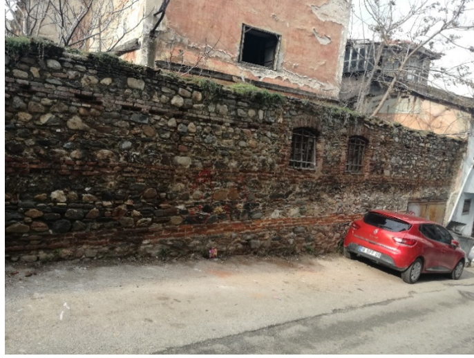
Resim 9: Doğu Cephesinde Bahçeye Açılan Kapı
