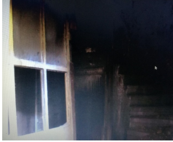
Resim 6: Yapının İçerisinde Yer Alan Merdiven Boşluğu
